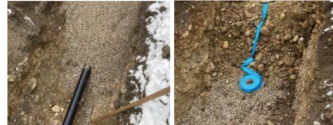
So wird's gemacht: Sorgfältig gebettet und mit Warnband markiert! (Quelle: Land Oberösterreich)
