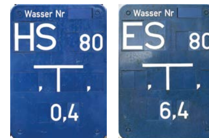
Hinweistafeln für einen Hydrantenschieber (HS) und einen Entleerungsschieber (ES) auf einer Wasserleitung mit DN 80. (Quelle: Land Oberösterreich)
