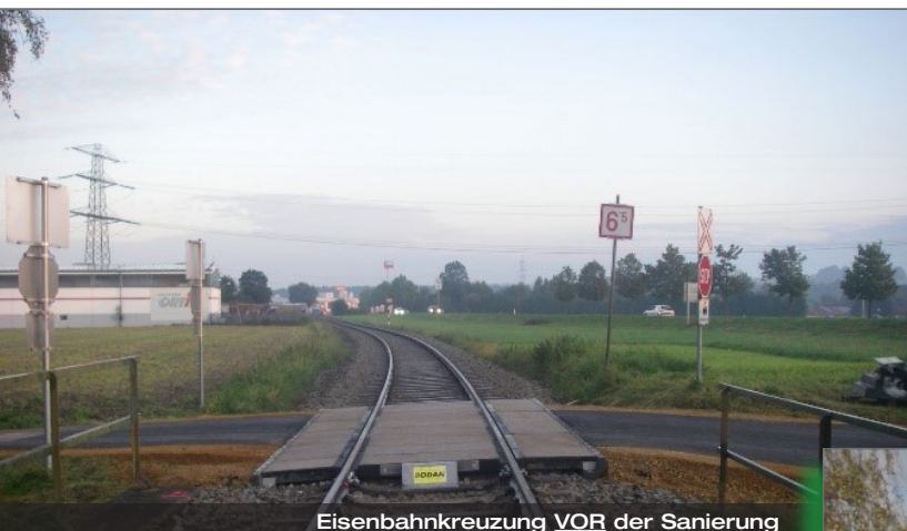
Eisenbahnkreuzung VOR der Sanierung
