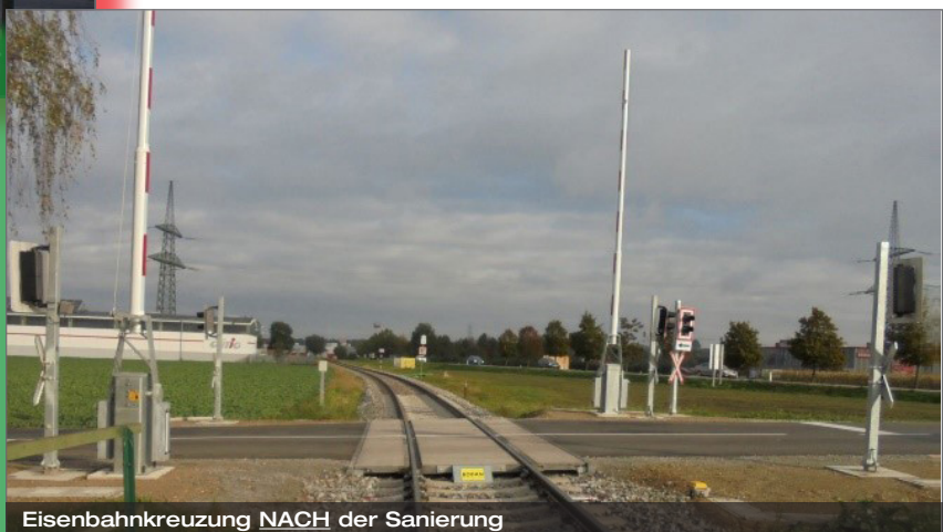
Eisenbahnkreuzung NACH der Sanierung
