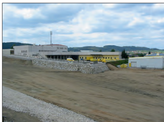
Abb. 68 Deponie Freistadt nach Abschluss
