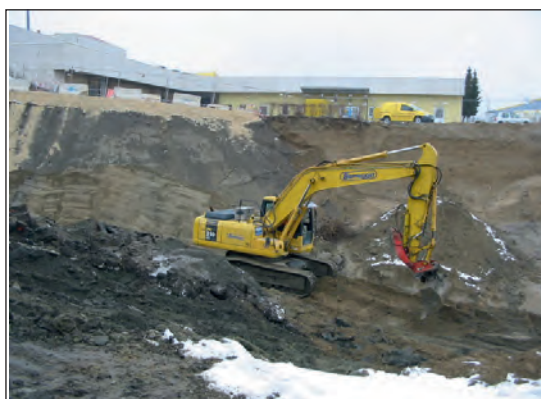
Abb. 67 Deponie Freistadt während der Räumung
