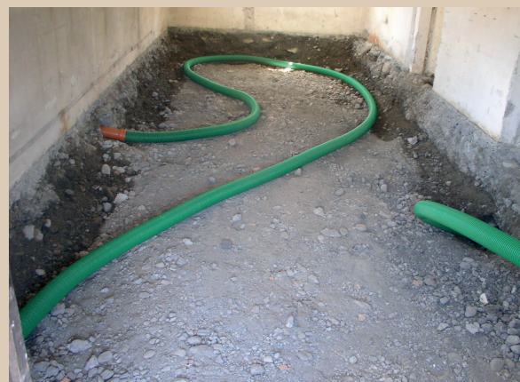
ERNEUERUNG ERDBERÜHRTER BAUTEILE
