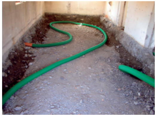
Erneuerung des Fußbodenaufbaues: Einbau einer Radondrainage.
