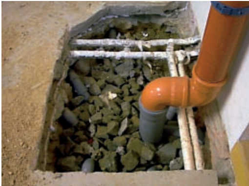
Punktueller Absaugung (Radonbrunnen) – Aushub eines Schachtes.
