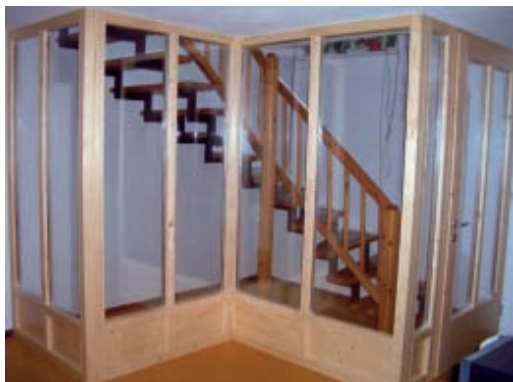
Abdichtung durch luftdichte Verkleidung des Kelleraufganges – vorher und nachher.
