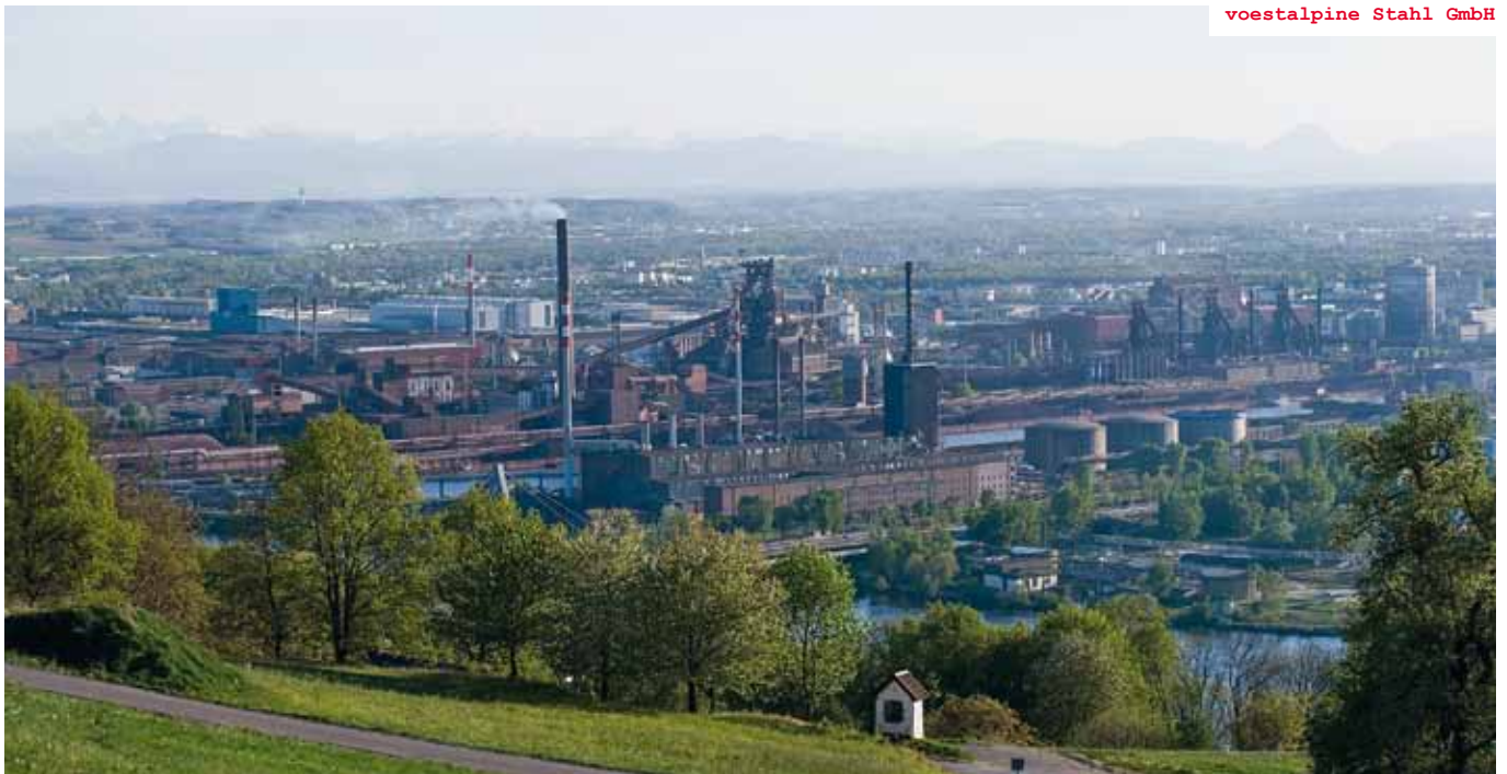
voestalpine Stahl GmbH
