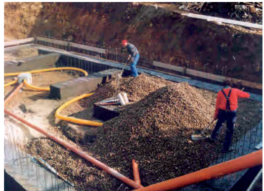
Einbau einer Radondrainage in Kies beziehungsweise Schotter
