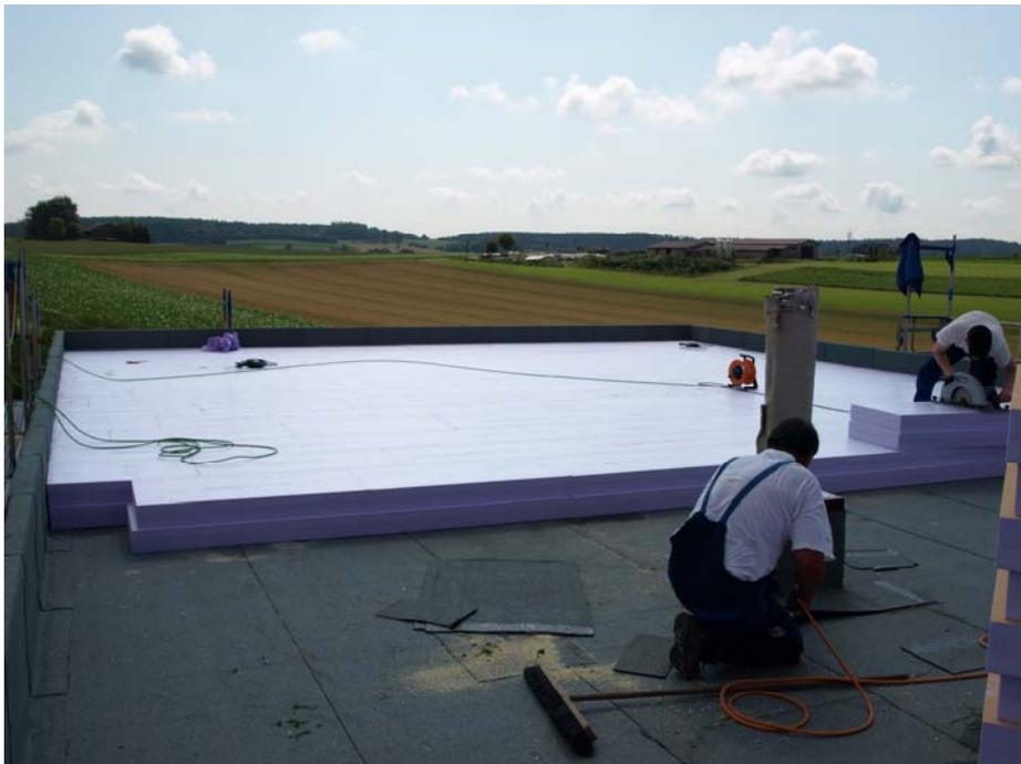
Abbildung 9-2: Lose verlegte XPS-Platten auf Umkehrdach; [www.xps-daemmung.de]
