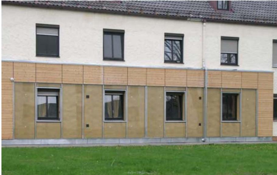
Abbildung 9-3: Vorgehängte Porenlüftungsfassade aus natürlichen Materialien; [Böhm et al., 2010]
