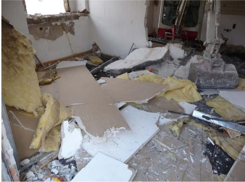
Abbildung 9-6: Gemischt anfallende Dämmstoffe bei Abbrucharbeiten [Quelle: RMA]
