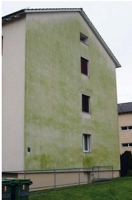
Abbildung 9-5: Von Algen und Pilzen befallene sanierungsbedürftige Wärmedämmfassade; [Burkhardt, 2006]
