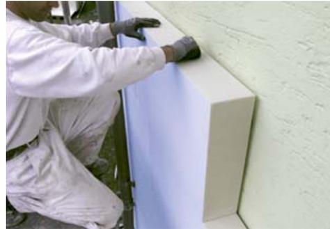
Abbildung 6-6: Montage PU-Platten; [FEMA, 2012]
