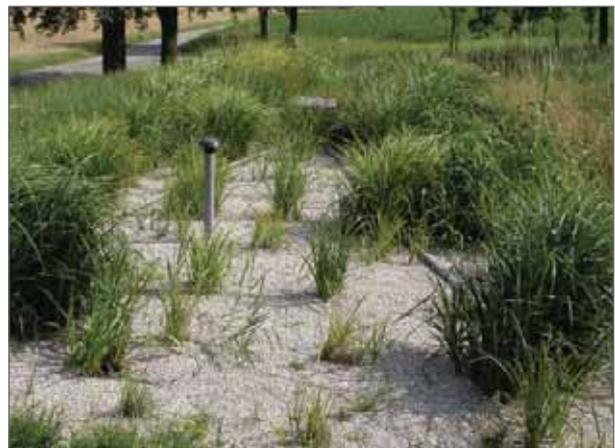
Abb. 7.3.7 - Filterbeet mit Verteilungseinrichtung (vertikal durchströmter Bodenfilter)
