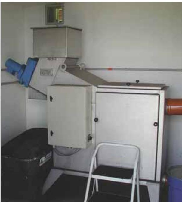
Bei den **Filteranlagen** erfolgt die mechanische Reinigung in Form eines Filtersystems, wobei im alpinen Raum auch das Filtersacksystem anzutreffen ist. Hier werden die Feststoffe in einem Filtersack zurückgehalten. Nach Vollfüllung wird das Filtergut getrocknet und einer entsprechenden Verwertung zugeführt. Eine Energiequelle ist nicht erforderlich. Eine neue Form stellen die sogenannten „Rottebehälter“ dar, die nach einem ähnlichen System arbeiten.
