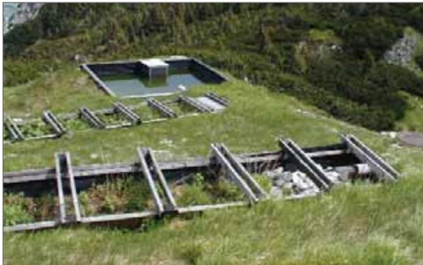
Abb. 7.3.5 - Pflanzenklärstrecke und Rezirkulations-teich (horizontal durchströmter Bodenfilter)
