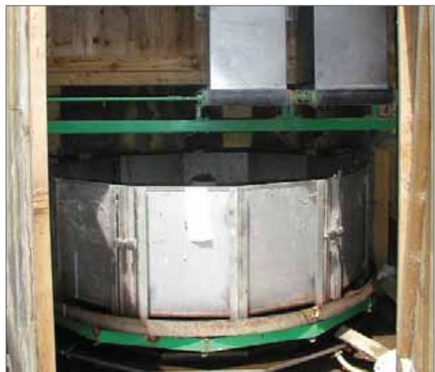
Abb. 7.3.9 - Trockentoilette-Hinteransicht (drehbarer Auffangbehälter mit Kompostzugabe)
