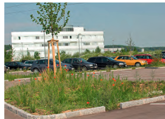
Sickermulde Stadtgut 5 Jahre nach Neuanlage.
