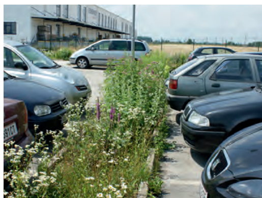
Retentionsmulde Schenker 5 Jahre nach Umgestaltung.
