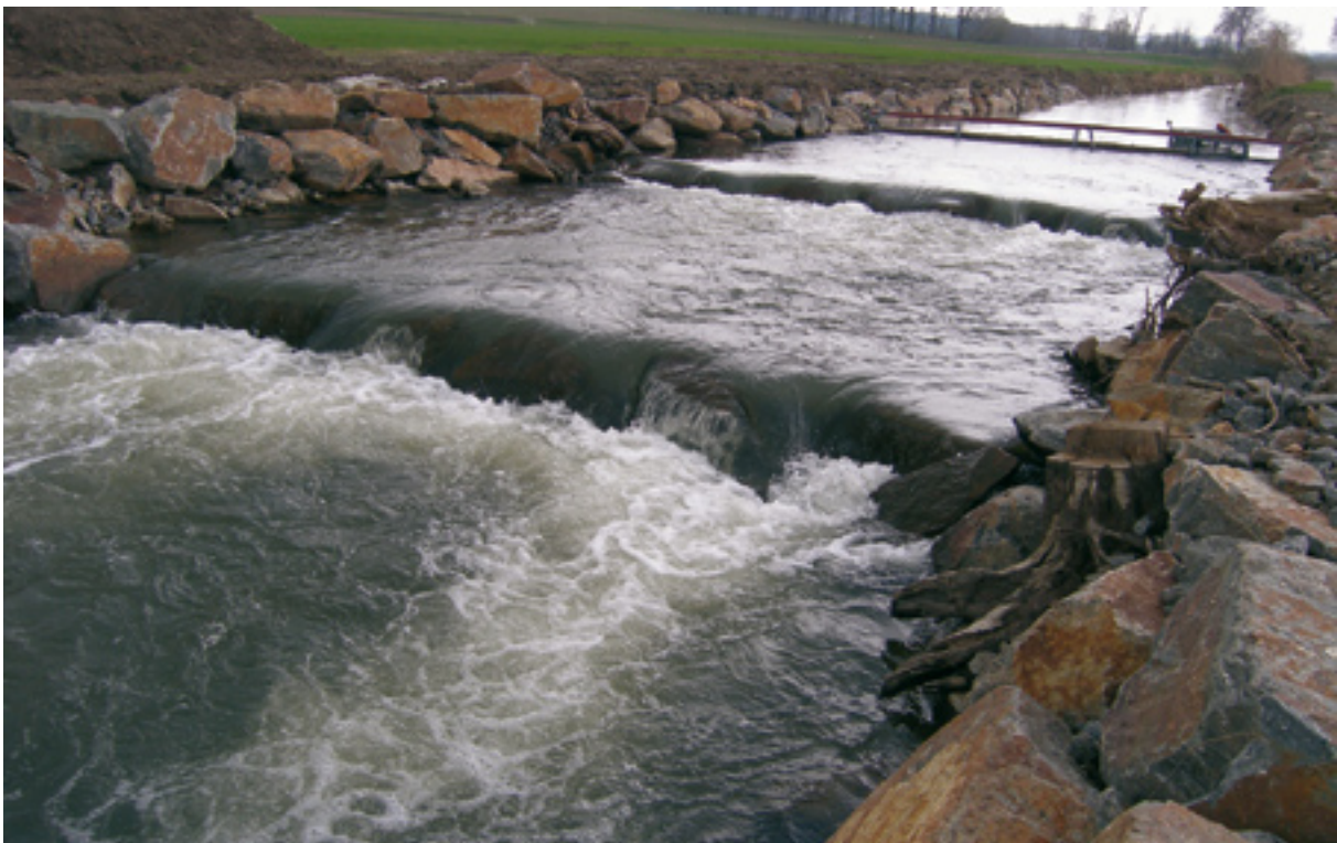
Abb. 123: Oberste Stufen, Rampe I (oben)
