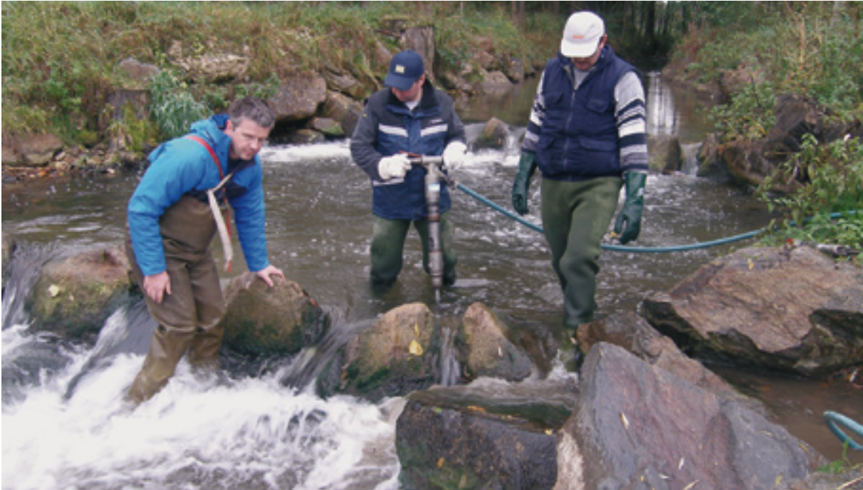
Abb. 189: Tieferlegen der Korridore im Riegel
