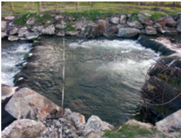
Abb. 213: Innbach, Becken 10, Profil 3
