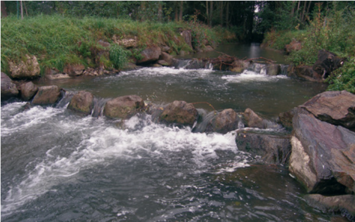
Abb. 191: obere Rampenriegel vor Bearbeitung
