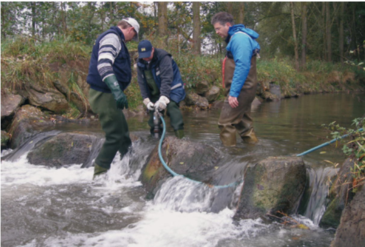
Abb. 192: Optimierung des Kronenriegels
