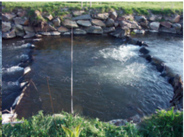
Abb. 227: Leitenbach, Rampe 1, Becken 2, Profil 3
