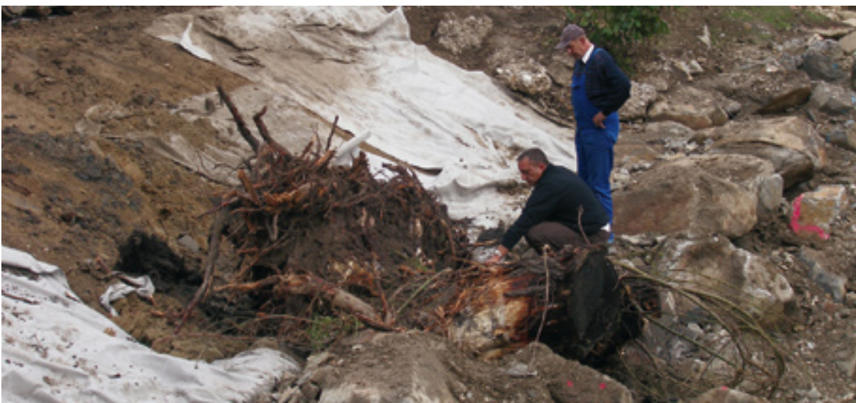
Abb. 174: Einbau eines alten Weidenstockes
