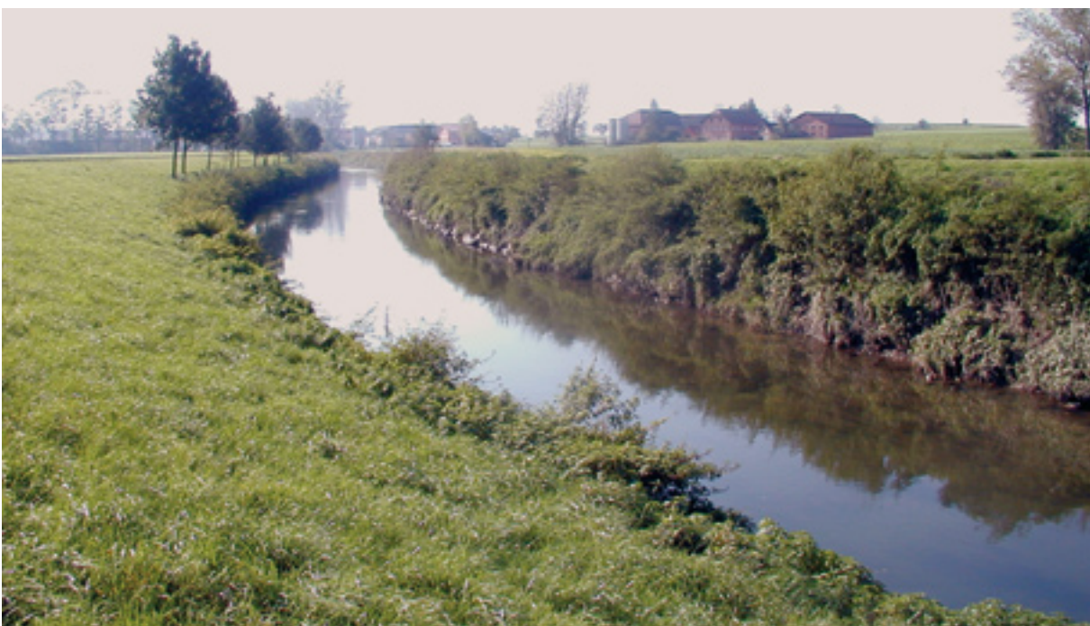
Abb. 61: Leitenbachmündung vor Umbau, Auskolkung in Aschach
