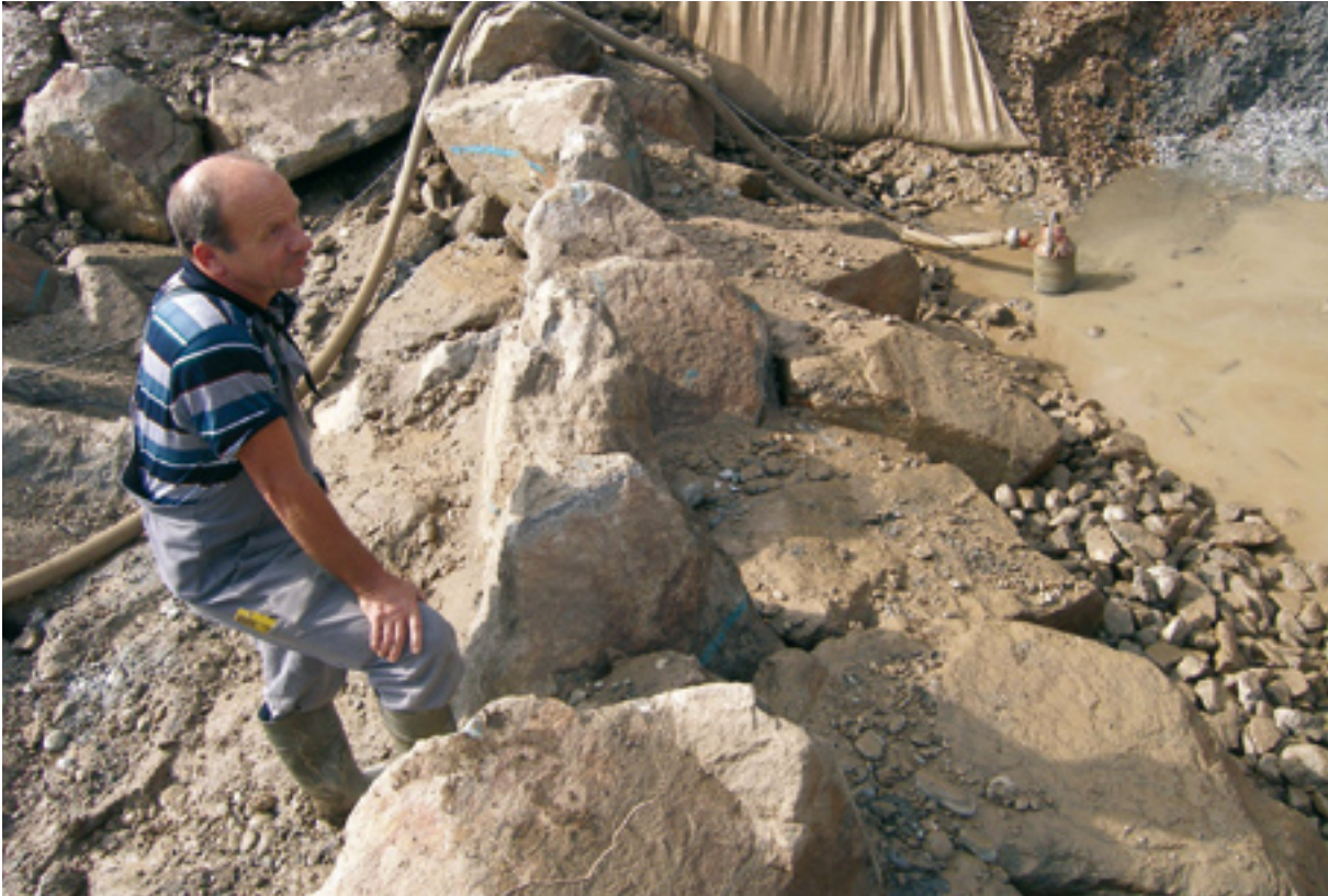
Abb. 144: Anordnung der Keilsteine
