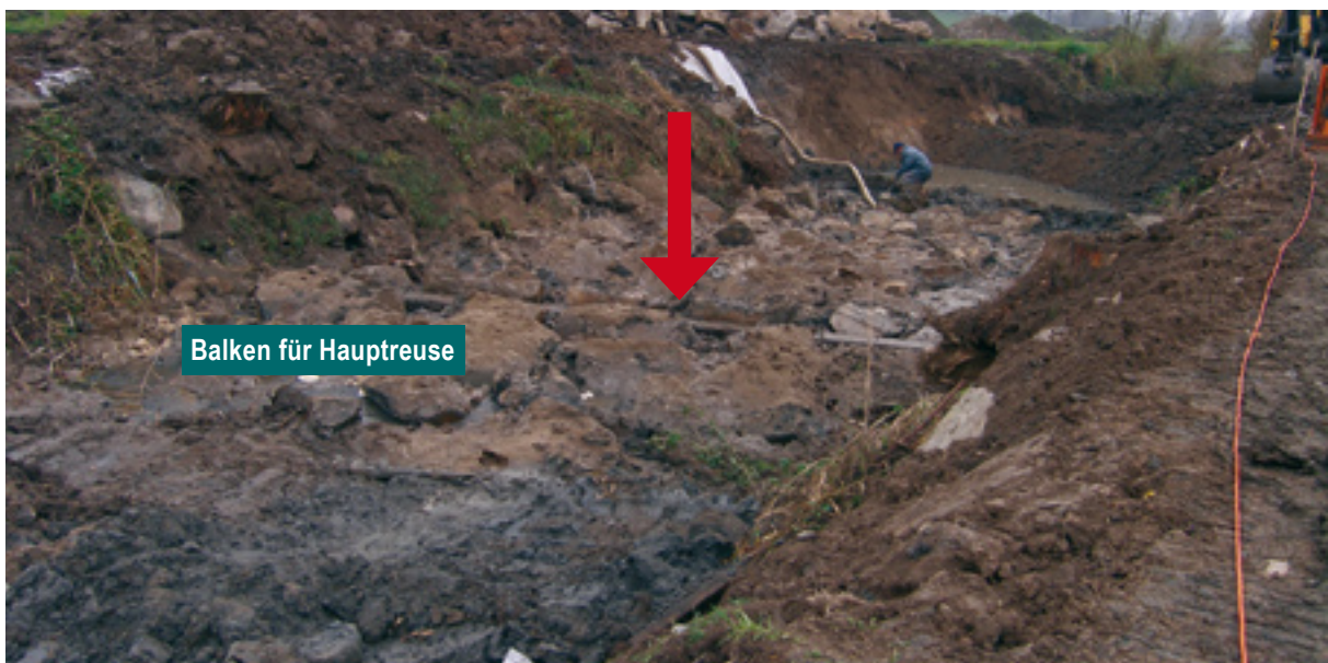
Abb. 95: Rampenzwischenstrecke mit pendelndem Abfluss, Rauigkeit und Tiefenzonierung, Böschungssicherung durch Grobsteinschichtung, Filtereinbau und darunter liegendes Bauvlies
