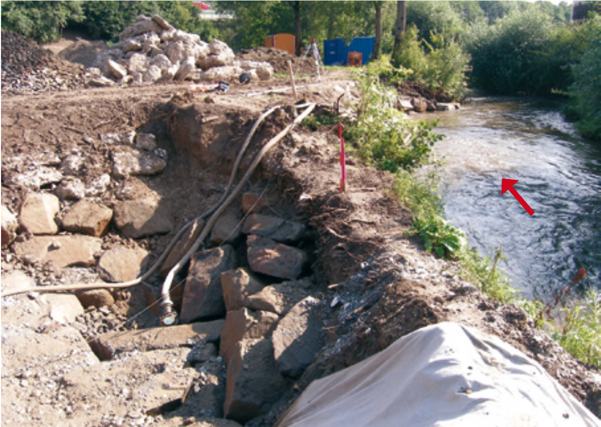
Abb. 137: Damm, Rampenbau im Trockenem
