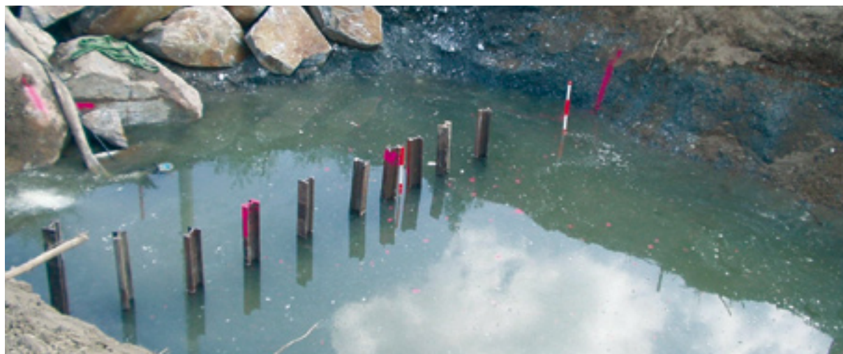
Abb. 136: Schienenkäfig am Rampenfuß (Bildquelle: Franz Scharinger, GWB Grieskirchen)
