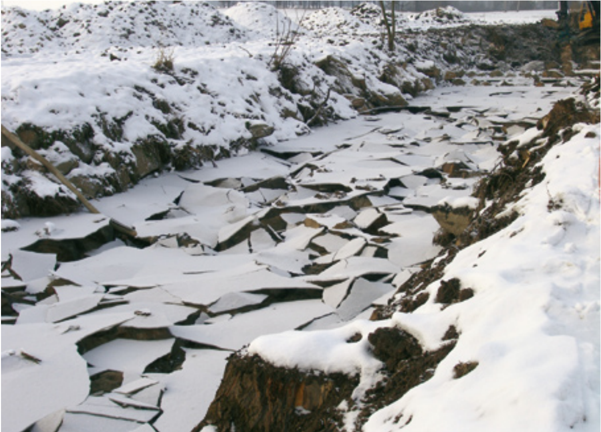
Abb. 99: Zwischenstrecke und Steinsatz der oberen Rampe
