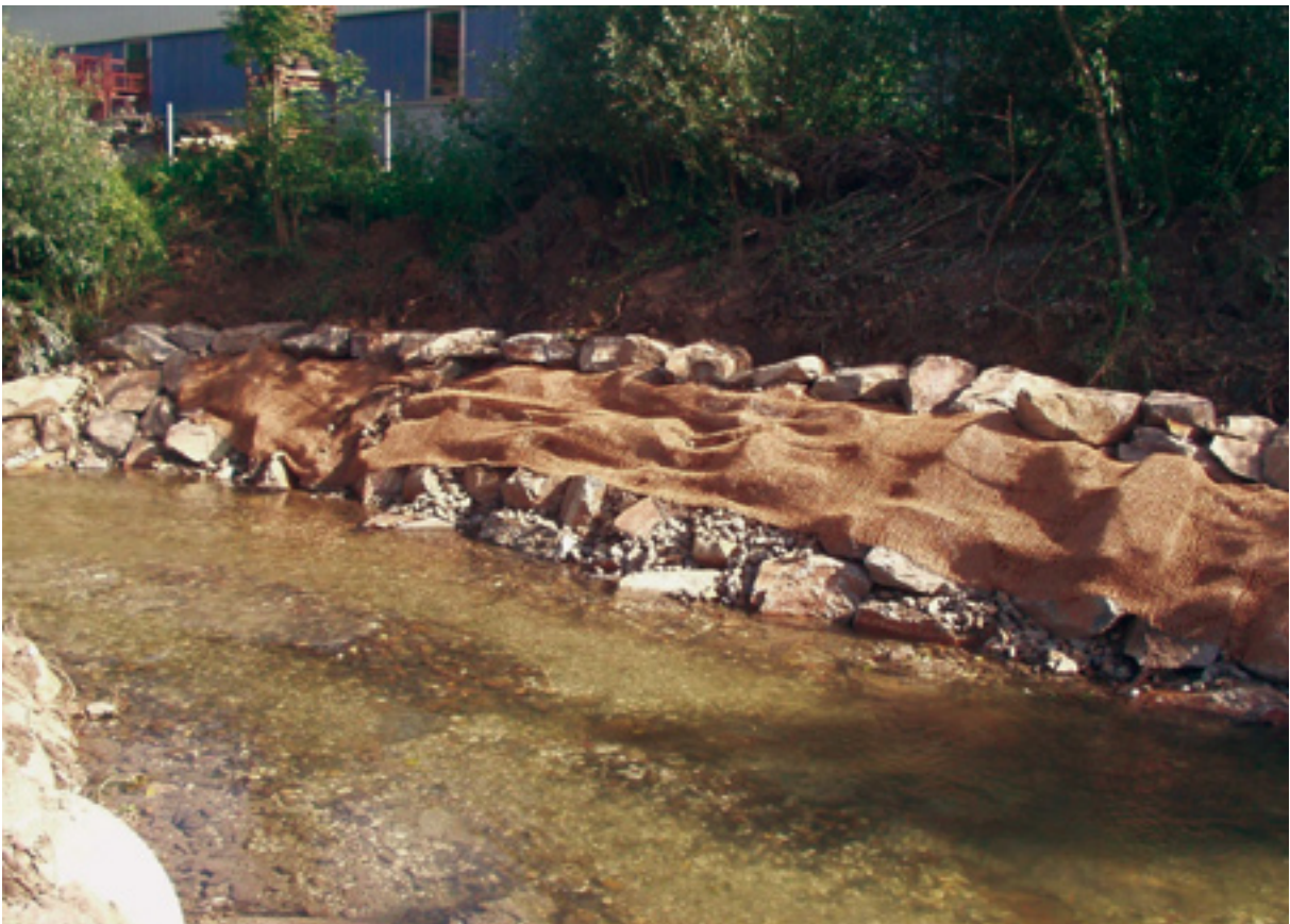
Abb. 155: Nachbettung mit abnehmender Belegungsichte der Sohlsicherungssteine (Foto: Franz Scharinger, Gewässerbezirk Grieskirchen)
