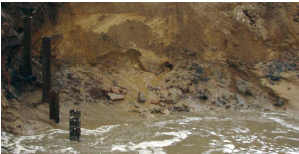
Abb. 49: Feinsedimente in Böschungen und Untergrund
