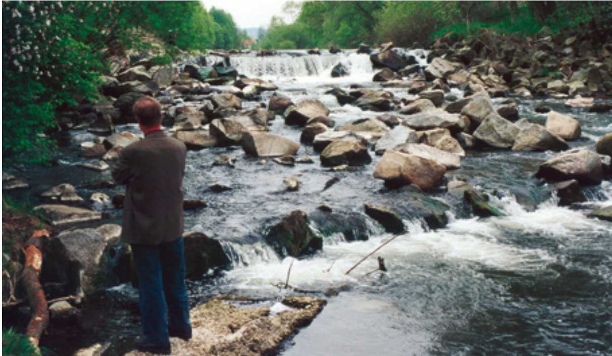
Abb. 19: Beispiel für Rampenversagen durch Setzung
