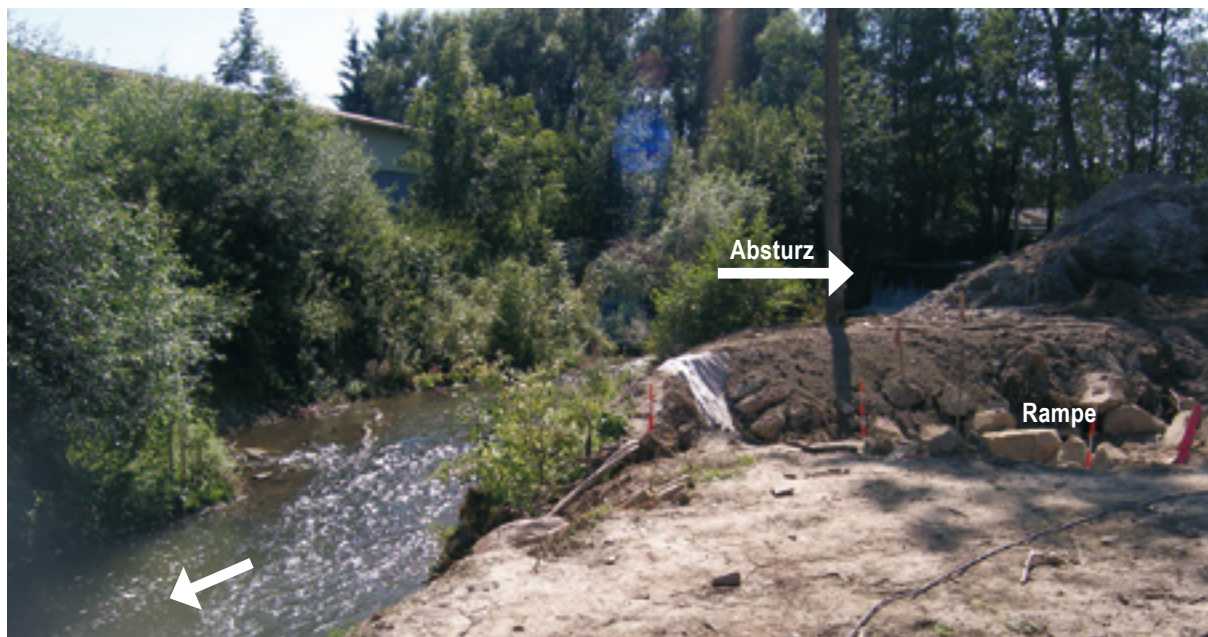
Abb. 135: Wasserhaltung beim Rampenbau
