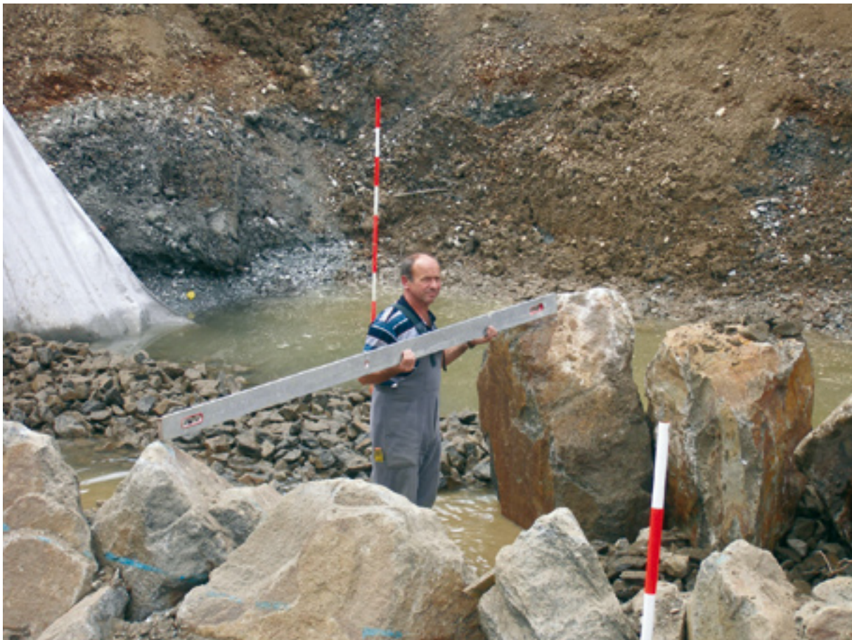
Abb. 162: Einbau eines Rampenriegels
