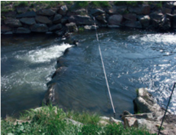
Abb. 224: Leitenbach, Rampe 1, Becken 3, Profil 3
