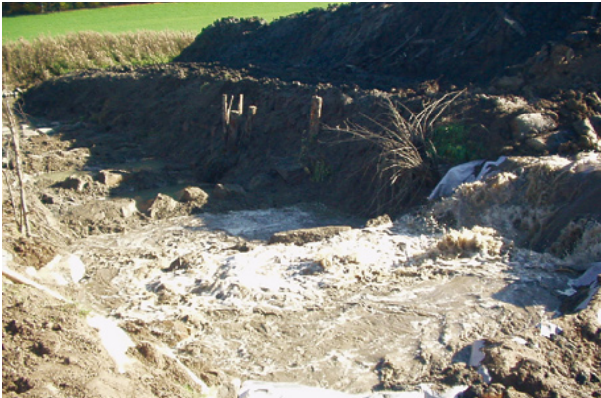
Abb. 76: Flutung der unteren Rampe oberhalb Krone
