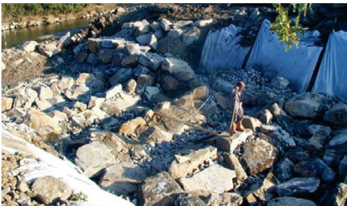
Abb. 59: Übersicht: Steinanordnung in der unteren Rampe
