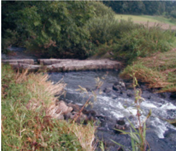
Abb. 45: Sohlsicherung oberhalb der alten Rampe
