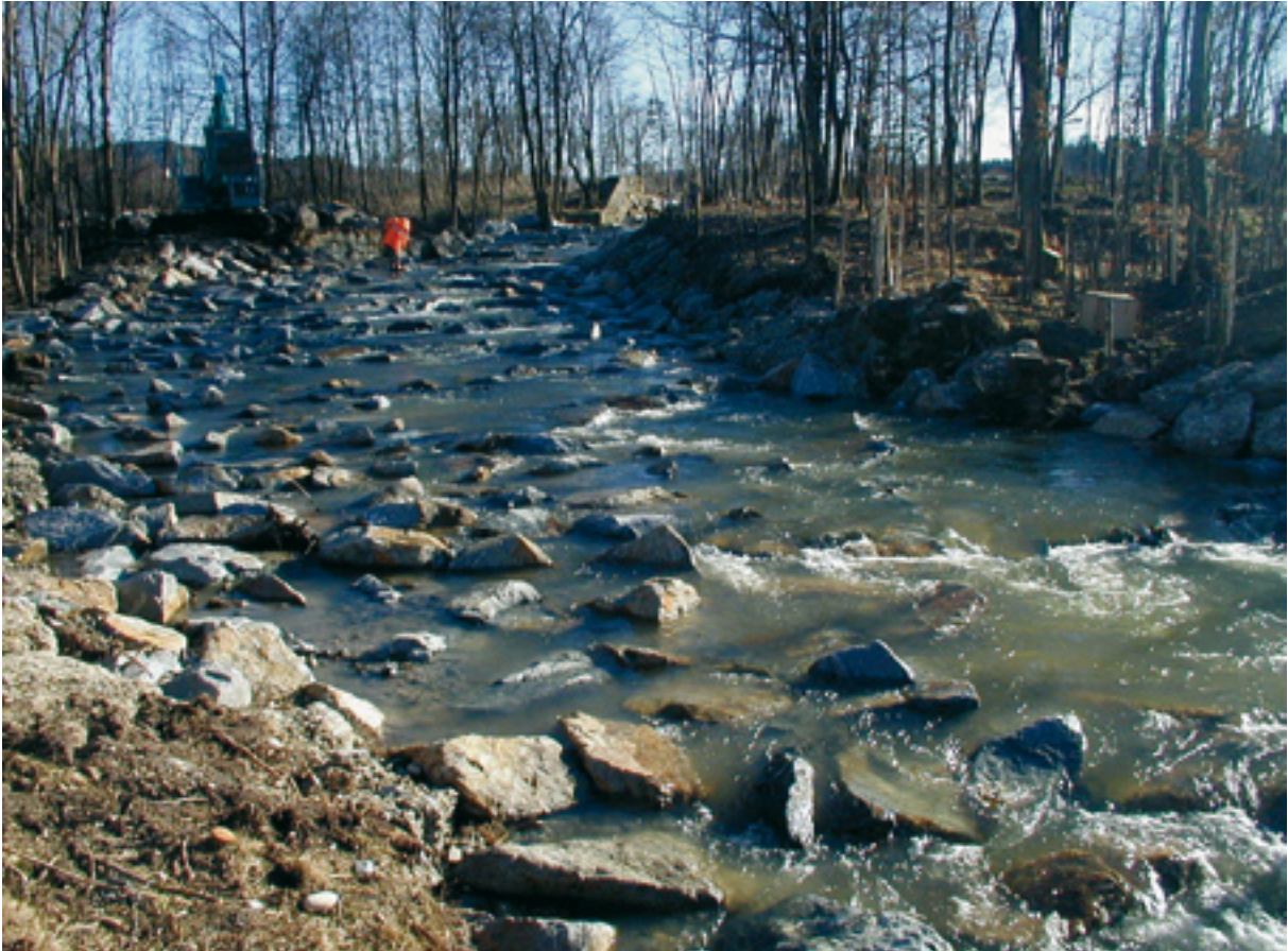
Abb. 6: Oberach, 2 Rampen in Riegel/Kompaktbauweise, Gewässerbezirk Braunau 2004
