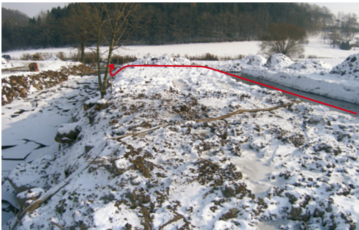
Abb. 106: Wasserhaltung über Umgehungsgerinne
