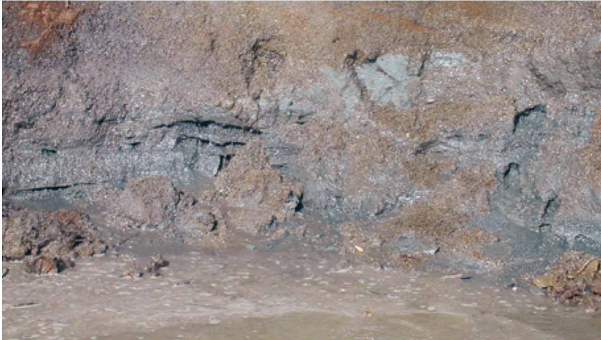
Abb. 50: Quellwasseraustritte in der Baugrube
