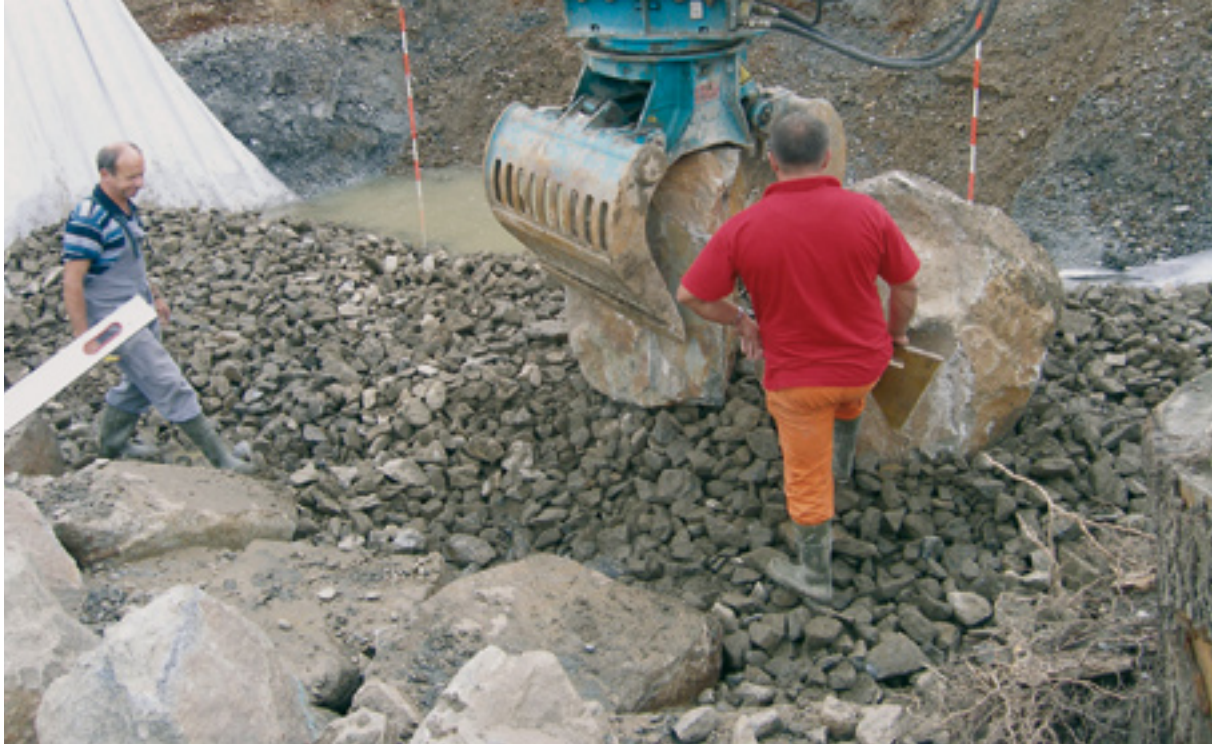
Abb. 139: Steinsatz auf Filterschicht
