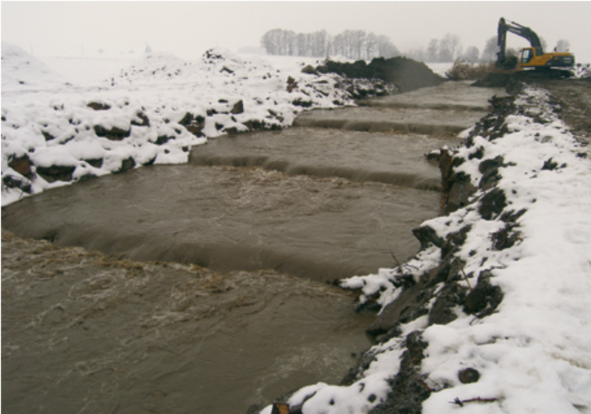
Abb. 107: Flutung der Rampen, Dezember 2005
