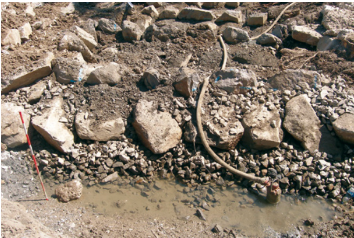
Abb. 140: Riegel- und Beckenformationen auf Filterkörper
