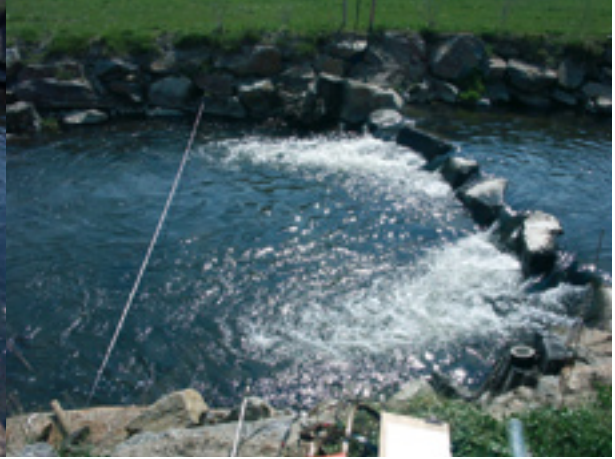
Abb. 223: Leitenbach, Rampe 1, Becken 3, Profil 2
