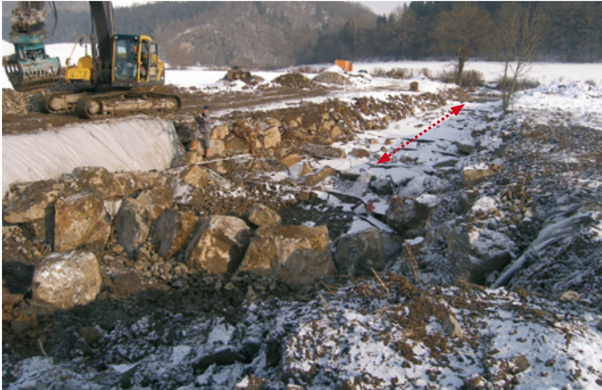
Abb. 75: Krone der unteren Rampe und Fuß der oberen Rampe auf gleicher Höhe
