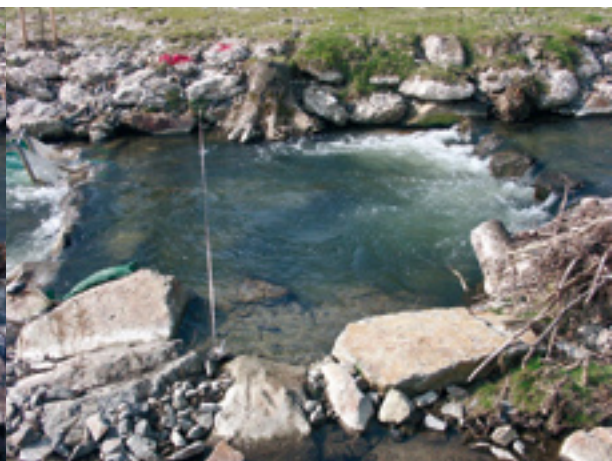
Abb. 216: Innbach, Becken 8, Profil 3
