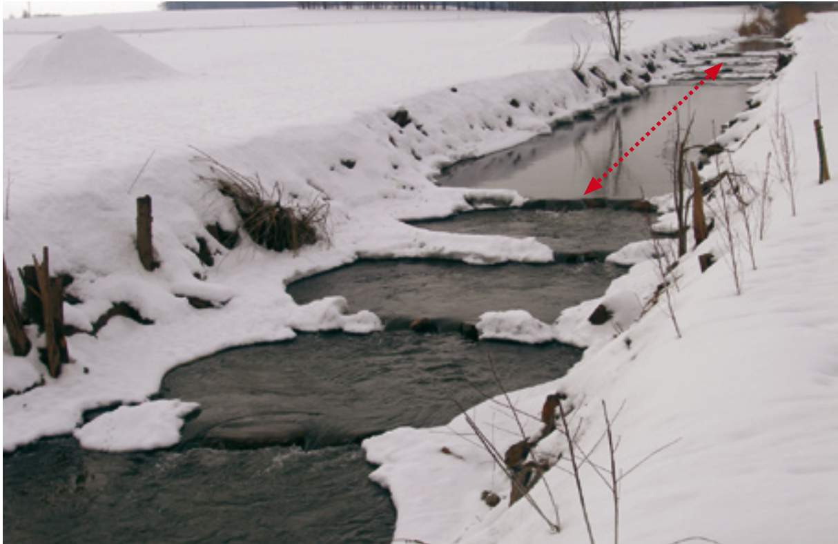
Abb. 94: Rampen und Zwischenstrecke nach Fertigstellung
