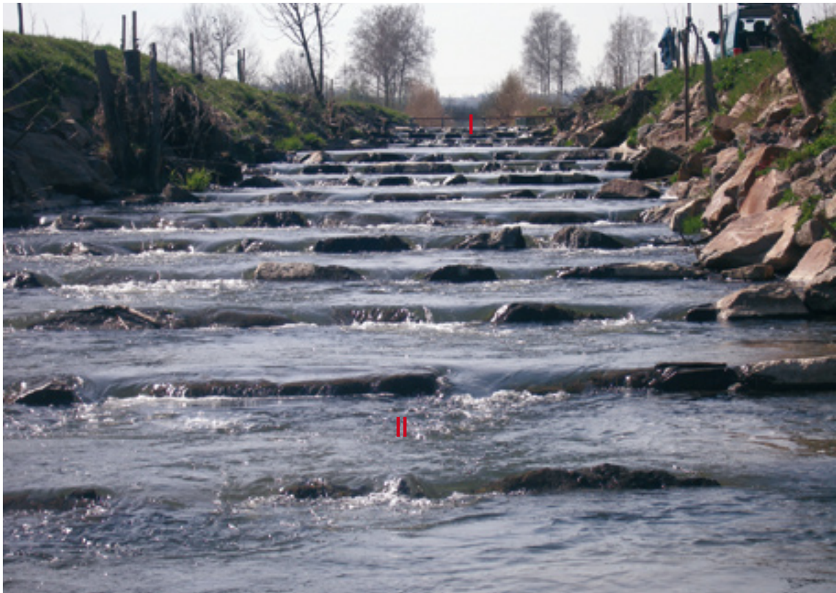
Abb. 118: Beide Rampen zur Zeit des 1. fischökologischen Monitorings, April/Mai 2006
