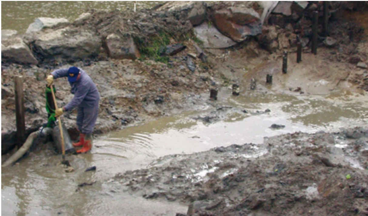
Abb. 54: Aushub und lokale mechanische Sicherung des Rampenfußes
