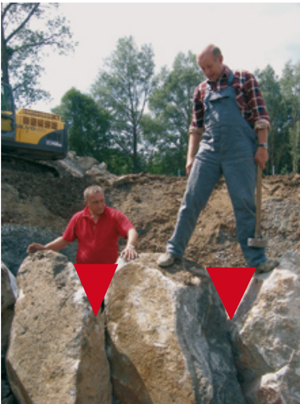
Abb. 142: Einpassen der Riegelsteine, Wanderkorridore
