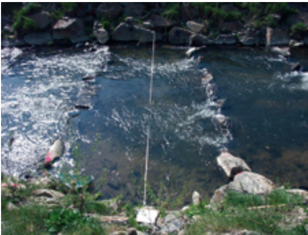
Abb. 232: Leitenbach, Rampe 2, Becken 3, Profil 2
