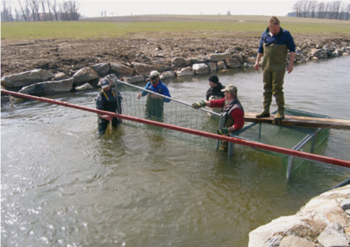
Abb. 120: Einbau der Hauptreuse
