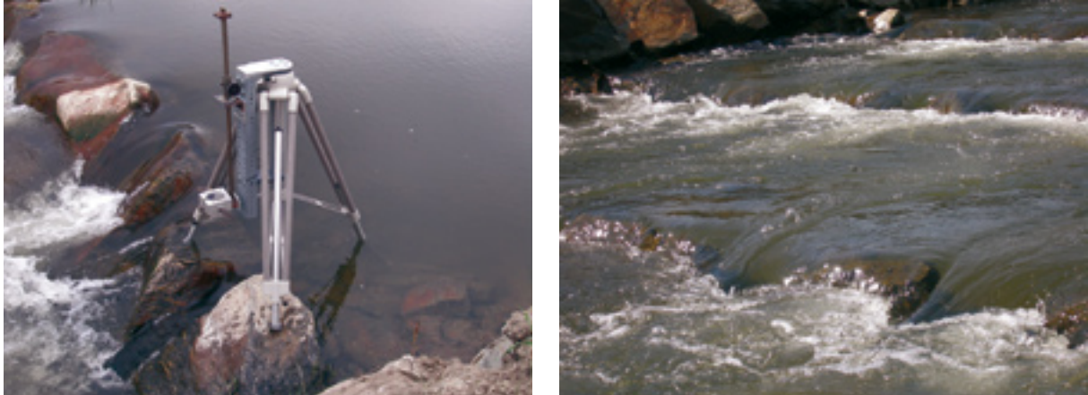
Abb. 82 und 83: Überprüfung der Fließgeschwindigkeit in den Korridoren, Einstau vom Unterwasser (siehe dort)
