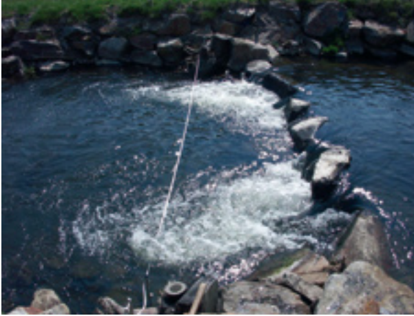
Abb. 222: Leitenbach, Rampe 1, Becken 3, Profil 1
