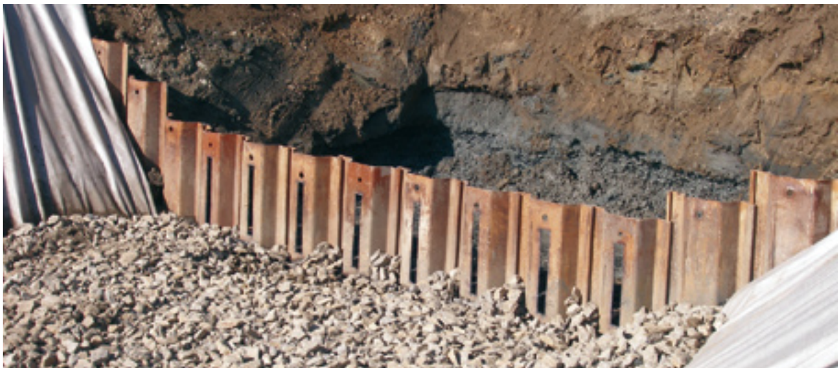
Abb. 151: Spunddielen zum Schutz des Kronenriegels
