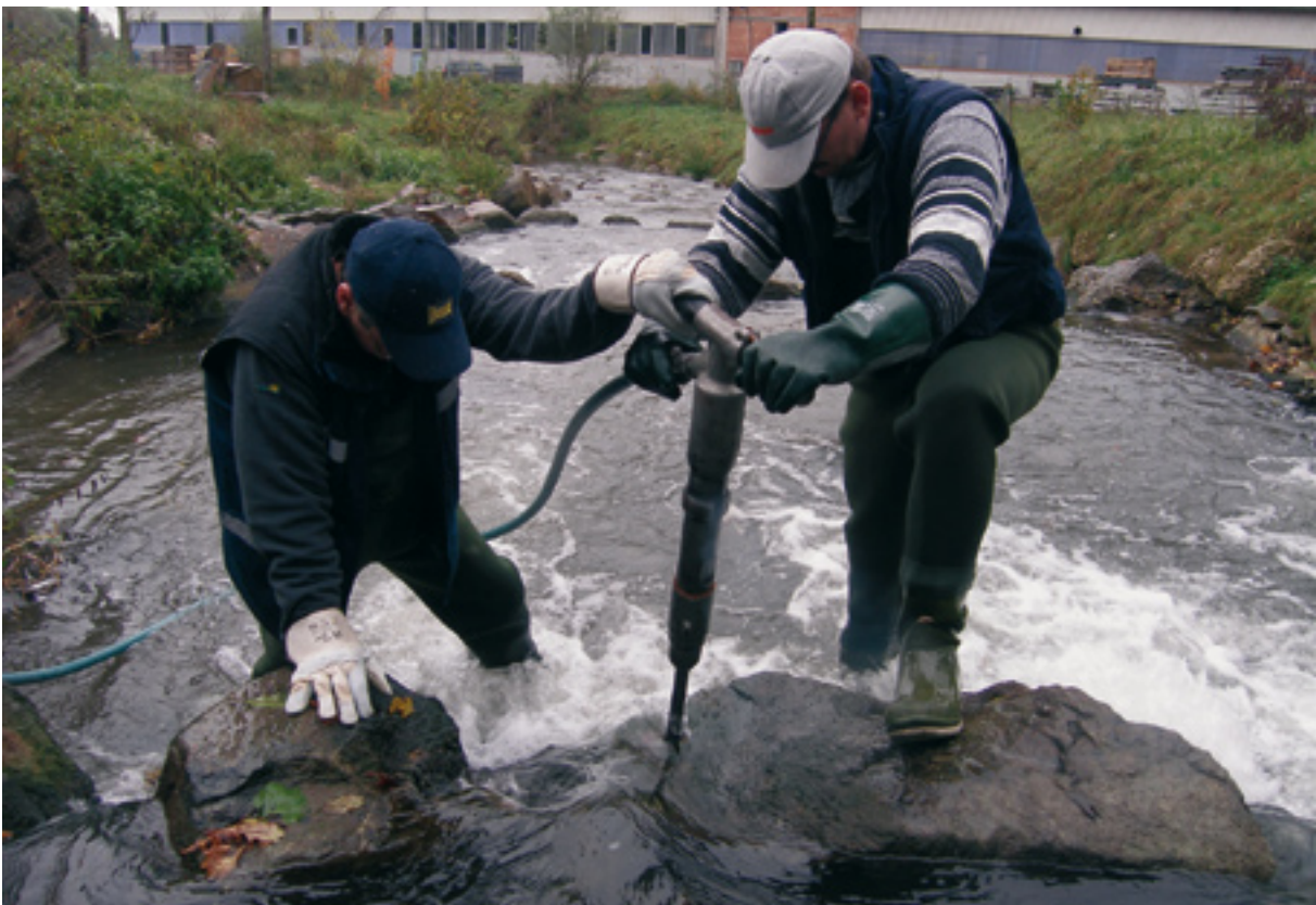
Abb. 190: Verbreiterung eines Korridors
