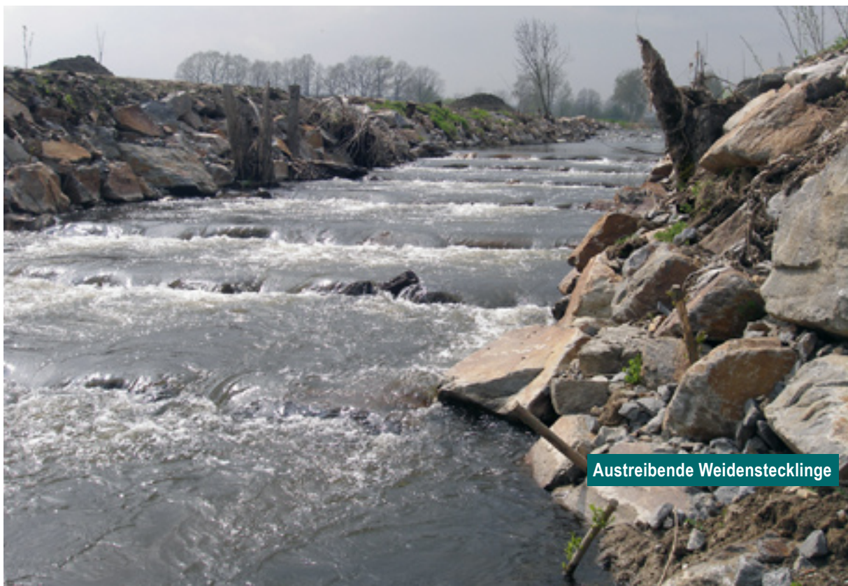
Abb. 119: Abfluss über die Rampen bei erhöhter Wasserführung, Mai 2006
