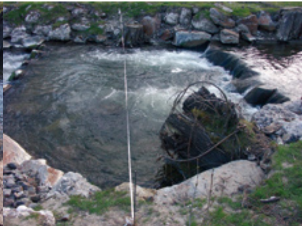
Abb. 212: Innbach, Becken 10, Profil 2
