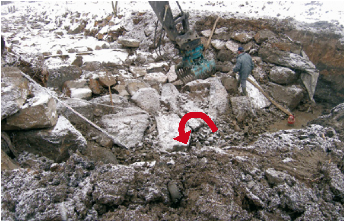
Abb. 105: Sicherung durch Steinkeil oberhalb Kronenriegel
