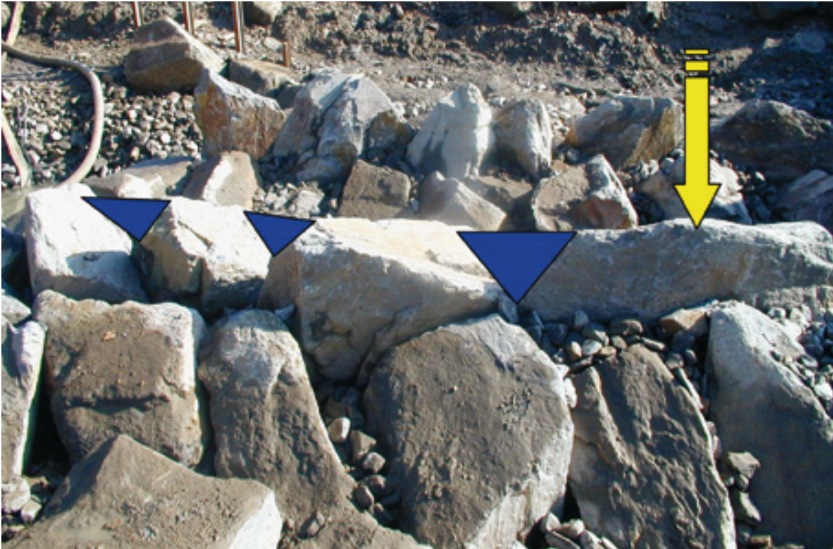
Abb. 60: Anordnung von Randstein und Wanderkorridoren im Riegel
