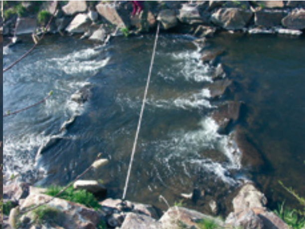
Abb. 229: Leitenbach, Rampe 2, Becken 6, Profil 2
