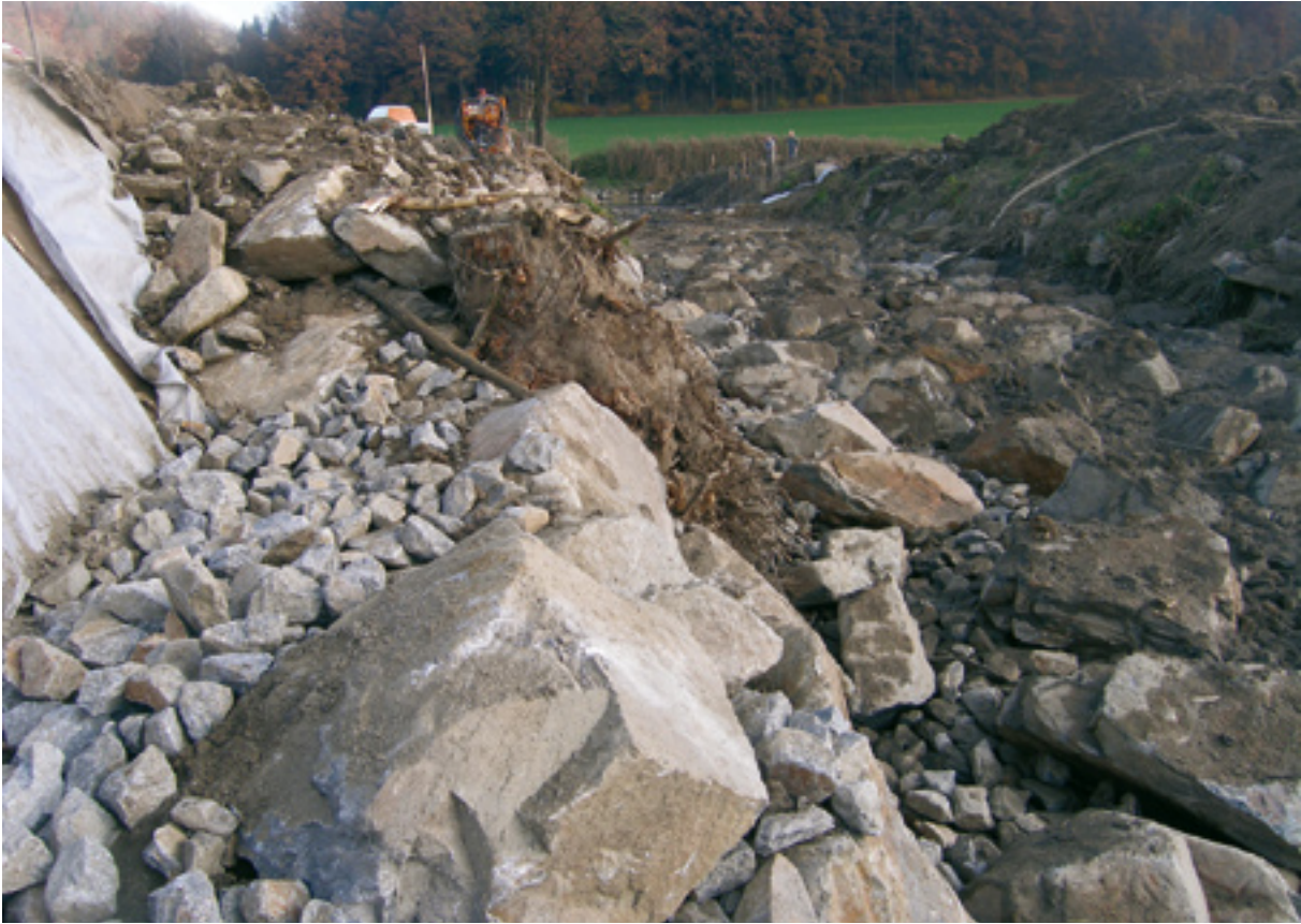
Abb. 109: Kombination aus Steinschichtung und Wurzelstock
