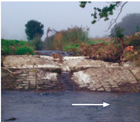
Abb. 43: Desolater Leitenbachrampe, September 2005
