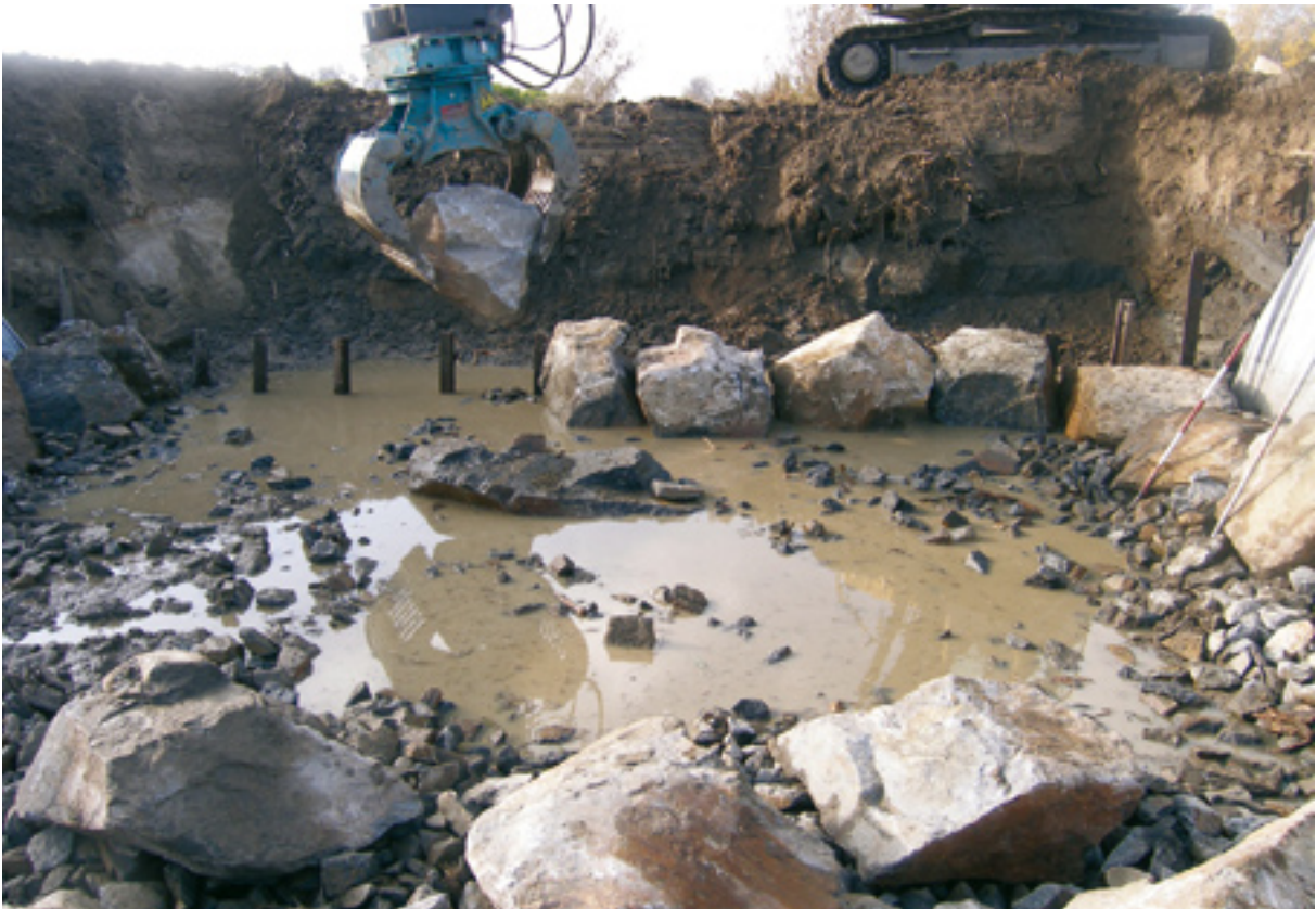
Abb. 101: Riegelformation mit Wanderkorridoren
