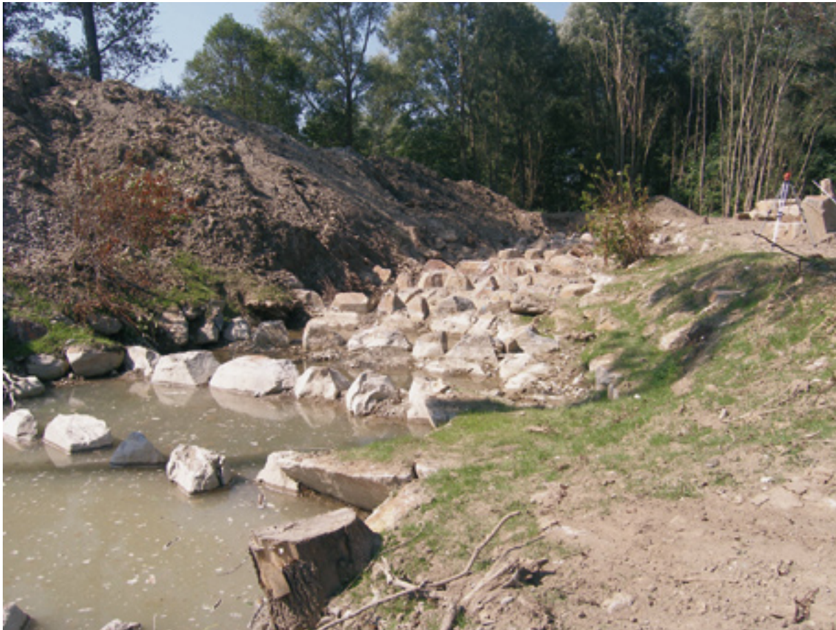
Abb. 160: Rampenkörper vor Flutung
