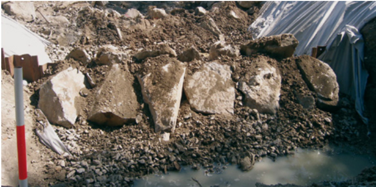
Abb. 152: Steinsicherung oberhalb des Kronenriegels
