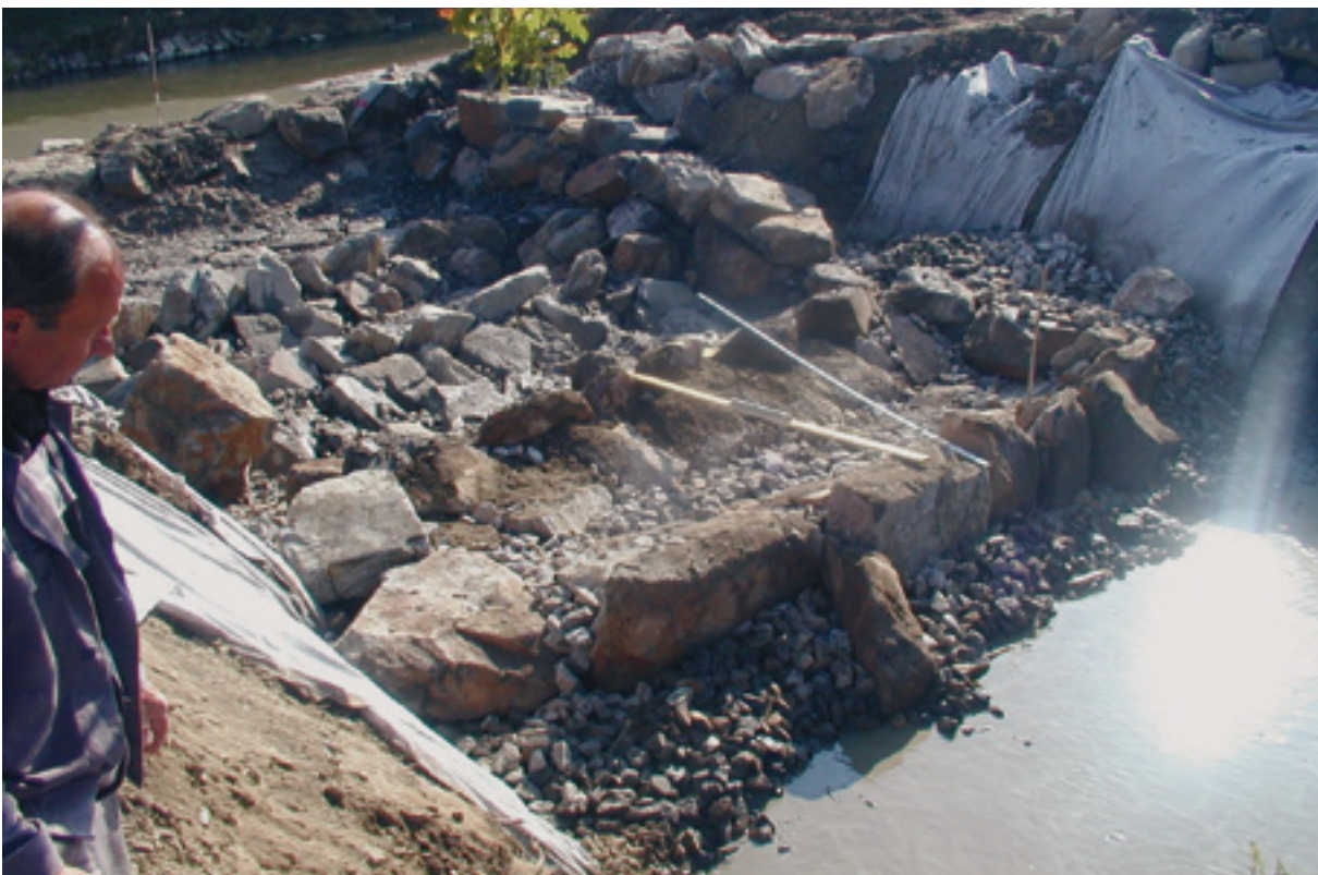
Abb. 53: Filterschicht unter und seitlich des Kompaktsteinsatzes
