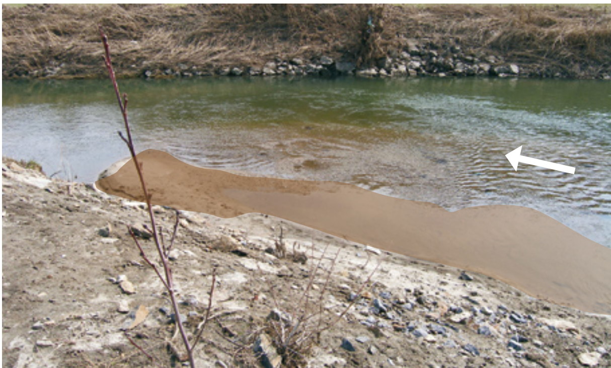
Abb. 63: Leitenbachmündung nach Umbau; Auskolkung in die Aschach nach Baufertigstellung
