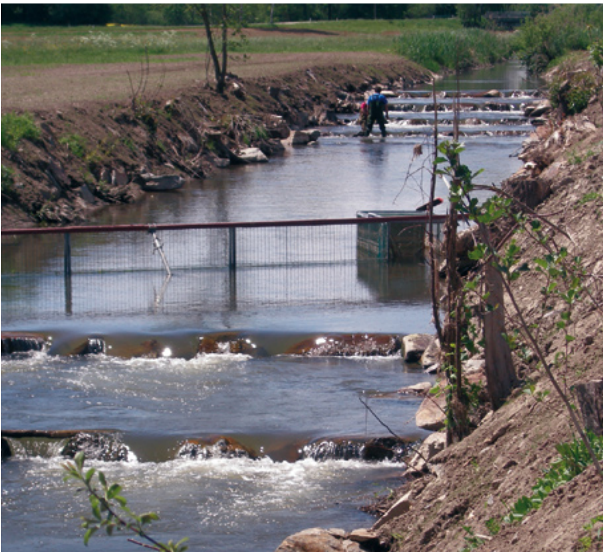
Abb. 114: Entwicklung der Böschungsbepflanzung im Mai 2006
