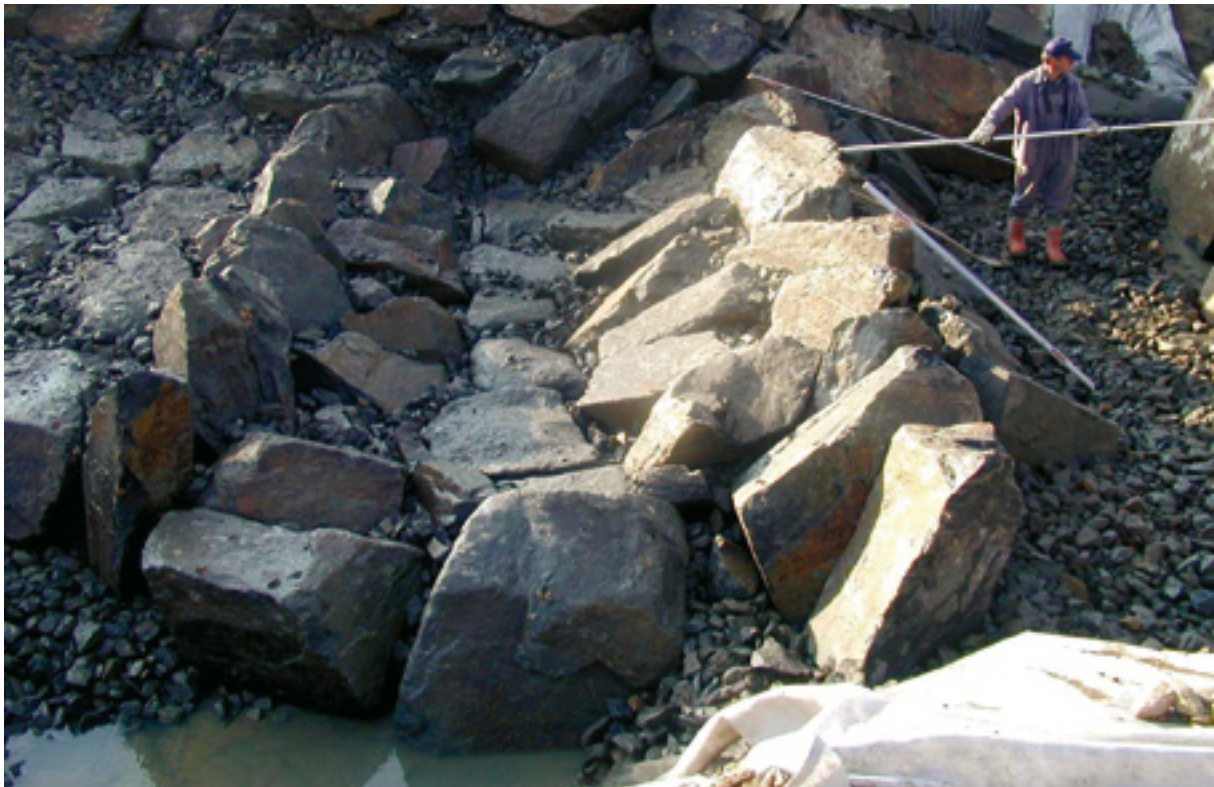
Abb. 88: Anordnung der Riegelsteine mit Wanderkorridoren
