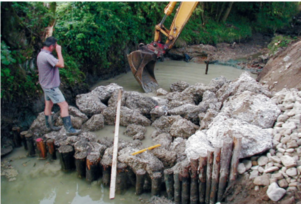
Abb. 3: Bauphase (Foto: Petz-Glechner R., 2001)
