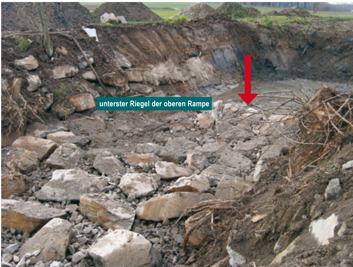
Abb. 98: Nachbettung (=Zwischenstrecke) und unterster Riegel der oberen Rampe, Aushub
