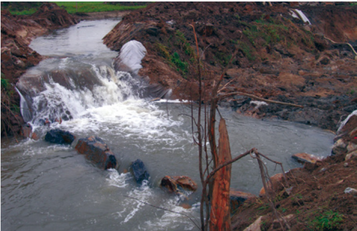
Abb. 91: Flutung der unteren Rampe
