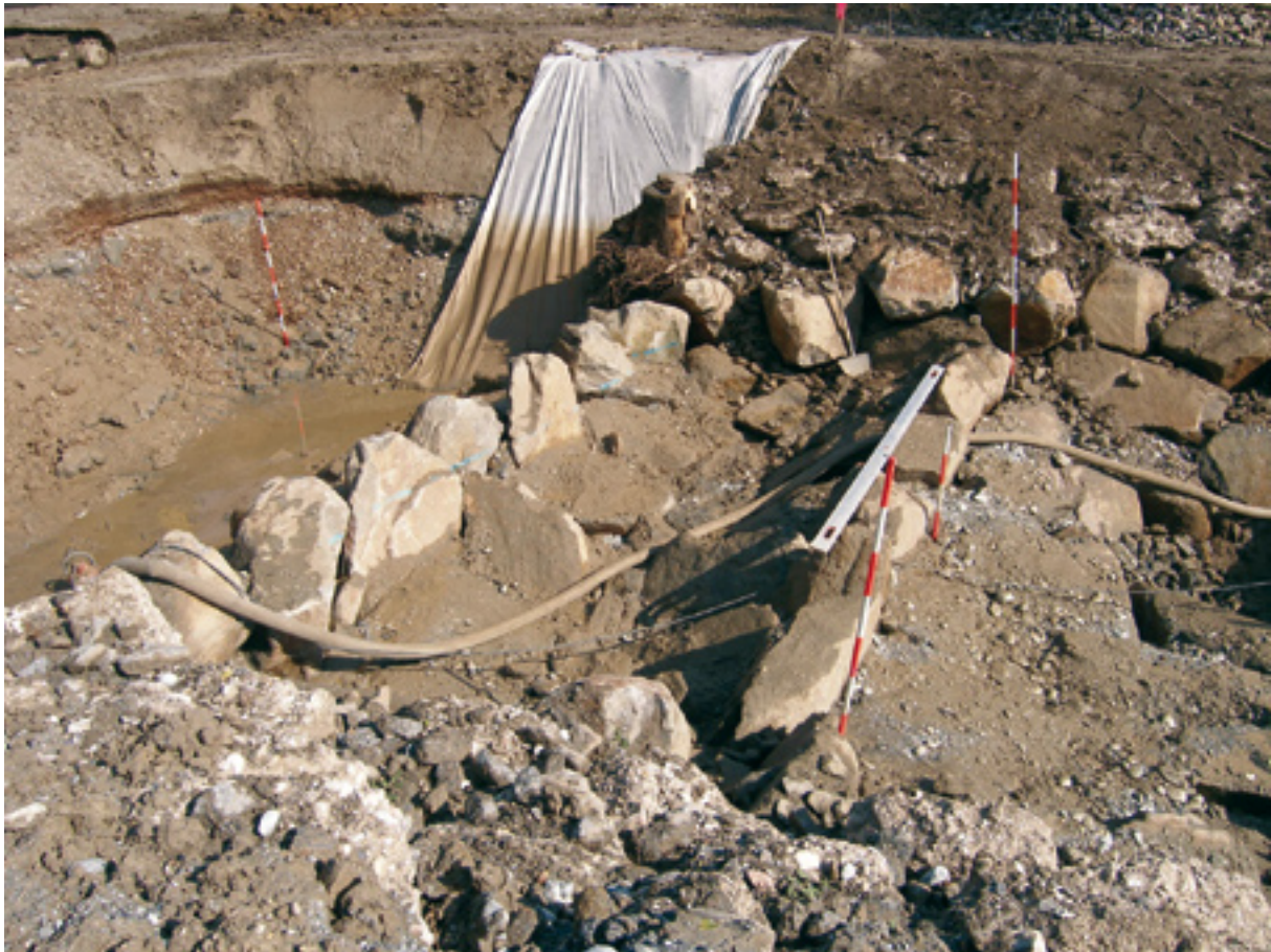
Abb. 183: Kombination aus Granitsteinen für Rampenkörper und Konglomeratsteinen für Böschung
