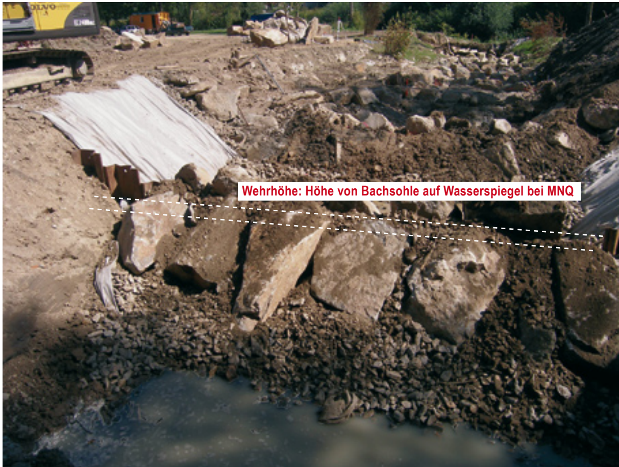
Abb. 150: Lage der Rampenkronen, Wehrhöhe
