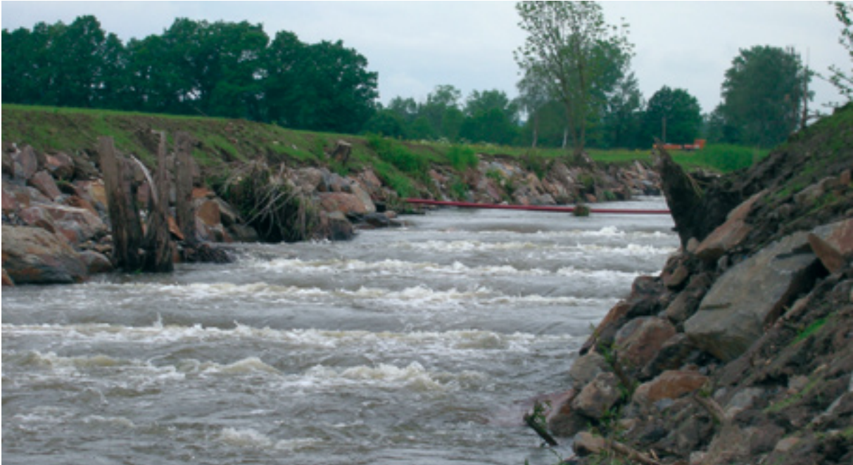
Abb. 113: Austreibende Weidenstecklinge, gewonnen aus Weiden des Umlandes, bei Mittelwasserführung
