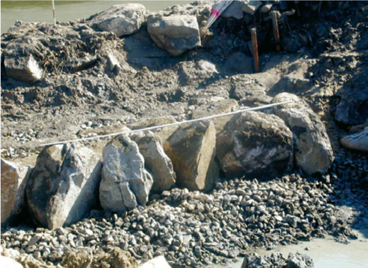
Abb. 52: Filterkörnung und Riegelsteine
