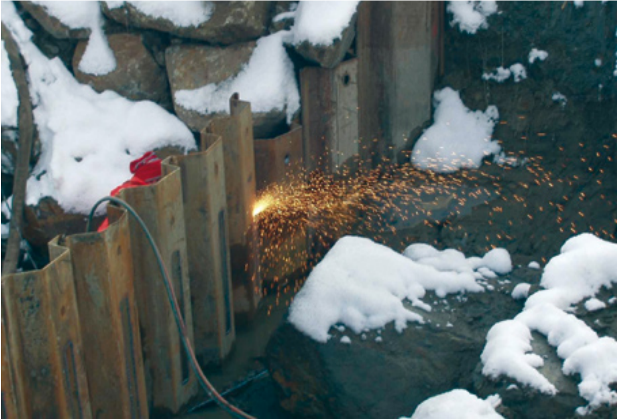
Abb. 103: Geschlitzte Spunddielen am Kronenriegel
