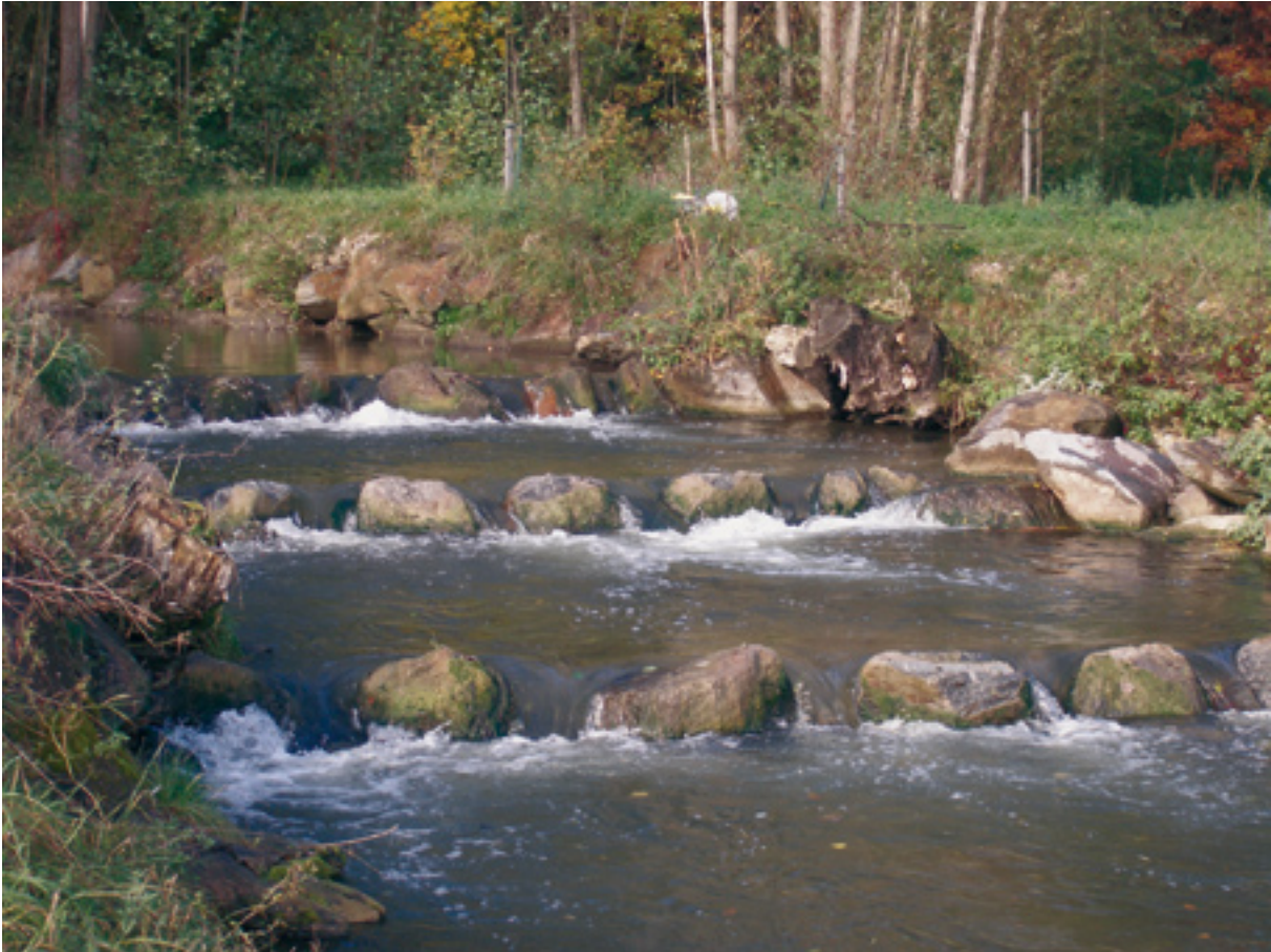
Abb. 199: Obere Rampenriegel nach Bearbeitung
