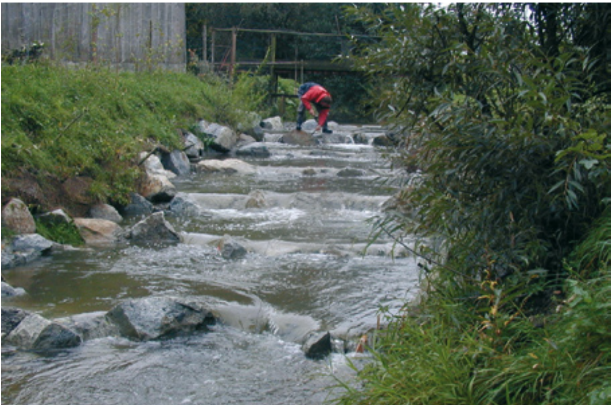
Abb. 5: Pramauerbach, Gewässerbezirk Grieskirchen 2004
