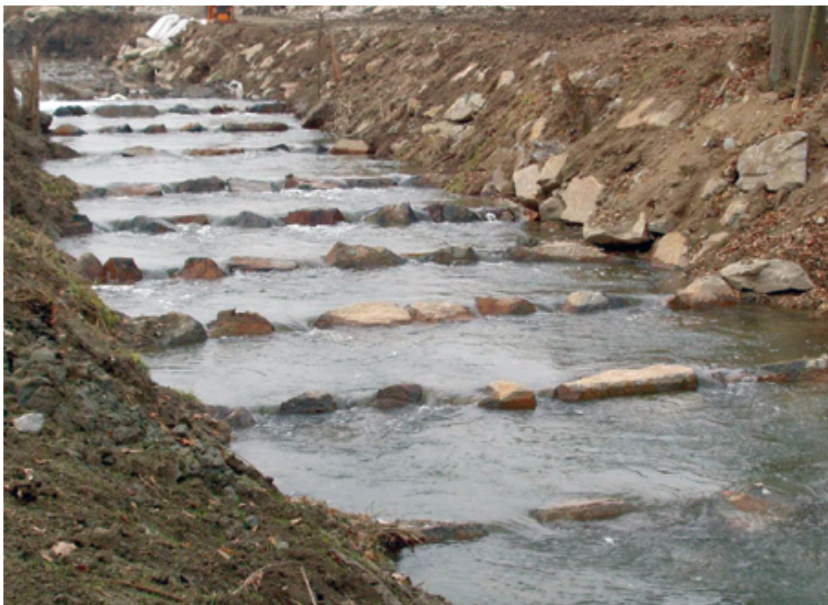
Abb. 92: Untere Leitenbachrampe und Teil der Zwischenstrecke oberhalb, Dezember 2005
