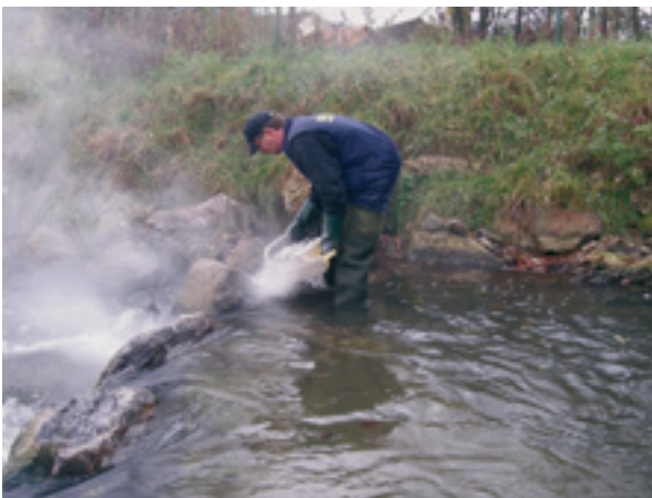
Abb. 196: Bearbeitung der Riegelsteine
