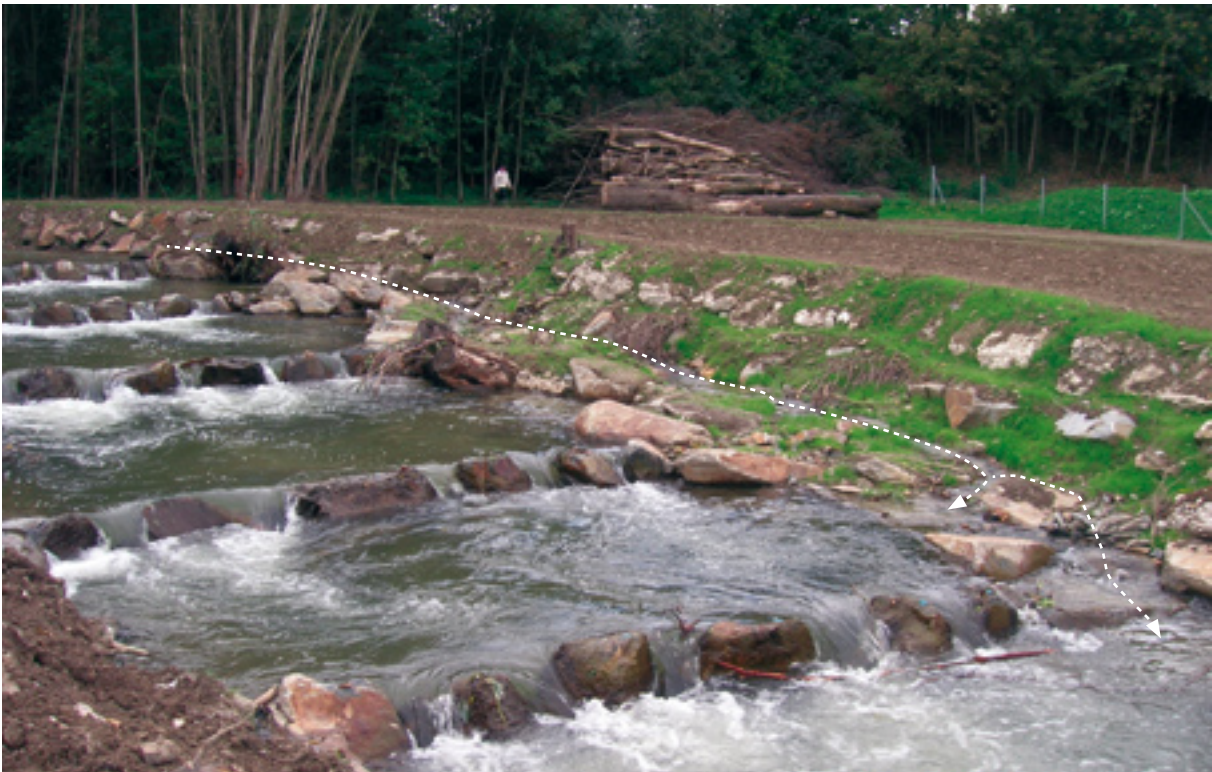
Abb. 180: Wiedereinmündung des Begleitgewässers in Becken 6 und 7
