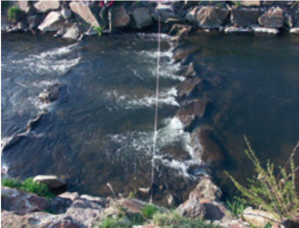
Abb. 228: Leitenbach, Rampe 2, Becken 6, Profil 1
