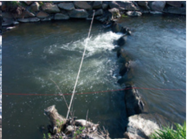
Abb. 225: Leitenbach, Rampe 1, Becken 2, Profil 1
