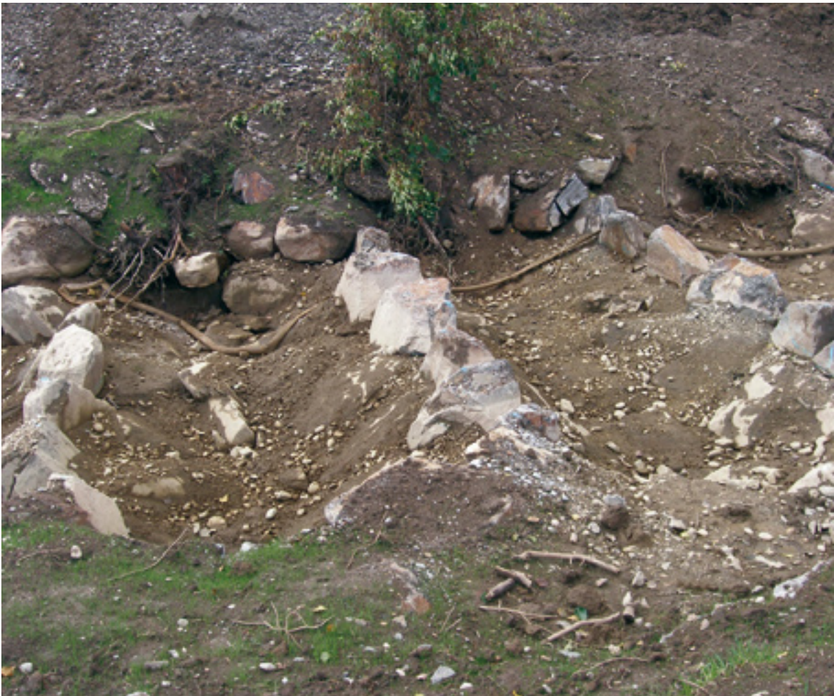
Abb. 148: Feinsedimentschicht über Steinsatz
