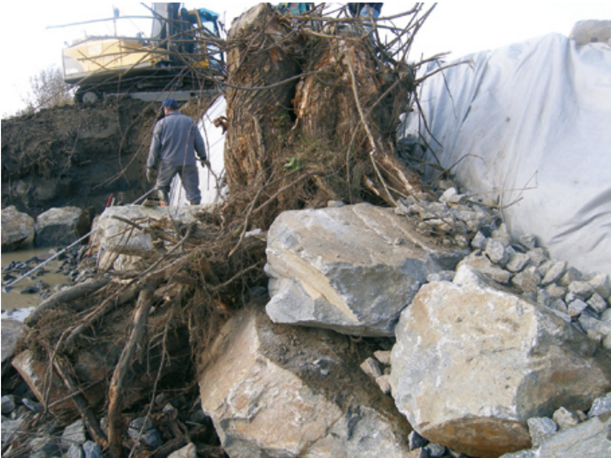
Abb. 110: Stock mit ins Wasser flutenden Wurzeln, Unterstand und Schutzstruktur
