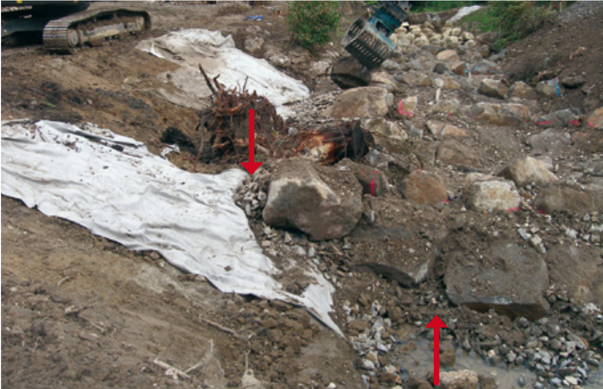
Abb. 141: Lage Filterkörper unter und seitlich des Steinsatzes
