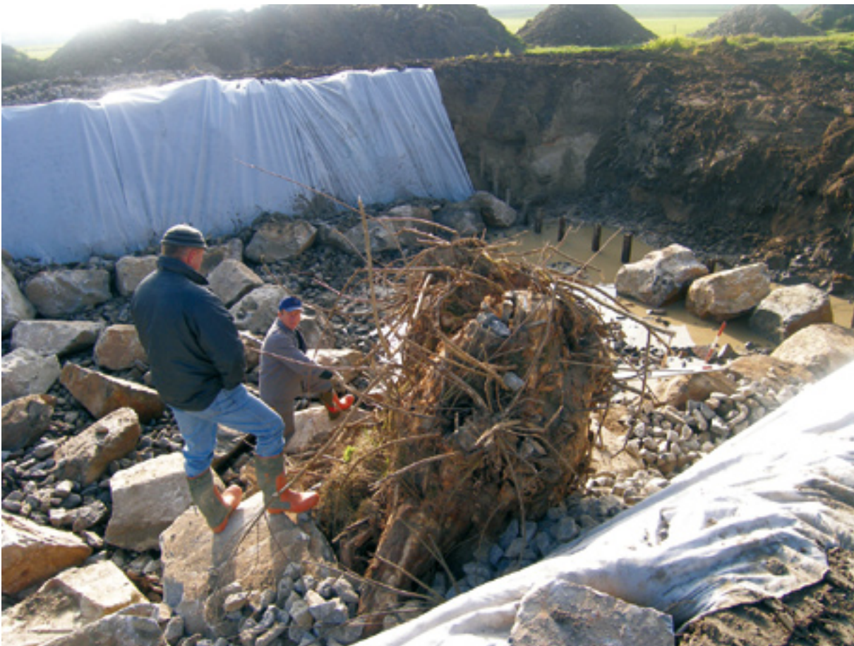
Abb. 96: Fußsicherung der oberen Rampe, Filterschicht, Bauvlies, Wurzelstockeinbau
