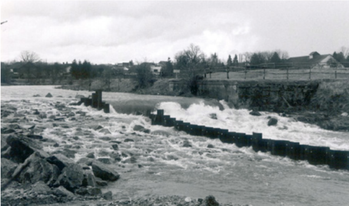
Abb. 2: Wasserhaltung, Flutung des 1. Bauabschnitts, Neigung: 1:10
