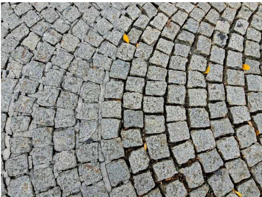
Auch Pflasterflächen müssen gewartet werden durch regelmäßiges Nachsanden.
