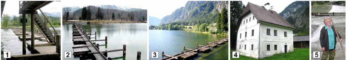
Abb. 24: Die 1573 errichtete Seeklause in der Kulturlandschaft. [1] Die von Thomas Seeauer 1573 errichtete Seeklause bestand aus der eigentlichen, 110 Meter langen Steinkastenklause mit 11 Klaustoren direkt neben der heutigen Traunbrücke, sowie aus dem „Gegenpolster“ zur Aufstauung des Seewassers und damit Schiffbarmachung der Traun. Der Anlageteil Klaus Steeg (Detail) mit Durchblick auf die östliche Uferzone [Bildnachweis: Wikipedia]. [2]: Der Anlageteil Klaus Steeg mit dem „landschaftlichen Vorranggebiet“ im Hintergrund. Das jetzige Landschaftsbild ist auch wegen seiner Eigenart als „historische Landschaftszone“ (UNESCO) zu bezeichnen und schützenswert, weil es das Bild der „ursprünglich“ vorhandenen geringe Bebauung zur Entstehungszeit der Anlage in der „absoluten Salzwirtschaft“ „authentisch“ widerspiegelt. (Photonachweis: Konzeptstudie Klaus Steeg - Abschlussbericht für das Amt der Oö. Landesregierung – Gewässerbezirk). [3]: Der Anlageteil Klaus Steeg mit Blick auf die westliche Uferzone (Photonachweis: Wikipedia). [4]: Das Klauswarterhaus im Bereich der westlichen Uferzone (Photonachweis: Wikipedia). [5]: Die „letzte“, Jahrzehnte lang tätig gewesene Klausmeisterin Leopoldiner Trausner in ihrem „Element“ – tägliche Überwachung der Anlage und Übermittlung von hydrographischen Daten an das Land [Bildnachweis: Traunspiegel].
