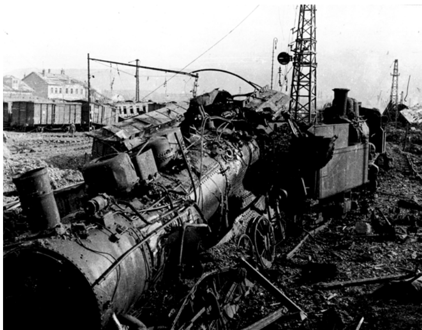
Abb. 31: Attnang-Puchheim, 21. April 1945: Das Bahnhofsgebäude, die Gleisanlagen samt 67 abgestellter Lokomotiven und 560 Waggons vollständig zerstört. Bildnachweis: Eva Kurz. Stadtarchiv Attnang-Puchheim.
