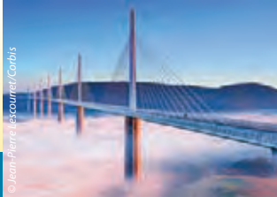
Die höchste Brücke der Welt: das Millau-Viadukt (Frankreich)
