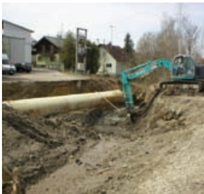
Hochwasserschutz in Bau (Foto: Gewässerbezirk Braunau)
