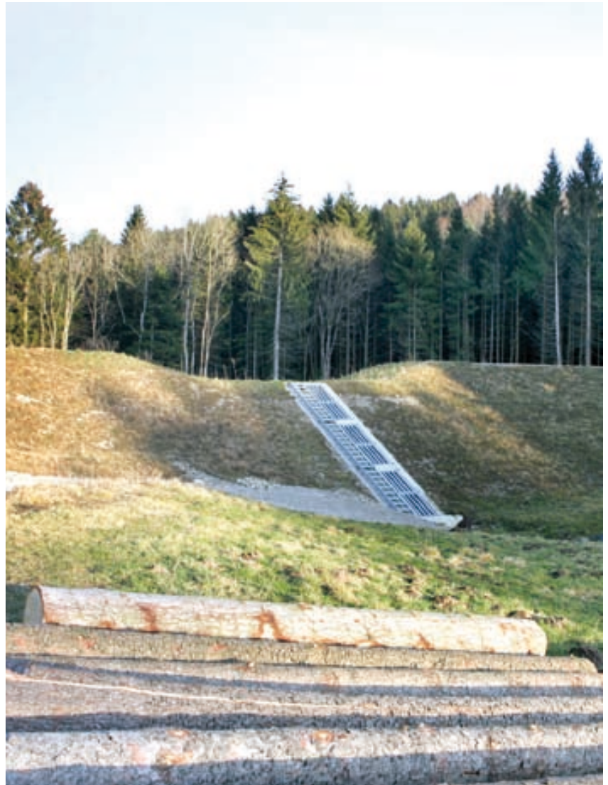
Hochwasserrückhaltebecken Dirnham (Foto: Franz Linschinger)
