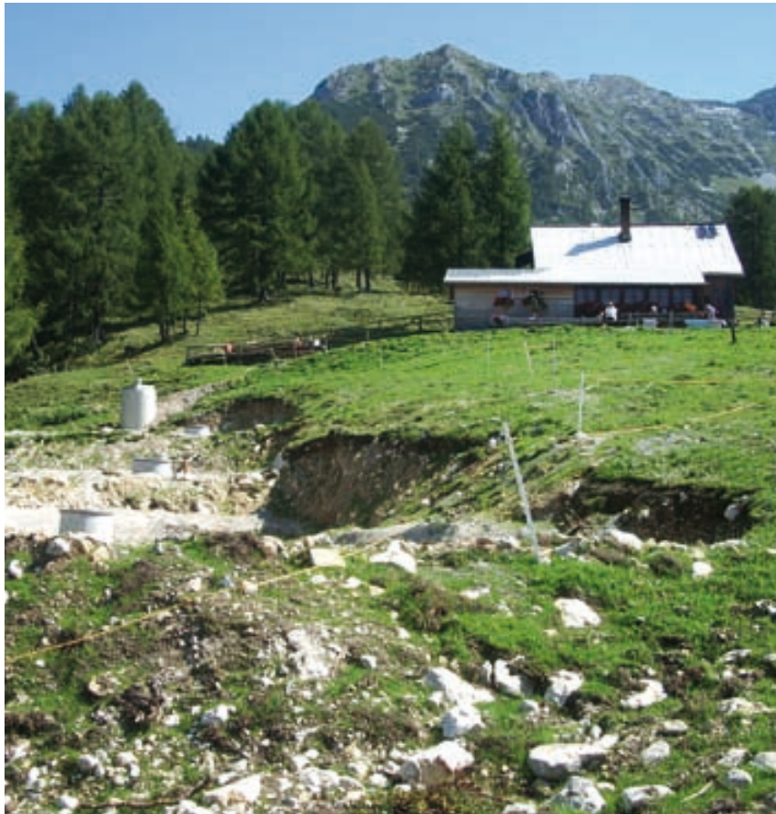
Abwasserentsorgung Gowilalm (Foto: Wasserwirtschaft/Abwasserwirtschaft)
