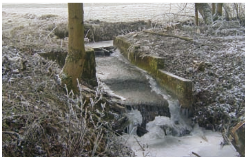
Alte Wehranlage an der Antiesen (Foto: Gewässerbezirk Braunau)
