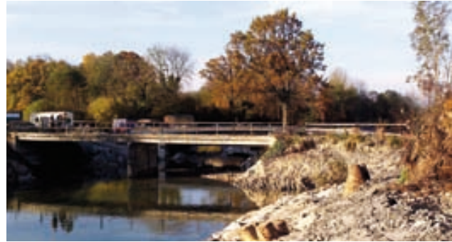
Der Mattigunterlauf beim Umbau (Foto: Franz Linschinger)
