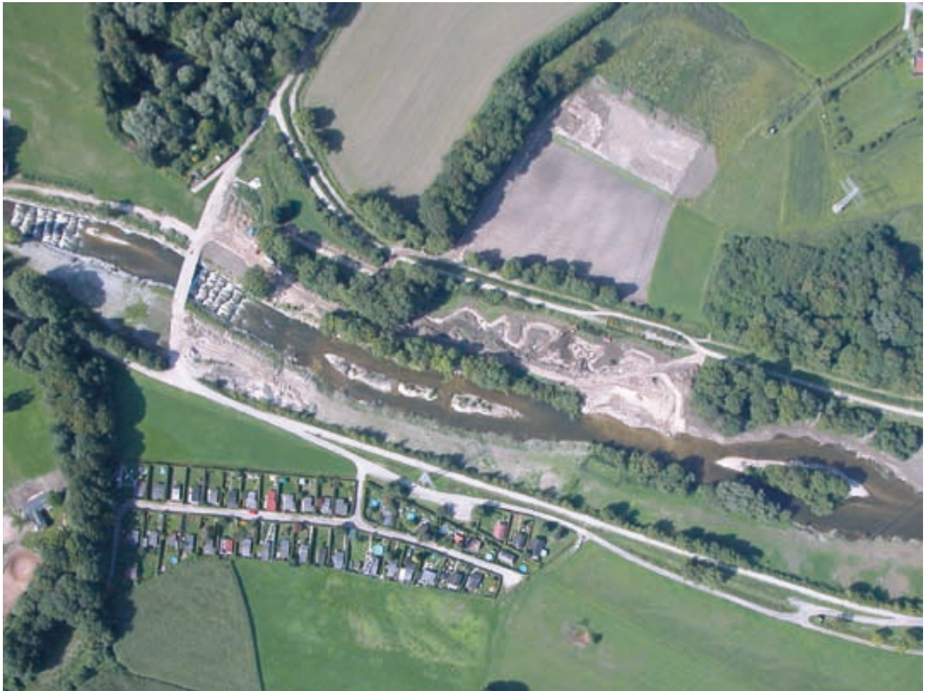
Flugaufnahme des Mattigunterlaufes (Foto: Eisner, Gewässerbezirk Braunau)
