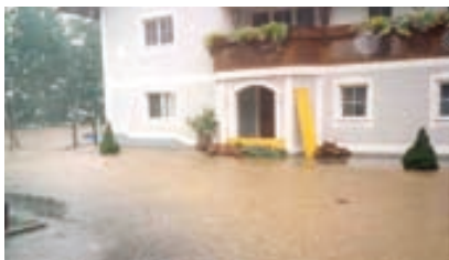
Hochwasser 2002 (Foto: Gewässerbezirk Grieskirchen)
