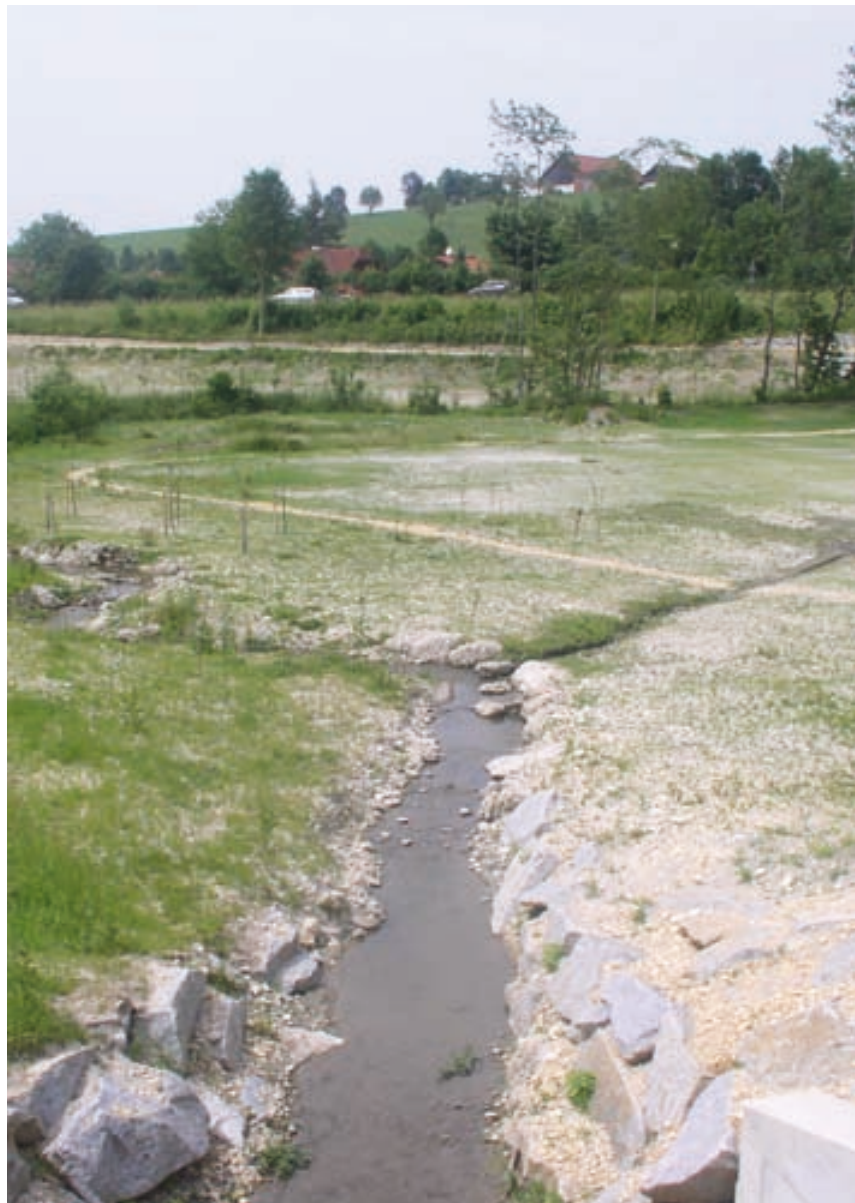
Rückhaltebecken Lambrechten (Foto: Gewässerbezirk Grieskirchen)
