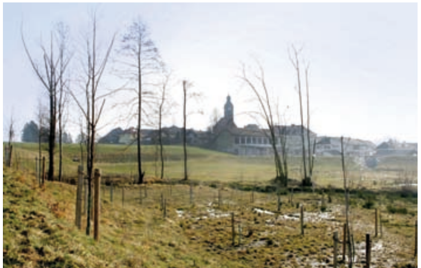
Hochwasserrückhaltebecken Lambrecht (Foto: Franz Linschinger)
