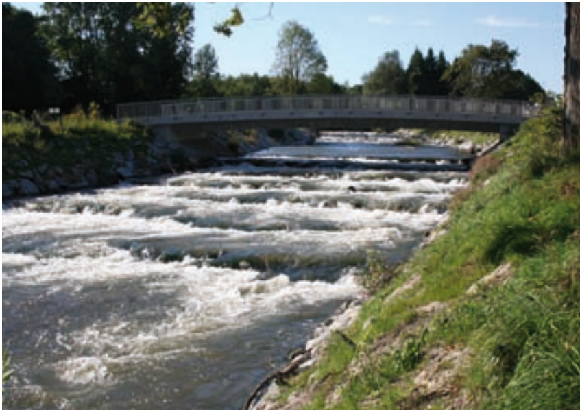
Der Mattigunterlauf nach Fertigstellung (Foto: Gewässerbezirk Braunau)
