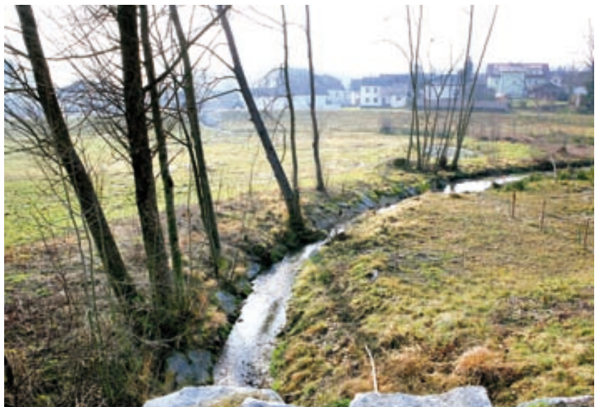
Hochwasserrückhaltebecken Lambrecht (Foto: Franz Linschinger)
