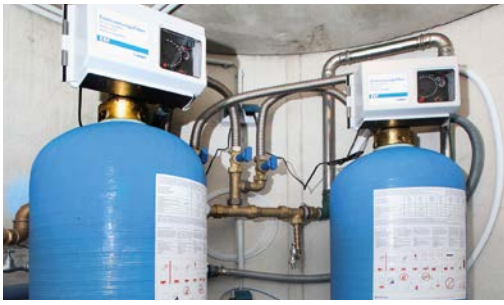
Beispiel einer Wasserenthärtungsanlage (Ionentausch-Verfahren)
