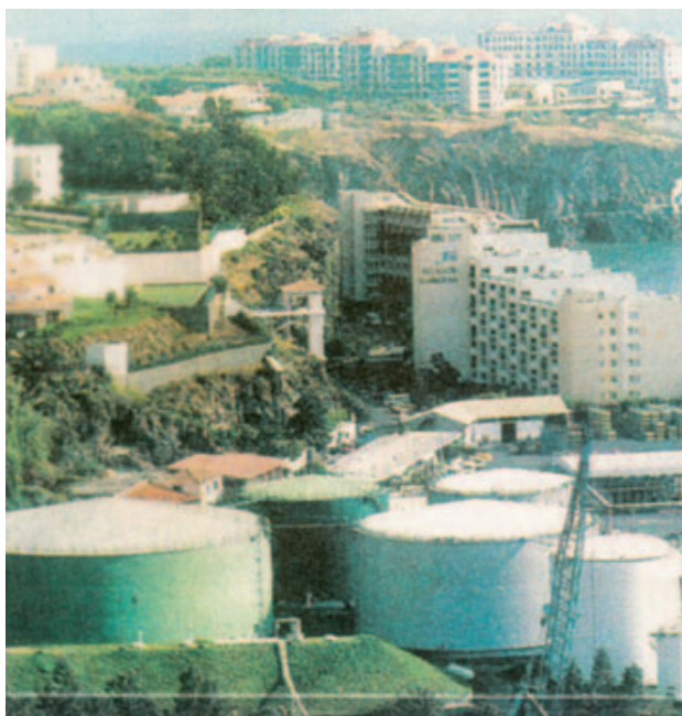
Die Abbildung zeigt ein Beispiel für eine Nachbarschaftssituation, die nach der Seveso-Richtlinie europaweit vermieden werden soll.
