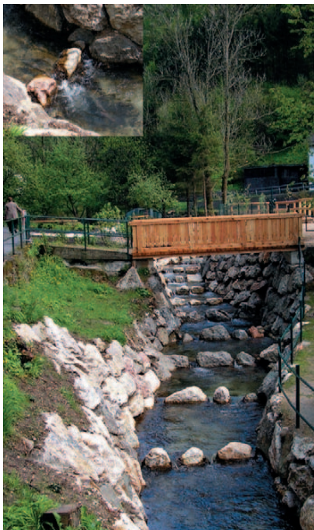
Fischeaufstieg Katzensteinerwehr (Foto: Forsttechn. Dienst für Wildbach- u. Lawinerverbauung)
