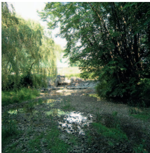
Nahezu trockenes Bachbett im Bereich einer Ausleitungsstrecke an der Kreams mit Blick auf das Staubauwerk (Foto: Wasserwirtschaft)
