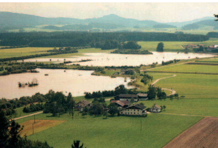
Hochwasserrückhaltebecken Teichstätt, Bezirk Braunau, Hochwasser 2002 (Foto: Gewässerbezirk Braunau)
