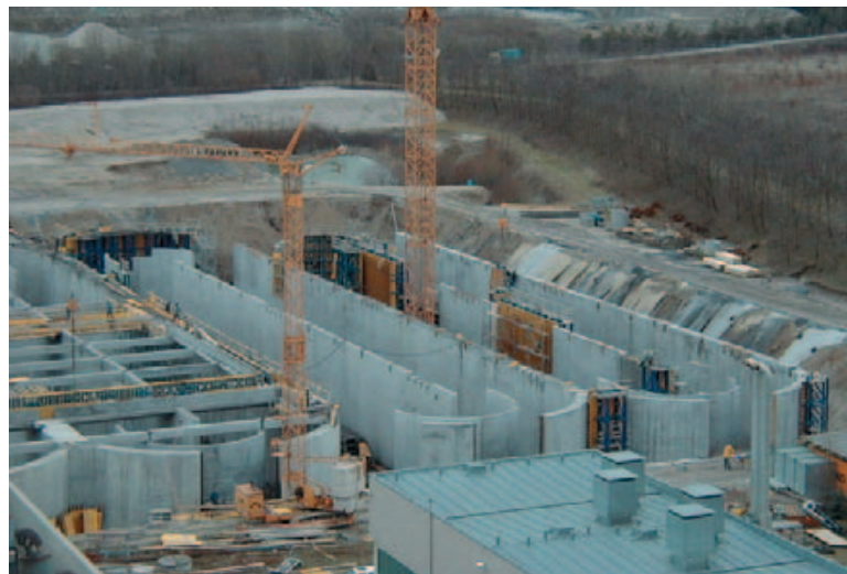
Ausbau der biologischen Stufe der Regionalkläranlage Linz Asten
