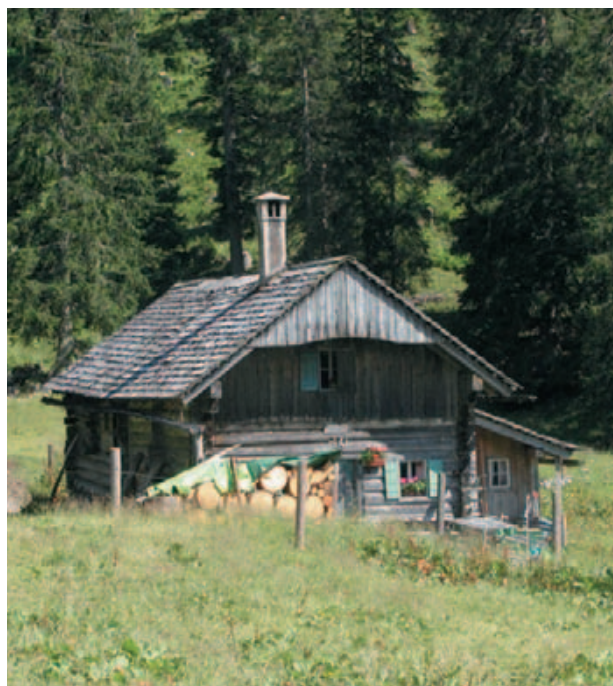
Die Rossalm - ein Beispiel für die dezentrale Wasserversorgung und Abwasserentsorgung (Foto: Abwasserwirtschaft/Trauner)
