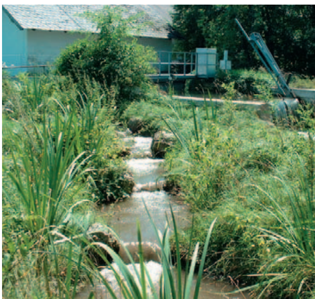
Umgehungsgerinne bei einem Kraftwerk an der Mattig, mit dem die Durchgängigkeit für Organismen wiederhergestellt wurde (Foto: Gewässerbezirk Braunau/Schaufler)
