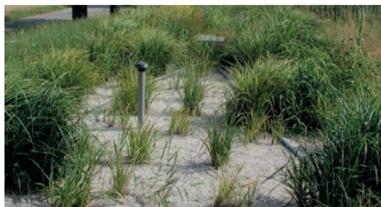
Pflanzenkläranlage (Foto: Abwasserwirtschaft/Trauner)
