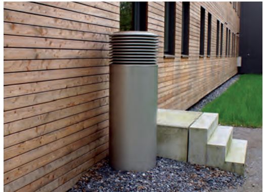
Ansaugöffnung für mechanische Zuluftanlage.
