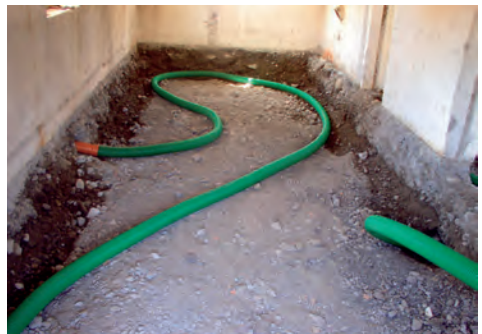
Erneuerung des Fußbodenaufbaues: Einbau einer Radondrainage.
