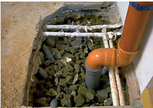
Punktueller Absaugung (Radonbrunnen) – Aushub eines Schachtes.
