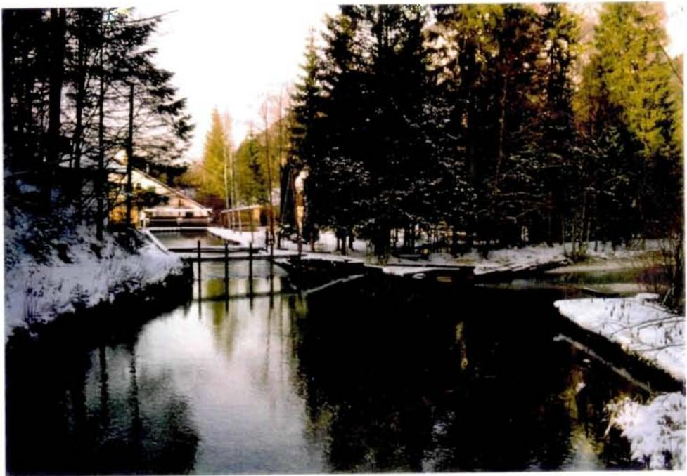
Abb. 3: Wehranlage des Habernauerwehres, links der Sagbach mit dem Rechenbauwerk vor dem Turbinenhaus der Habernauersäge.
