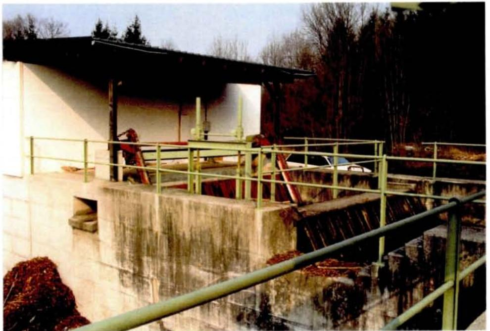
Abb. 131: Rechen- und Einlaufbauwerk der
