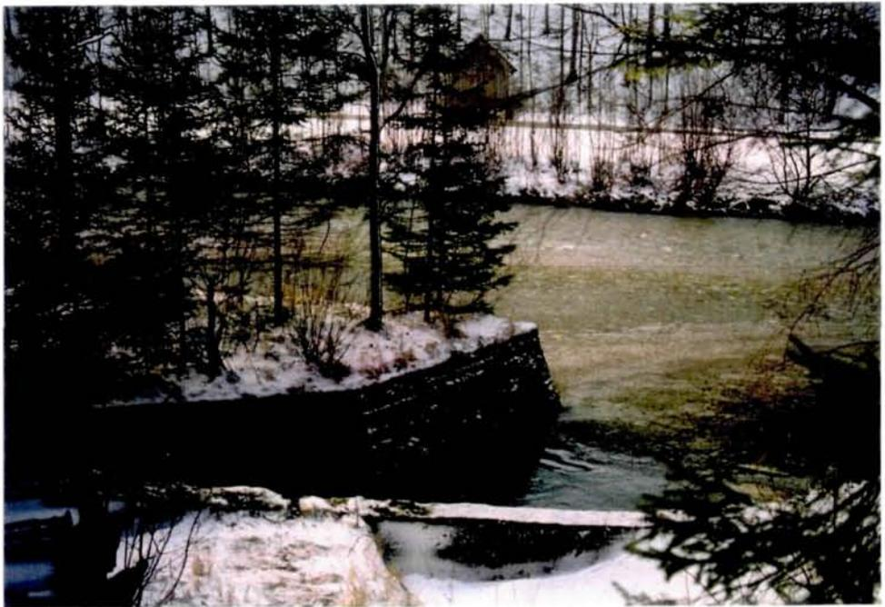
Abb. 20: Einmündung des 14 m langen Unterwasserkanales des E-Werkes in die Alm. In diesem Bereich sind die Uferböschungen beiderseits gemauert.
