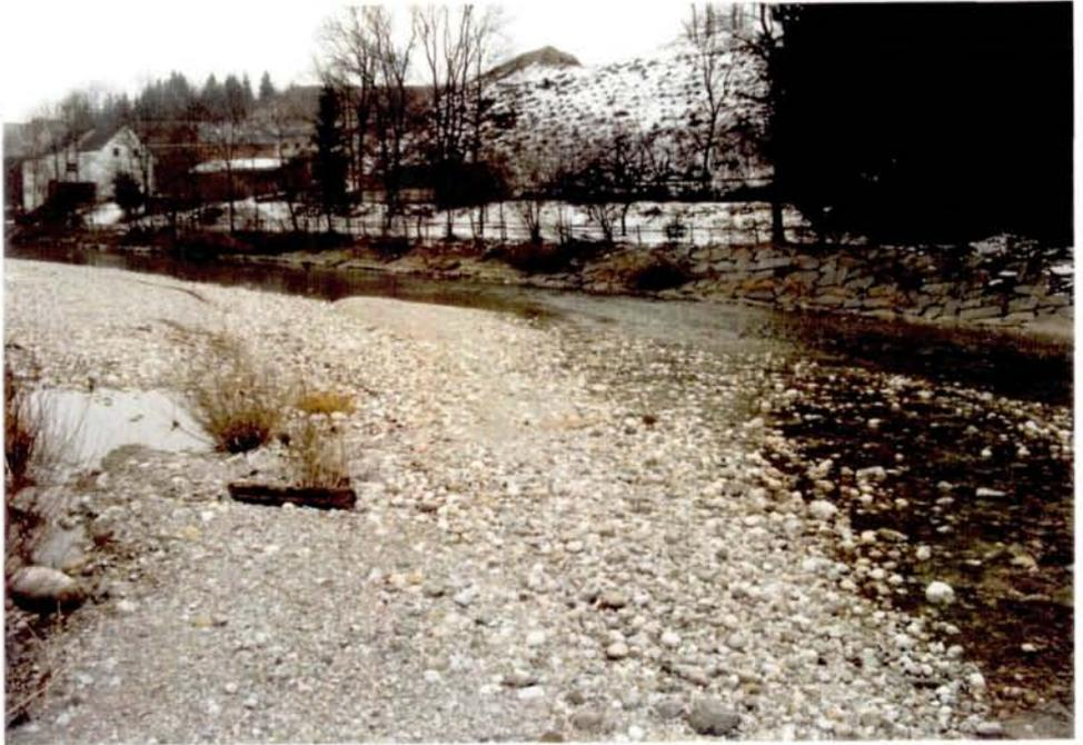
Abb. 105: Das rechte Almufer ist unterhalb der Wehranlage ebenfalls mit Granitsteinen gesichert
