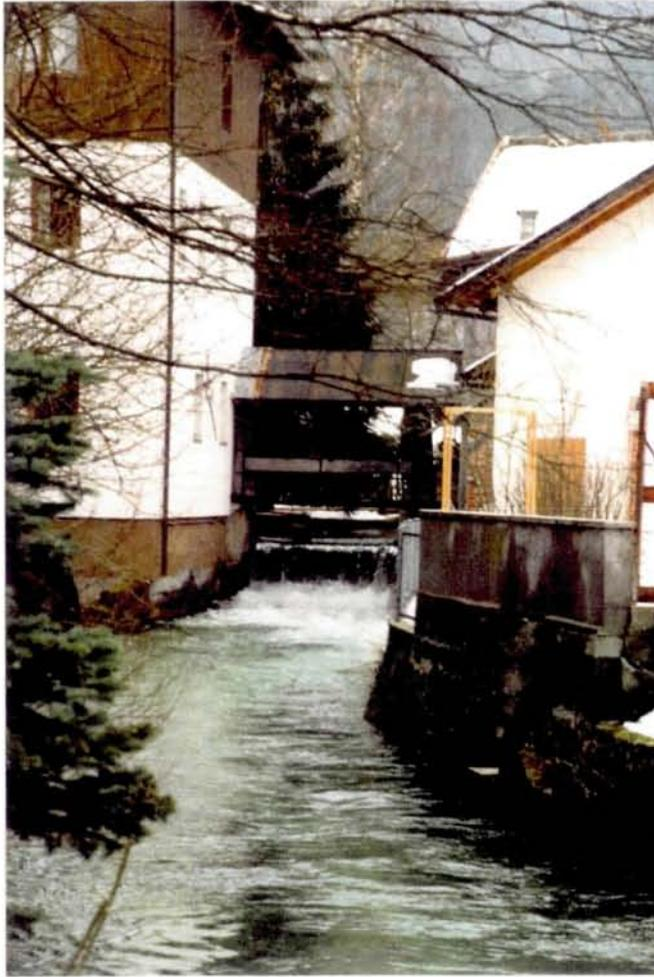
Abb. 38: Auslauf des E-Werkes II. Aufgrund der engen Verbauung im Ortszentrum von Grünau sind die Uferböschungen mit Steinen aufgemauert. Teilweise schließen sich Gärten aber auch Wohnhäuser an.
