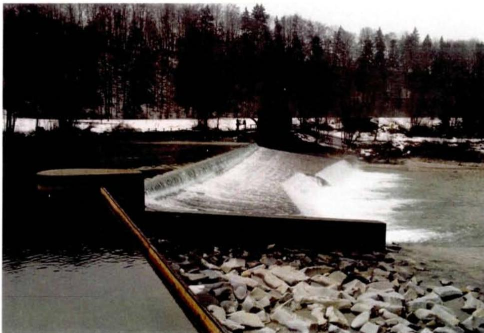
Abb. 89: Die mit Granitblöcken befestigte Wehranlage
