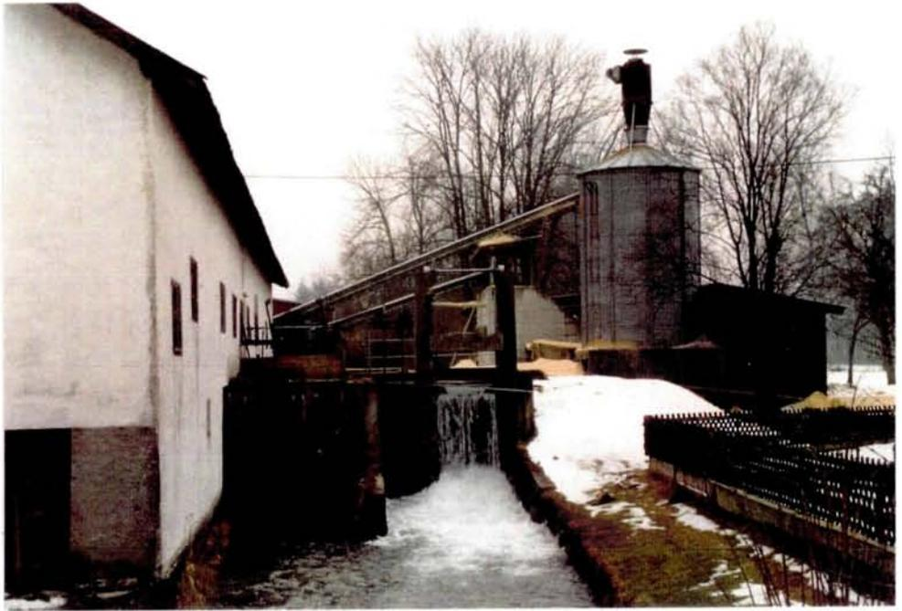
Abb. 112: Überschußgerinne und Auslaufbauwerk der Sattelmühle
