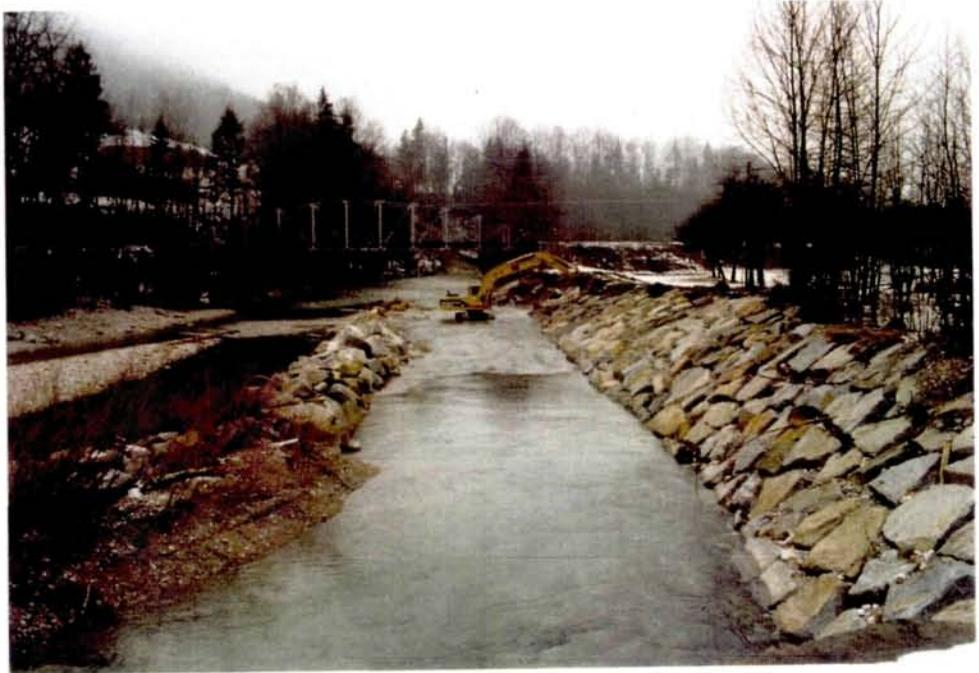
Abb. 87: Die durch Granitblöcke gesicherten Uferböschungen am rechten Ufer des Unterwasserkanales
