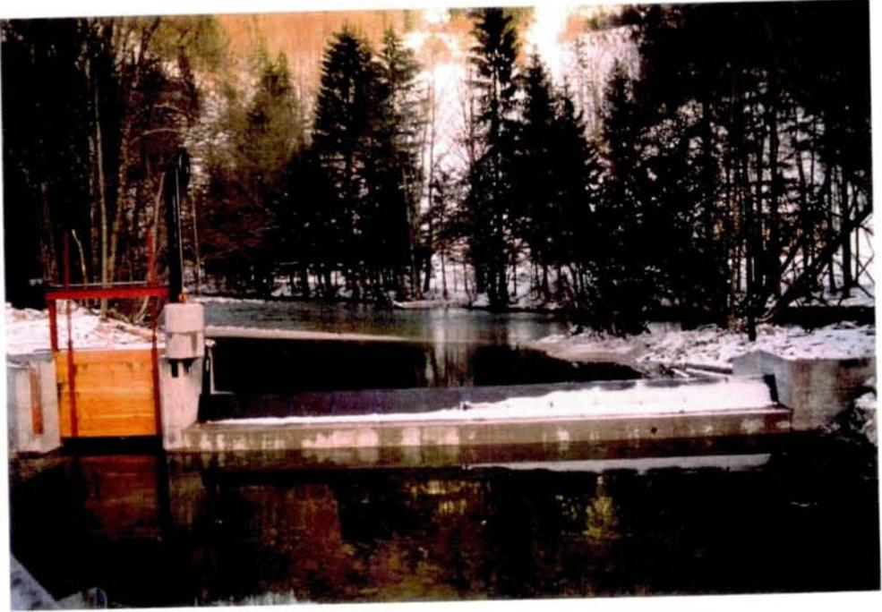
Abb. 23: Diese 2. Wehranlage, die unterhalb der Wehranlage von Abb. 22 liegt, bildet die Ausleitungsstelle des Oberwasserkanales der Rinnbachsäge.
