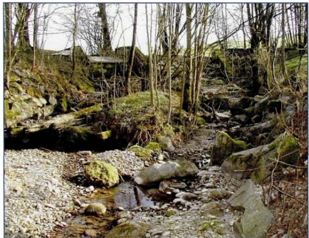
Abb. 53: Steilwehr am Weißenbach, das eine etwa 400 m lange, trockene Restwasserstrecke bedingt.
