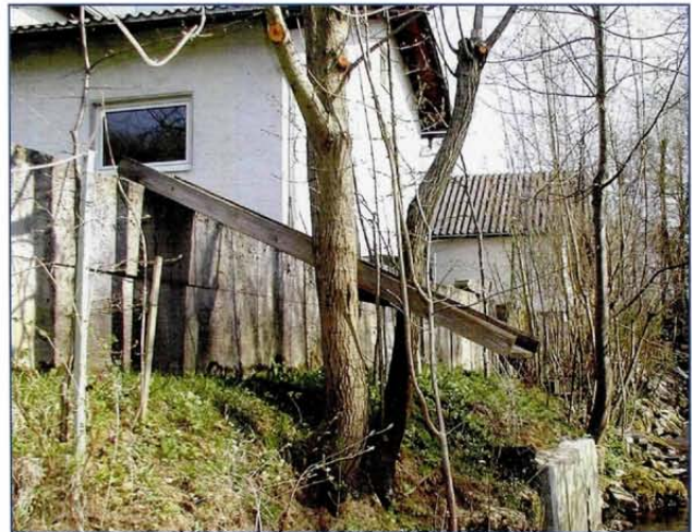
Abb. 52: Uferböschungen und Abfallrutsche am Feyreggerbach direkt im Siedlungsgebiet.
