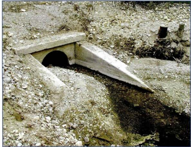
Abb. 21: Der Zufluss aus Mayrhof wurde durch die Verrohrung als aquatischer Lebensraum zerstört.
