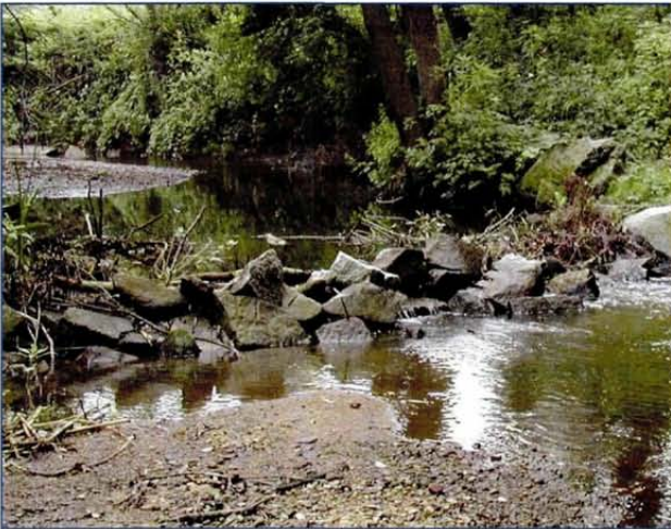
Abb. 6: Querbauwerke, die von einer Vielzahl kleiner Wasserkörper durchströmt sind, sind für Fische unpassierbar (Foto: Kl. Gusen).
