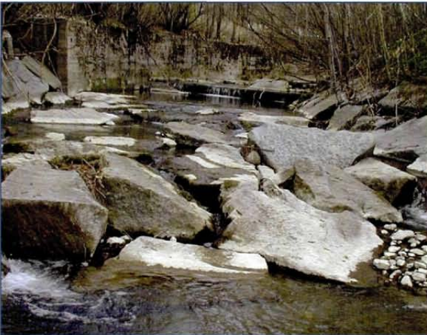
Abb. 7: Verliert sich der Wasserkörper zwischen großen Blöcken, ist eine Migration nahezu unmöglich.
