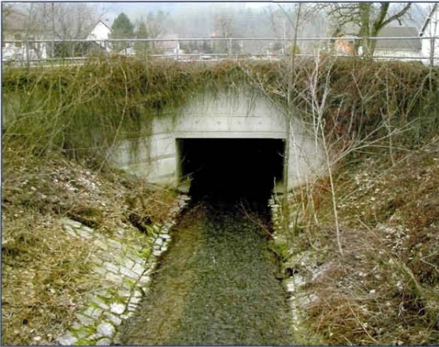
Abb. 29: Durch diesen etwa 100 m langen Kastendurchlass mündet der Seilerbach in die Krems.
