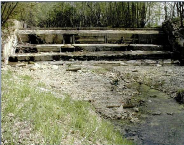
Abb. 41: Wehr der Neumühle in Bad Hall und daran anschließende trockene Restwasserstrecke des Sulzbaches.
