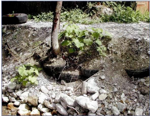
Abb. 15: Eine aus gewässerökologischer Sicht unvertretbare Ufersicherung mittels Altreifen im Kreams- Oberlauf.
