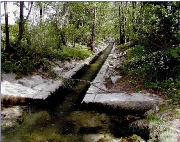
Abb. 69: Bei Kirchdorf ist die Krens zur Gänze in einem Betonbett gefasst.
