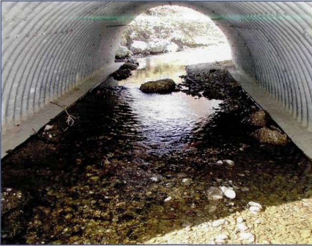
Abb. 35: Querbauwerk Nr. 4-6 im Dambach, ein sohloffener Rohrdurchlass.
