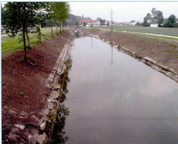
Abb. 3: Sanierung bei Grieskirchen, freigelegte Pflasterung
