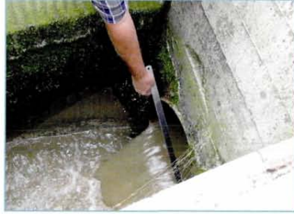
Abb 3: Teilgefüllter MID des Hauptsammlers Attnang, geprüft wurde mit Doppler Ultraschallmessung
