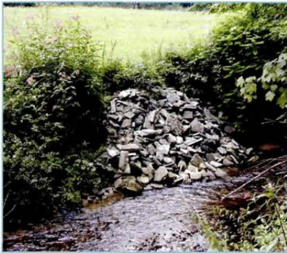
Abb. 16: "Ufersicherung" durch Bauschutt (Foto: Gumpinger).
