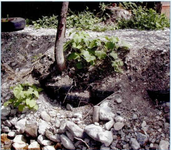
Abb. 17: "Ufersicherung" (?) (Foto: Gumpinger).
