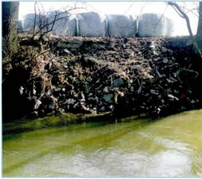
Abb. 18: Bauschutt-Ablagerung und Lagerung von Siloballen.
