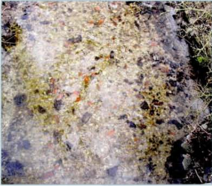
Abb. 6: Verschmutzungsgrad Bauschutt 3 = starke Verunreinigung.
