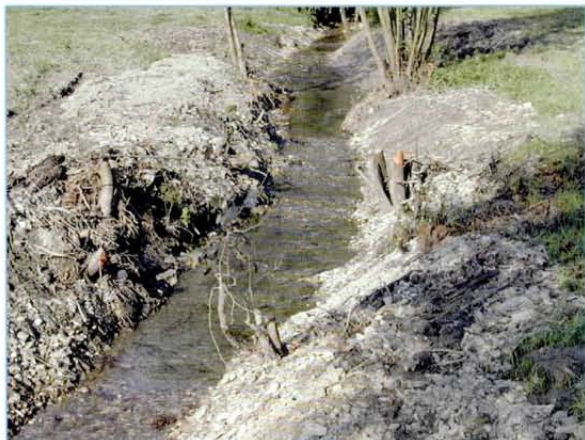
Abb. 5: Ausgeräumte Bachsohle des Kaltenbaches bei der Landesstraßenbrücke nach Aigen.
