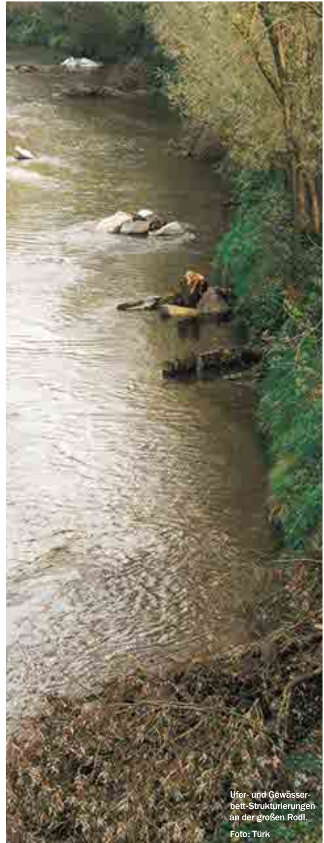
Belebungs-element als Holzpiloten mit Querhölzern (Rundlinge) – in V-Form mit der Spitze bachaufwärts gerichtet
