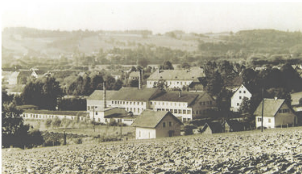
Blick auf die Betriebsanlage mit den beiden Schornsteinen.
