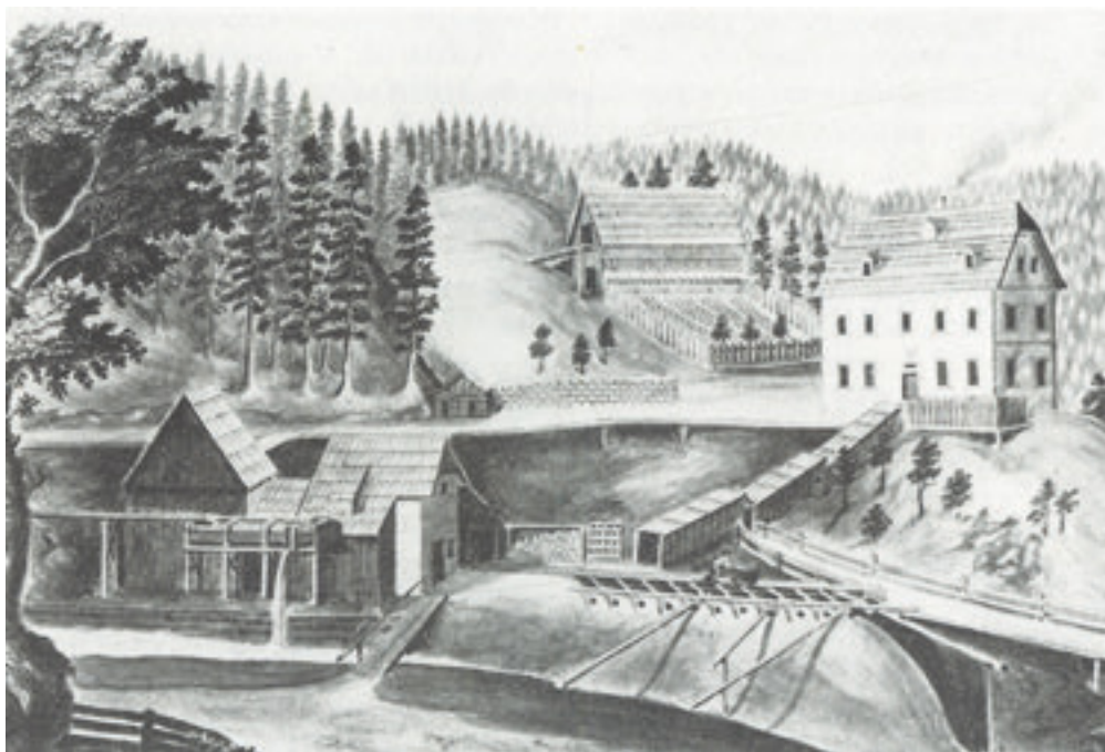
Betriebsstandort beim Maria-Theresia-Stollen.
