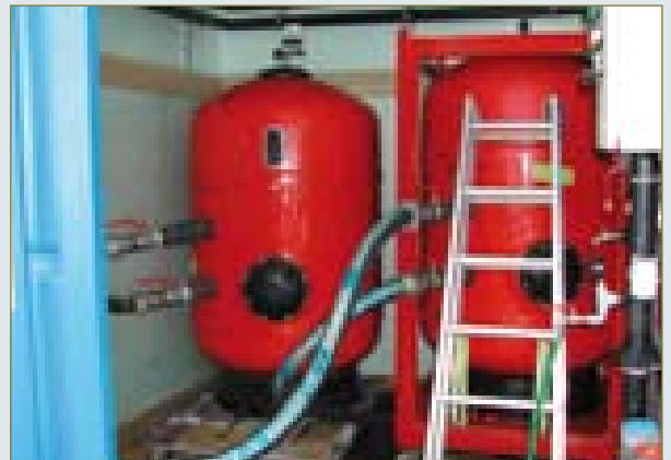
Abb. 6-5: Aktivkohlebehälter im Container
