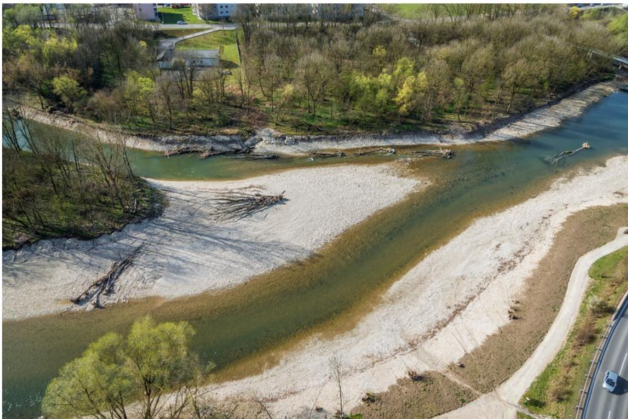
**Abbildung 1-19: Gelungene, am flussmorphologischen Leitbild orientierte Aufweitung an der Ybbs**
