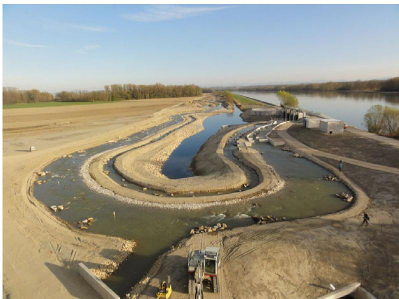
**Abbildung 1-13: Bauwerk zur dynamischen Dotation der „Flutmulde Machland“ mit „asymmetrischem Raugerinne“. Dieser Bautyp kann allen Vertretern der artenreichen Fischfauna einen Aufstieg ermöglichen**
