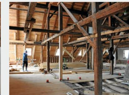
Bild links: Steegwirt vor Sanierung, Bild mitte u. rechts: Renovierung Holzdecke und Dachstuhl, Fotos © Steegwirt
