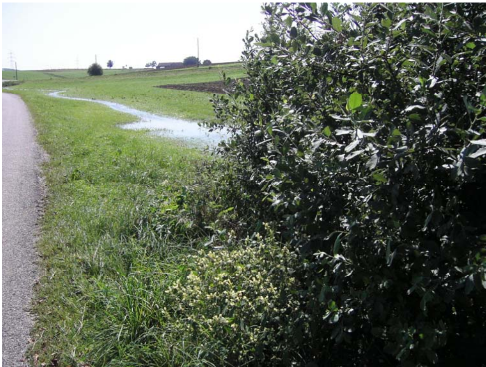
Abb. 7: "Übergelaufener" Drainagegraben (Foto: Mag. Thomas Anzböck)
