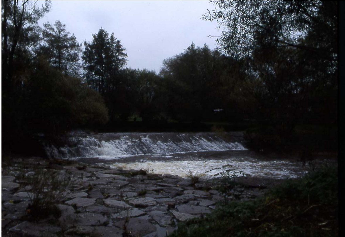
Abb. 3: Sohlverbauung der Großen Rodl. (Foto: Fa. Lebensraum)
