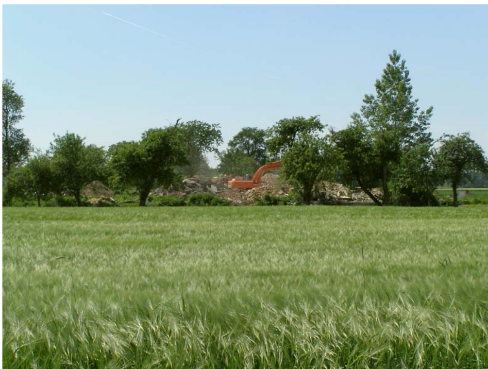
Abb. 5: Abbruch eines ausgesiedelten Hofes bei Straß (Foto: AVL)
