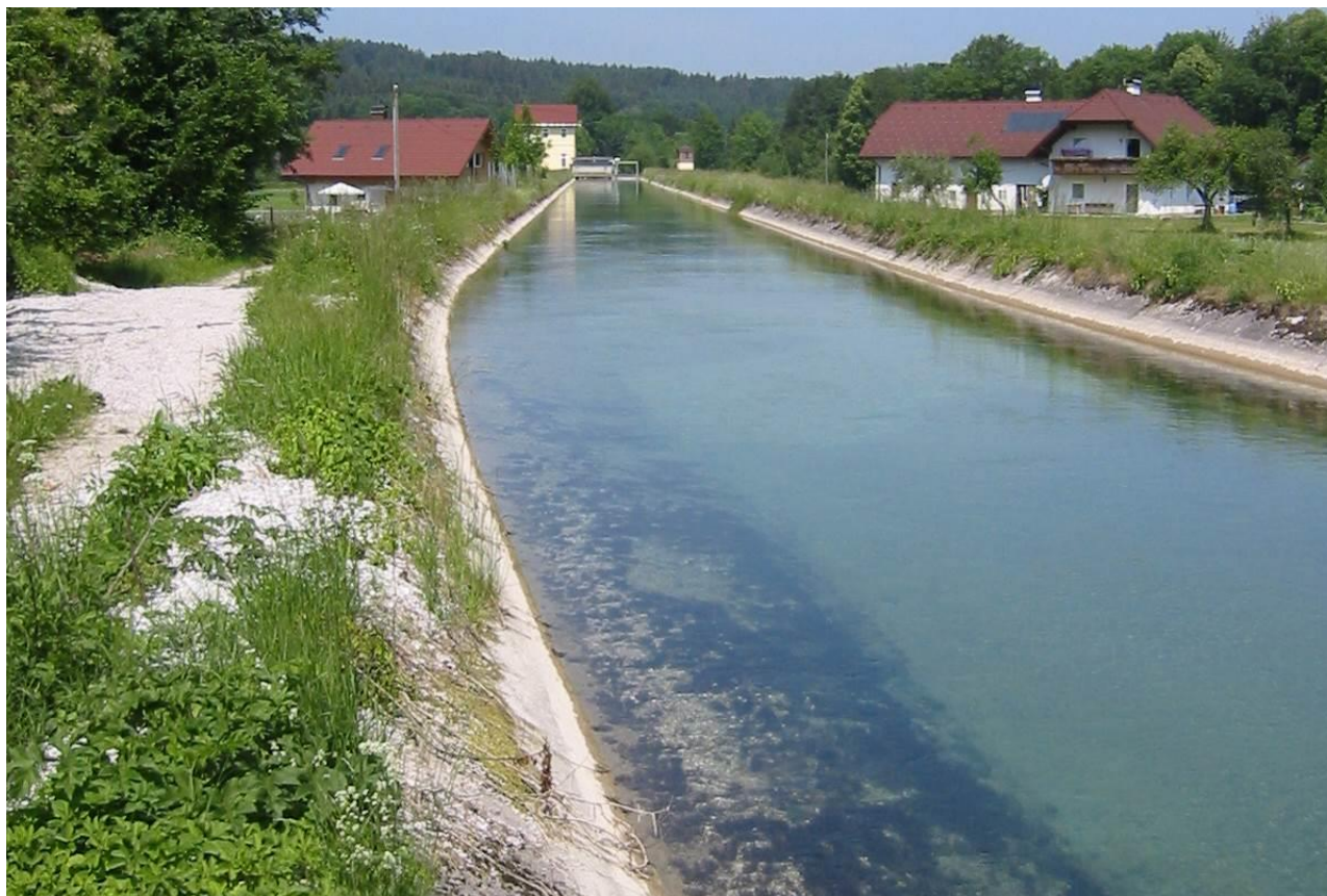
Abbildung 26: Ausleitung der Alm für das Kraftwerk Gries im Norden der Gemeinde.
