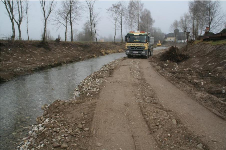
Abb. 11: Baustraße im Bett der Fuschler Ache zum Abtransport des angelandeten Materials mittels LKW.
