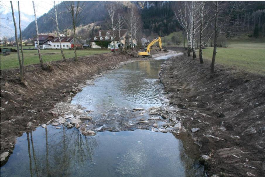
Abb. 16: *Geräumte Böschungen und Sohle der Fuschler Ache im flussaufwärtigen Baustellenabschnitt.*
