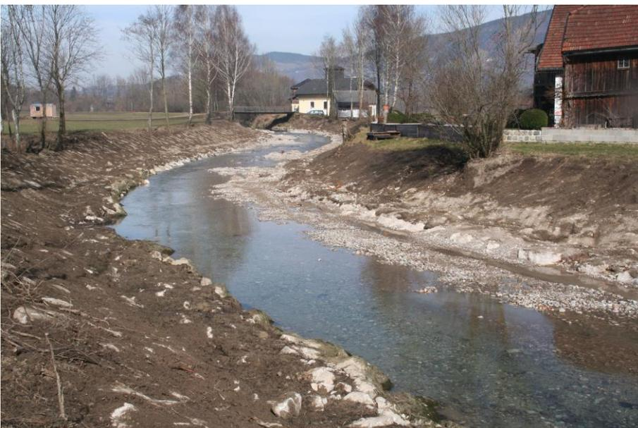
Abb. 17: *Schotter und Buhnen als Strukturmaßnahmen im geräumten Abschnitt der Fuschler Ache.*
