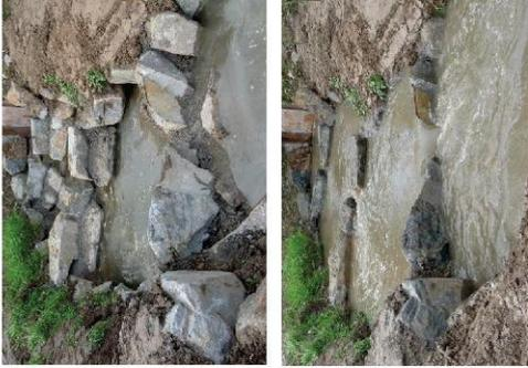
Beispiel für Steinschwellen mit passierbaren Schlüzen ohne Wasser (Bild oben) und mit Wasser (Bild unten)
