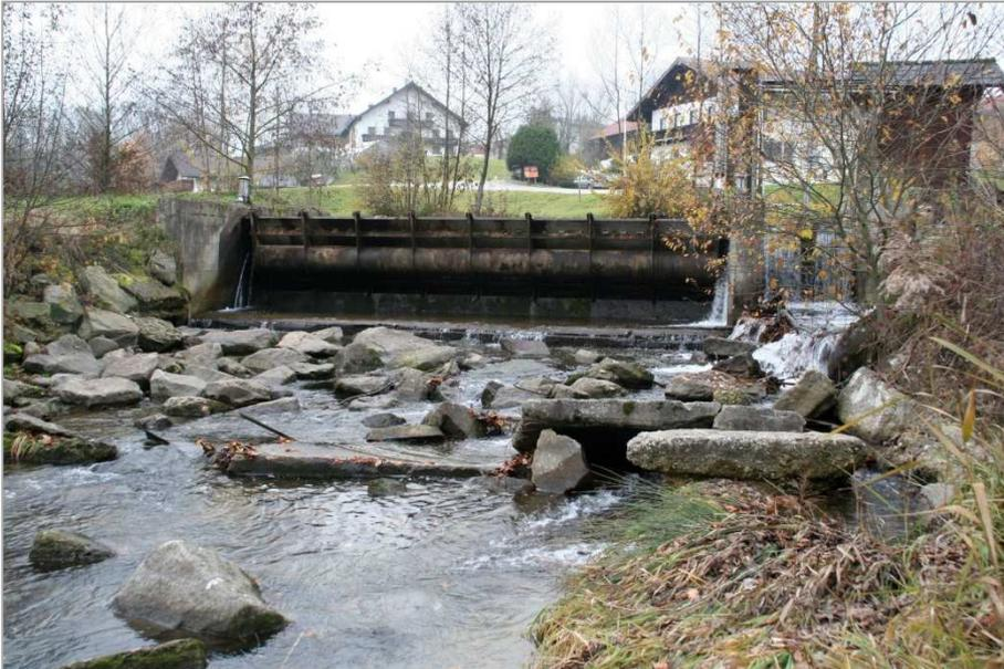
Abb. 76 Unpassierbares Ausleitungsbauwerk in der Mattig bei Kerschham mit funktionslosem Fischaufstieg.
