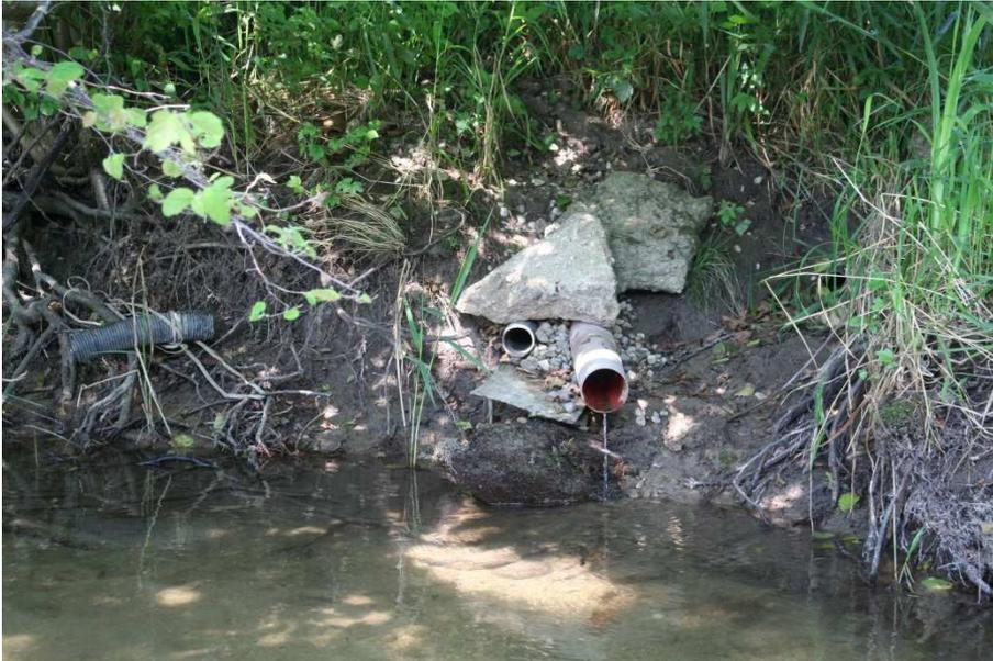
Abb. 77 Drainagen verändern die Hydrologie eines Gewässers und sind eine Quelle für Feinsediment, Schad- und Nährstoffe im System.
