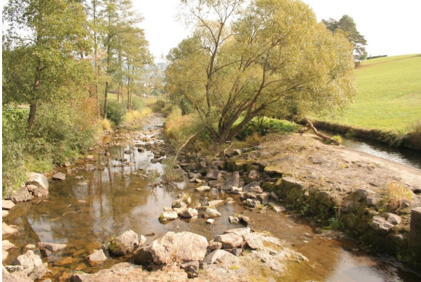
Abb. 59: Flussbauliche Veränderungen an der Großen Mühl: rechts Kanal mit Großteil des Wassers, links Restwasserstrecke, nur schwach dotiert. (Foto: B. Thurner)
