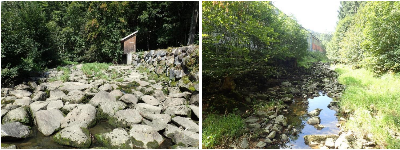
Abbildung 5: Totalausleitung am Schrägwehr der Furthmühle (links) und grobes Sohlsubstrat in der zum Begehungszeitpunkt nicht dotierten Restwasserstrecke im Bereich der Fa. Pühringer (rechts).
