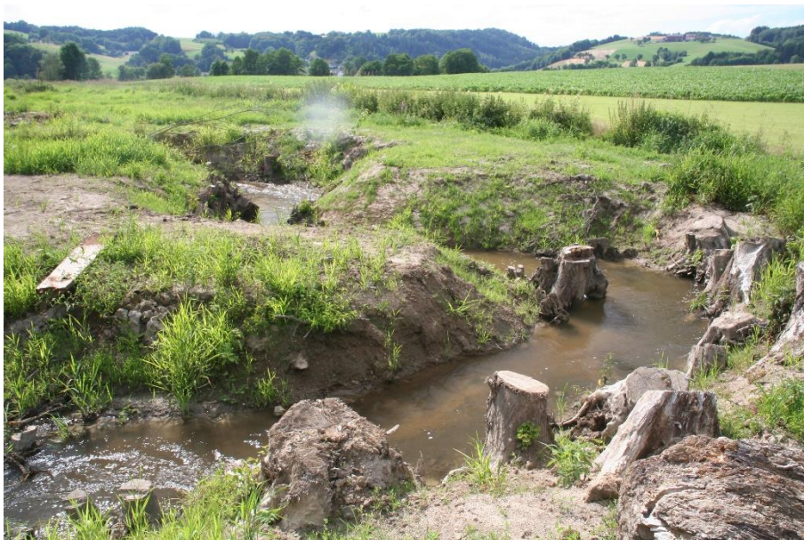
Abbildung 44 Naturnahe Morphologie der Organismenwanderhilfe an der Schörgendorfermühle als hochwasserunbeeinflusster Gewässerabschnitt.
