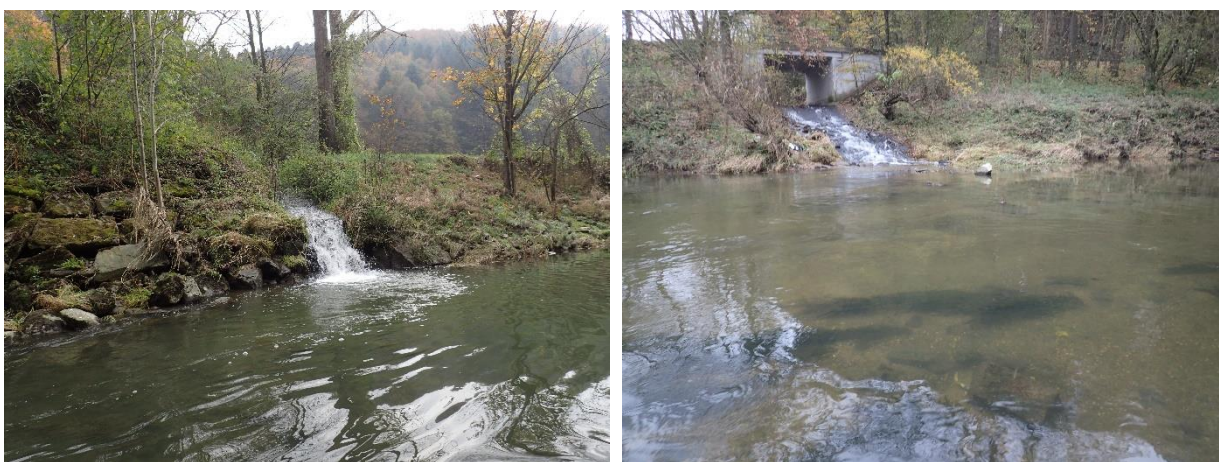
Abbildung 23: Unpassierbare Mündungsrampe des Reithbachs (links) und Ritzingerbachs (rechts) in die Aschach.
