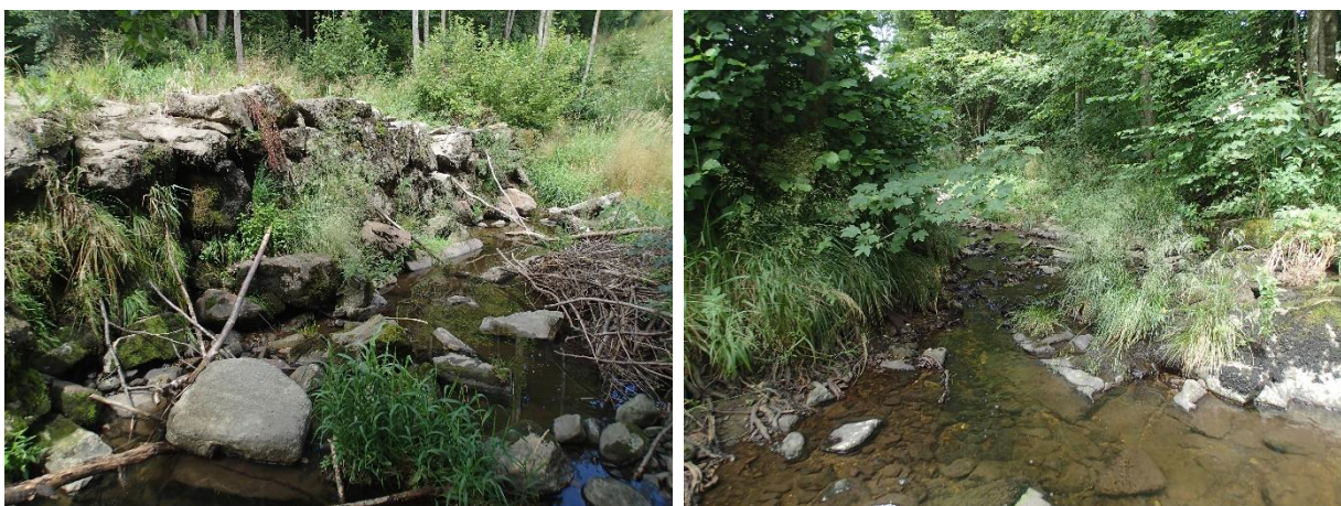
Abbildung 42 Entnahmebauwerk (links) und nicht ausreichend dotierte Restwasserstrecke (rechts) der Scheuchermühle im Sandbach bei Eschenau im Hausruck.
