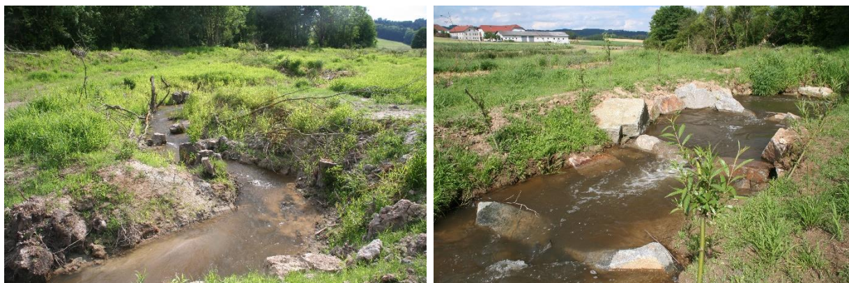
Abbildung 33: Naturnaher (links) und als Beckenpass ausgeführter Abschnitt (rechts) der Organismenwanderhilfe an der Schörgendorfermühle.
