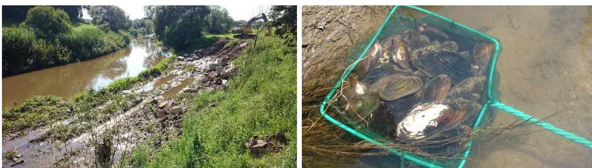
Abbildung 45 Bauarbeiten im Absenkungs- und Aufweitungsbereich der Aschach flussab der Sandbachmündung (links) und ein kleiner Teil der aus diesem Abschnitt vor dem Eingriff ins Gewässer geborgenen Großmuscheln (rechts).
