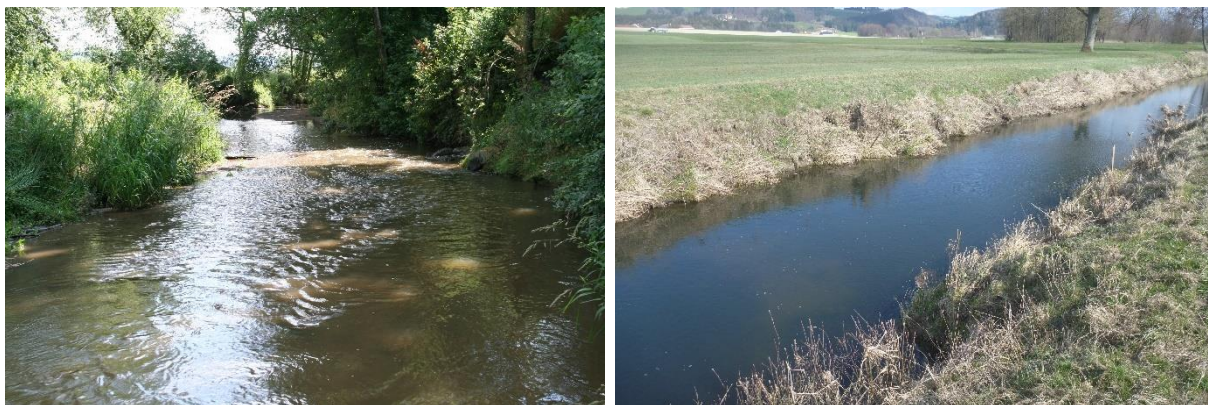
Abbildung 7: Naturnaher und morphologisch diverser Abschnitt flussab von Schörgendorf (links) und Regelprofil im Leitenbach mit wiederkehrenden Querbauwerken zur Sohlstabilisierung (rechts).
