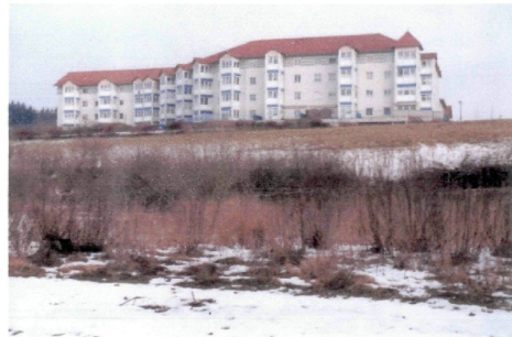
Abb. 55: Der Kontrast der Wohnblöcke zum hier weitgehend natürlich verlaufenden Grundbach wirkt bedrohlich.
