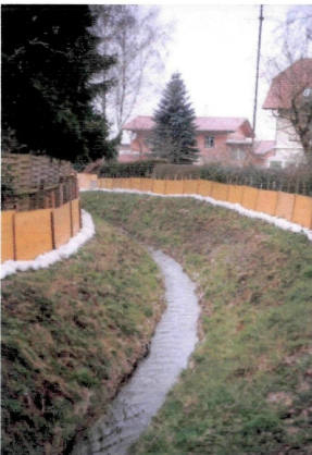
Abb. 34: In Breitbrunn war der regulierte Theninger Bach im Dezember 2002 noch von Sandsäcken und Zäunen des Hochwasserschutzes begleitet.
