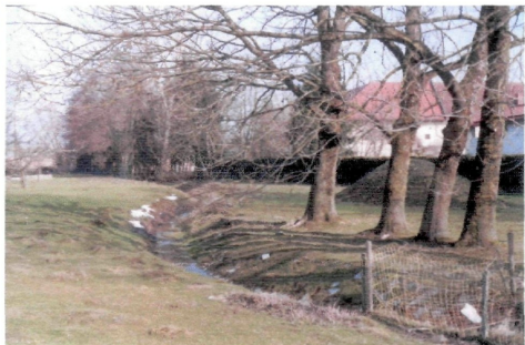
Abb. 30: Das Endstück des Bucherbaches in einer Schafweide in Breitbrunn ist massiv gestaltet.
