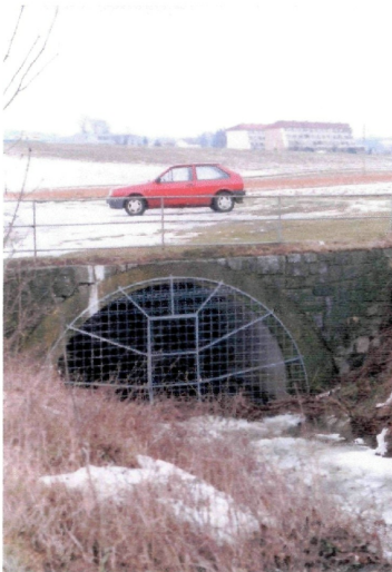
Abb. 60: Hier verschwindet der Grundbach endgültig im Kanalsystem.
