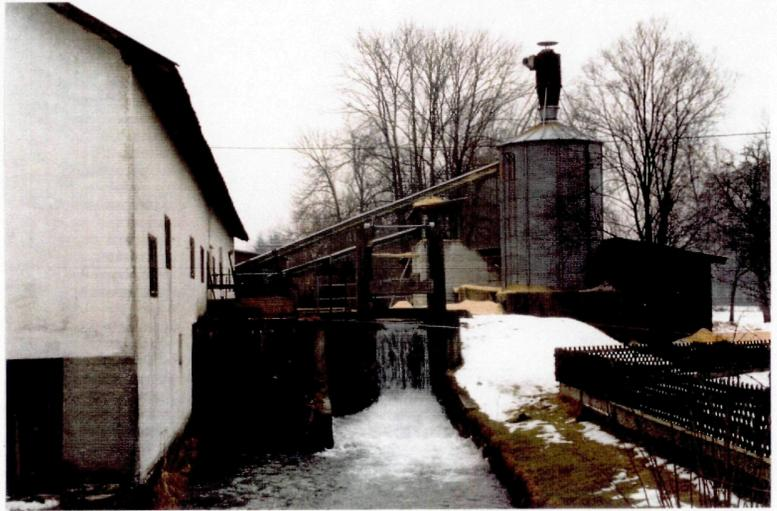
Abb. 112: Überschußgerinne und Auslaufbauwerk der Sattelmühle
