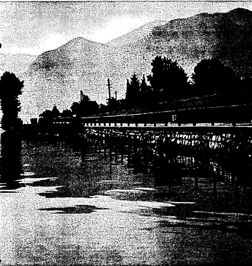
Harte Uferböschung längs einer Straße
