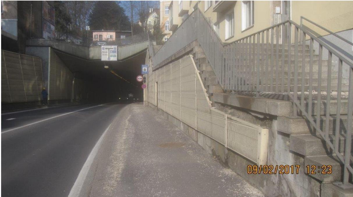
Die bestehenden technischen Anlagen des Römerbergtunnels entsprechen nicht mehr dem heutigen Stand der Technik. Es sind Sanierungen bei der bestehenden Betriebszentrale beim Südportalkranz sowie bei der Stiegenanlage geplant und im Bereich des Tunnelnordportals die Adaptierung der Tunnelentwässerung notwendig.
