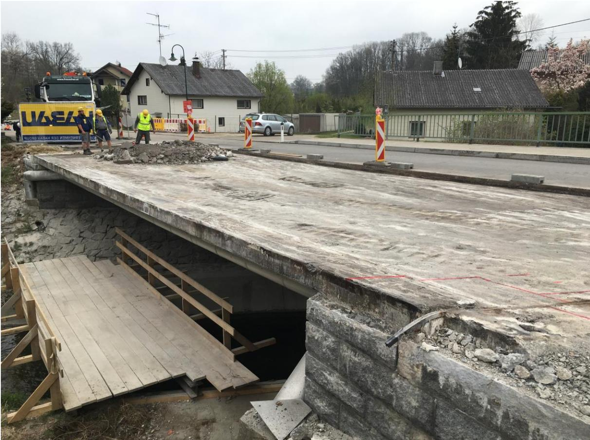
Gurtenbachbrücke – erste Brückenhälfte, Abtrag des Bestandes Oberbau
