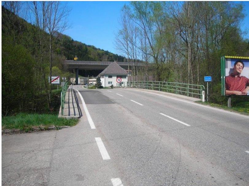
Die 1973 errichtete Brücke muss wegen des sanierungsbedürftigen Erhaltungszustandes instandgesetzt werden. Es ist vorgesehen, dass die Brückenausrüstungen (Geländer, Entwässerungen) sowie die Randbalken, der Fahrbahnbelag und die Brückenabdichtung neu hergestellt werden. Die Verkehrsaufrechterhaltung während der Bauzeit erfolgt wechselseitig einstreifig mit Ampelregelung über den Bestand.
