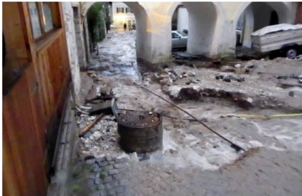
Hochwasserereignis in Hallstatt am 18. Juni 2013, Vermurung
