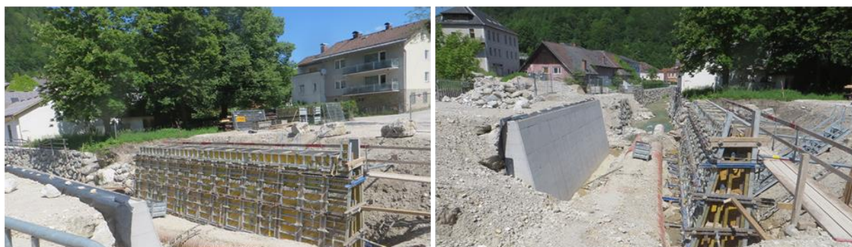
Widerlager für die Brücke an der B121 Weyerer Straße: hierbei handelt es sich um eine Brücke, die später einen Bestandteil der Umfahrung Weyer darstellt
