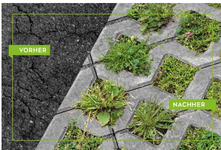
Vorher Asphalt, Nachher Entsiegelung mittels Rasengittersteinen (Fotomontage)
