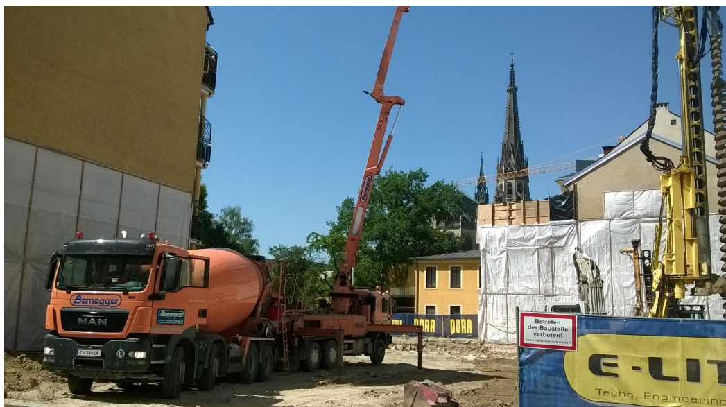
Tiefgarage und Innenhofbebauung Herrenstraße/Wurmstraße (Foto: Land OÖ)
