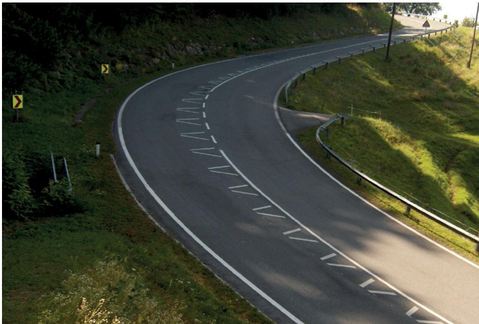
Abbildung 8: Bodenmarkierungen zur Erhöhung der Fahrsicherheit (Quelle: KfV)
