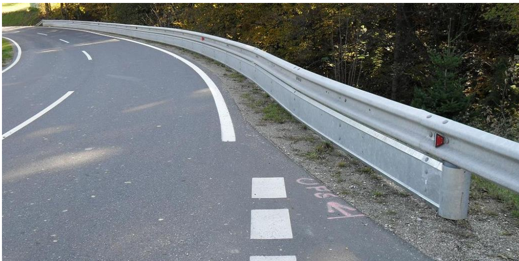
Abbildung 7: Beispiel eines Motorrad-Unterfahrschutzsystems (Quelle Land OÖ)
