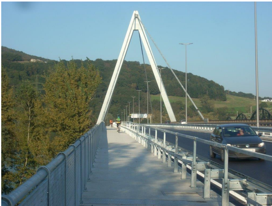
Abbildung 3: Donaubrücke Steyregg Quelle: (Land OÖ)
