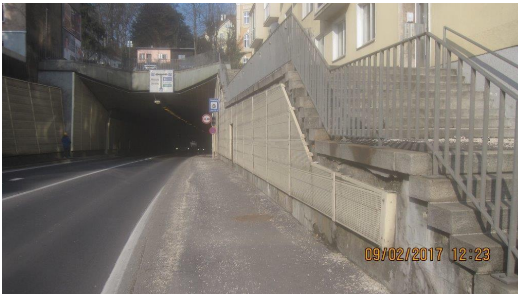
Abbildung 4: Römerbergtunnel Quelle: (Land OÖ)
