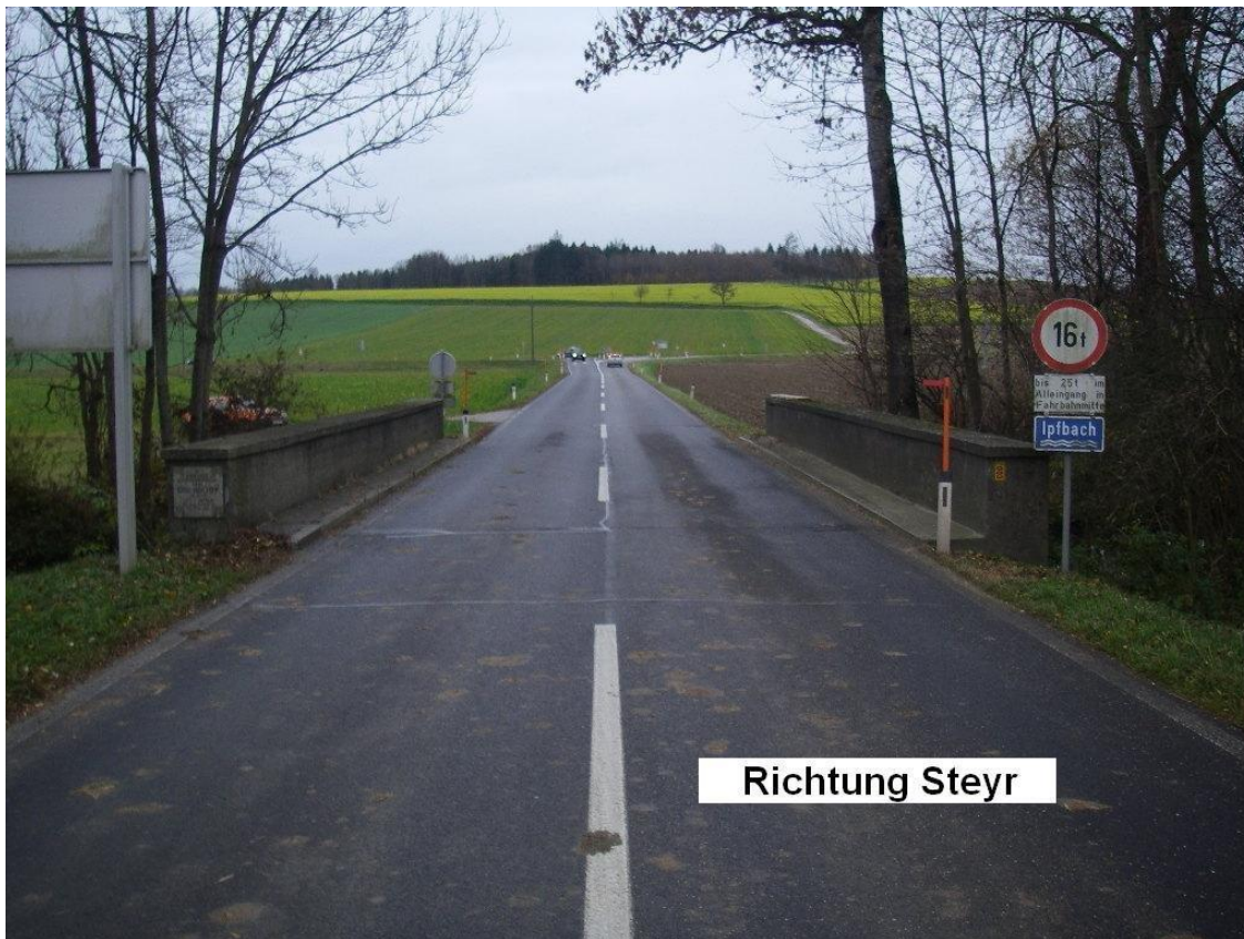
Abbildung 5: Ipfbachbrücke Enzing Quelle: (Land OÖ)
