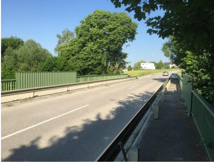
Abbildung 2: Bahnunterführung Neumarkt-Braunau Quelle: (Land OÖ)
