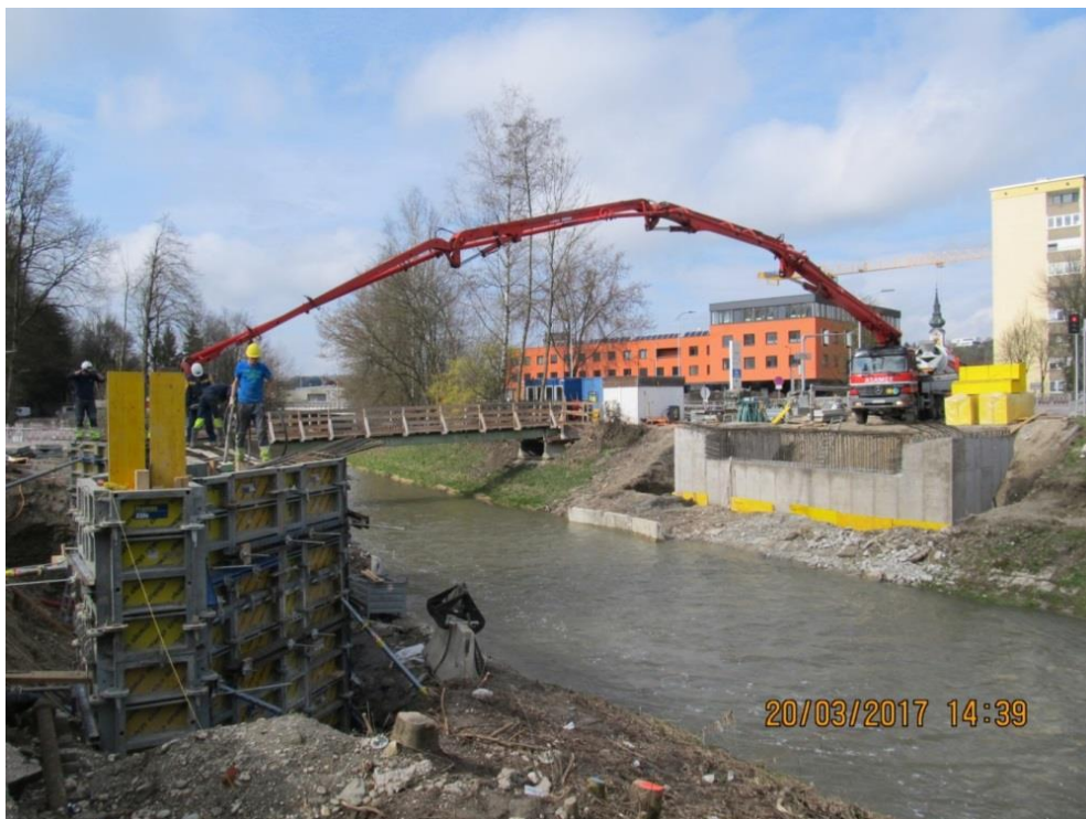
Abbildung 9: Trattnachbrücke Quelle: (Land OÖ)
