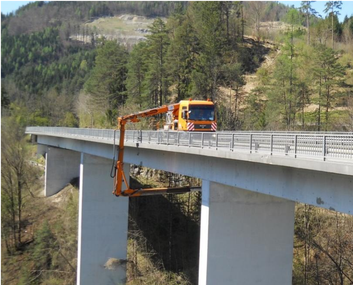
Abbildung 3: Im Einsatz ist ein sog. MOGG – Das Brückeninspektionsgerät des Landes OÖ Quelle: Land OÖ
