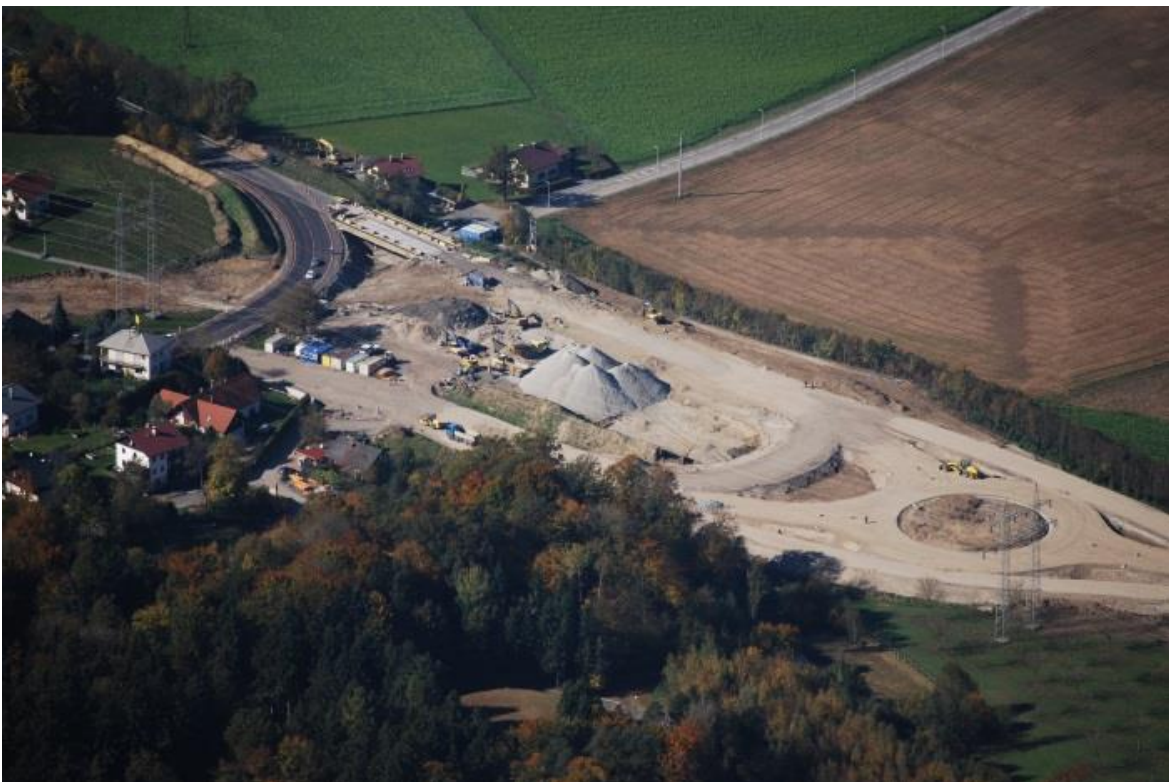
Abb. 6: Baumaßnahmen am Kreisverkehr - Quelle: Land OÖ
