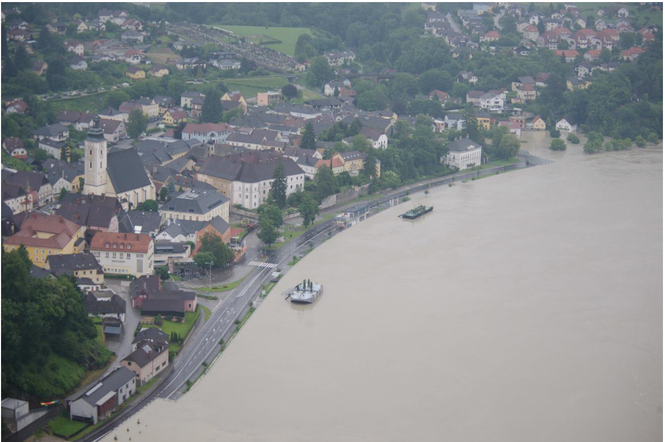
Grein 2013, durch den mobilen Hochwasserschutz geschützt (Quelle: Bundesheer)
