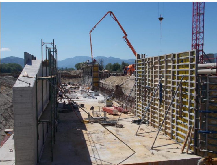
Betonarbeiten für den Grundablass am RHB Krems-Au (Quelle: Gewässerbezirk Linz)
