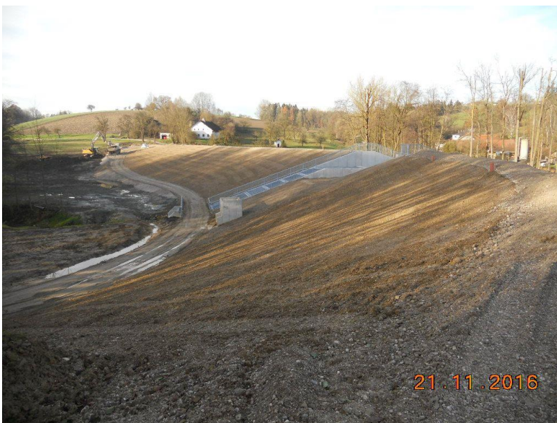
Während der Bauarbeiten am RHB Gebersdorferbach (Quelle: Gewässerbezirk Grieskirchen)
