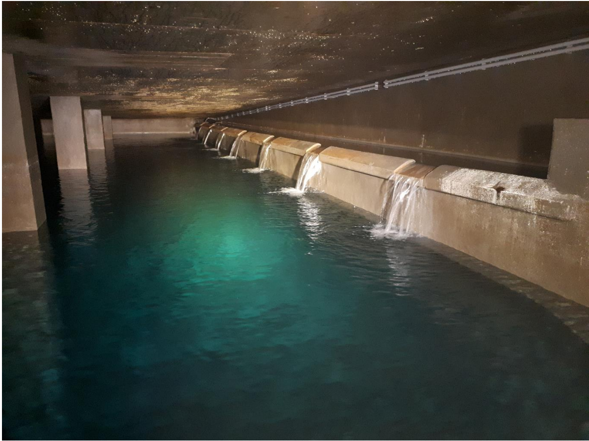
Bild 1: Wasserbehälter (Quelle: Land OÖ)
