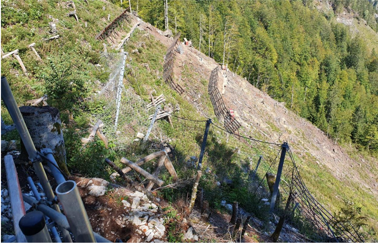
Abb. 9 Quelle: WLV Lawinverbauung in Oberlaussa zum Schutz der Hengstpass Landesstraße
