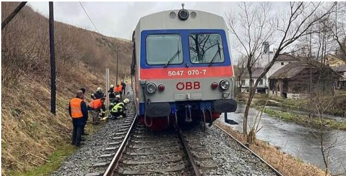
Abb. 2 Quelle: PI Neuhofen Beinahe stürzt die Mühlkreisbahn in die Große Mühl
