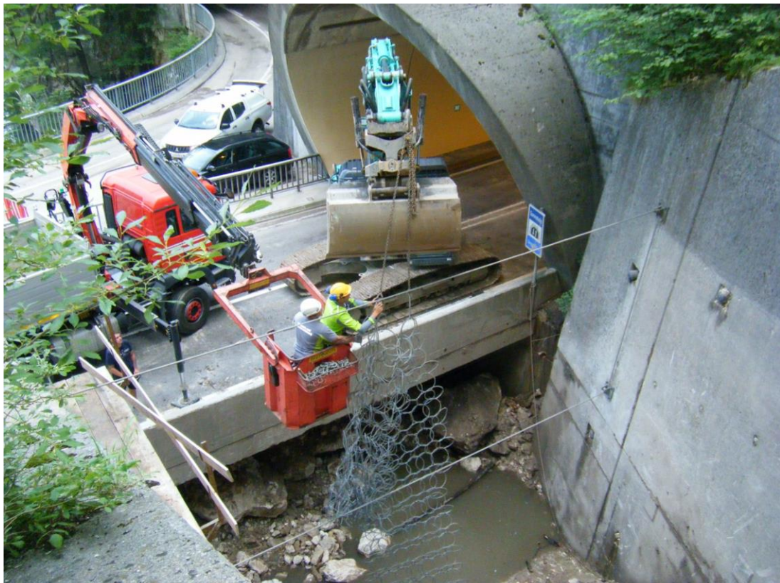
Abb. 8 Quelle: WLW Teufelgraben in Traunkirchen: Montage der Schutznetze nach der Mure auf die B 145 vom Juli 2021
