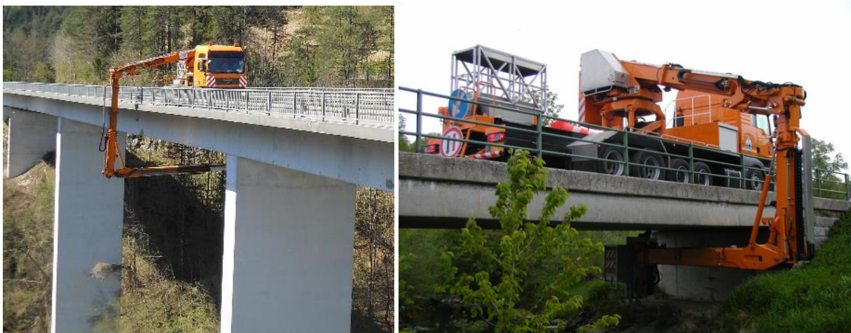
Abbildung 1: Brückenuntersichtsgerät Mogli im Einsatz Quelle: Land OÖ / Direktion Straßenbau und Verkehr
